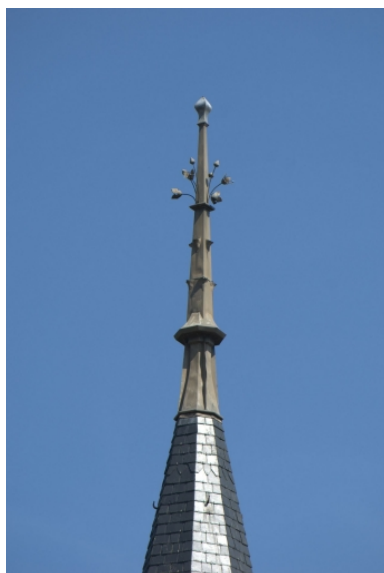
Château, détail, épi de faitage Phot. Norbert Lambart IVR53_20102203031NUCA
