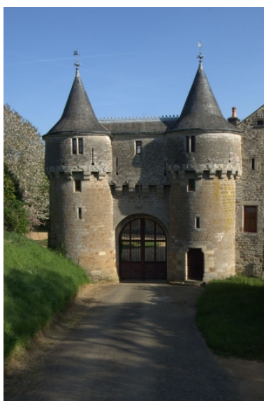
Châtelet d'entrée Phot. Norbert Lambart IVR53_20102202731NUCA
