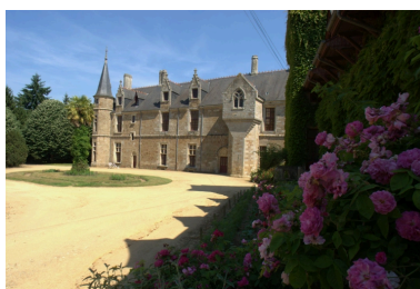
Château, vue générale Phot. Norbert Lambart IVR53_20102203039NUCA
