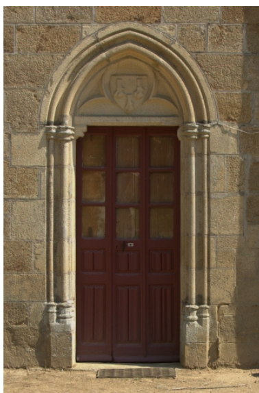
Château, détail, porte Phot. Norbert Lambart IVR53_20102203033NUCA
