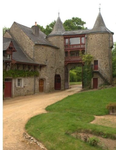
Châtelet d'entrée, vue arrière Phot. Norbert Lambart IVR53_20102202790NUCA
