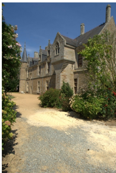
Château, vue générale Phot. Norbert Lambart IVR53_20102203041NUCA
