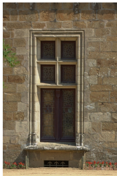
Château, détail, baie Phot. Norbert Lambart IVR53_20102203032NUCA
