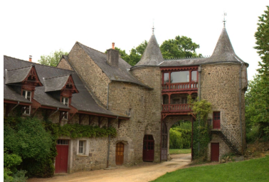
Châtelet d'entrée, vue arrière Phot. Norbert Lambart IVR53_20102202791NUCA
