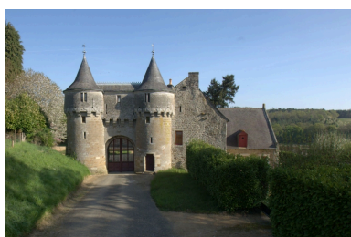
Châtelet d'entrée Phot. Norbert Lambart IVR53_20102202730NUCA
