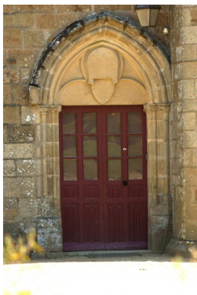
Château, détail, porte Phot. Norbert Lambart IVR53_20102203030NUCA
