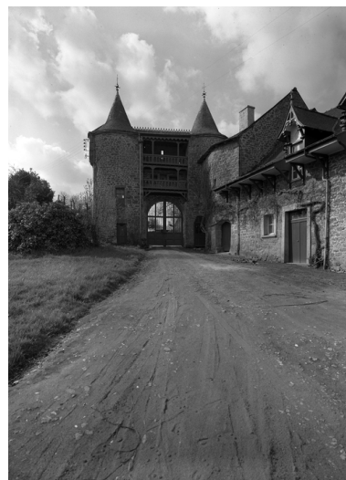
Châtelet d'entrée, façade nord, enquête de 1969 Phot. Guy Artur IVR53_19692200160V
