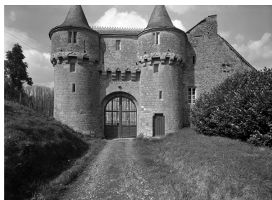
Châtelet d'entrée, vue générale sud, enquête de 1969 Phot. Guy Artur IVR53_19692200157V
