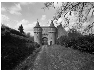
Châtelet d'entrée, vue générale sud, enquête de 1969 Phot. Guy Artur IVR53_19692200158V
