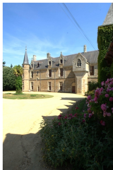
Château, vue générale Phot. Norbert Lambart IVR53_20102203038NUCA
