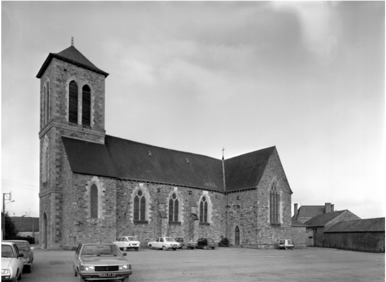
Elévation sud-ouest : vue générale
