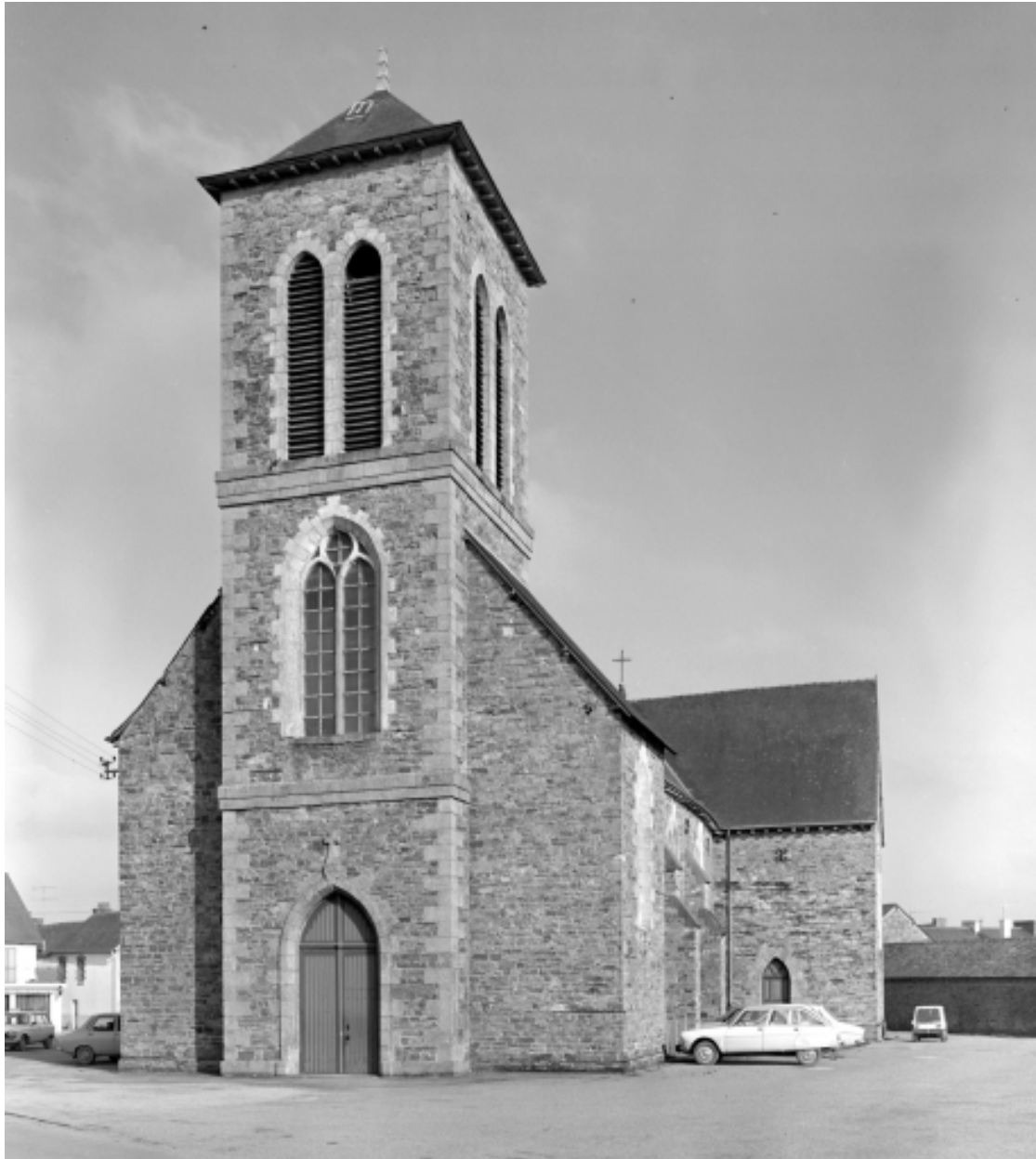
Elévation ouest : vue générale
