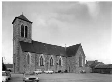
Elévation sud-ouest : vue générale Phot. Guy Artur, Phot. Norbert Lambart IVR53_19823501343V
