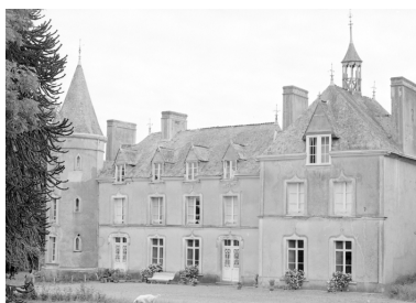
Manoir : élévation ouest (état en 1984) Phot. Guy Artur, Phot. Norbert Lambart IVR53_19845600993X
