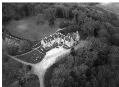
Vue aérienne sud-ouest Phot. G.H.L. IVR53_19825600192V
