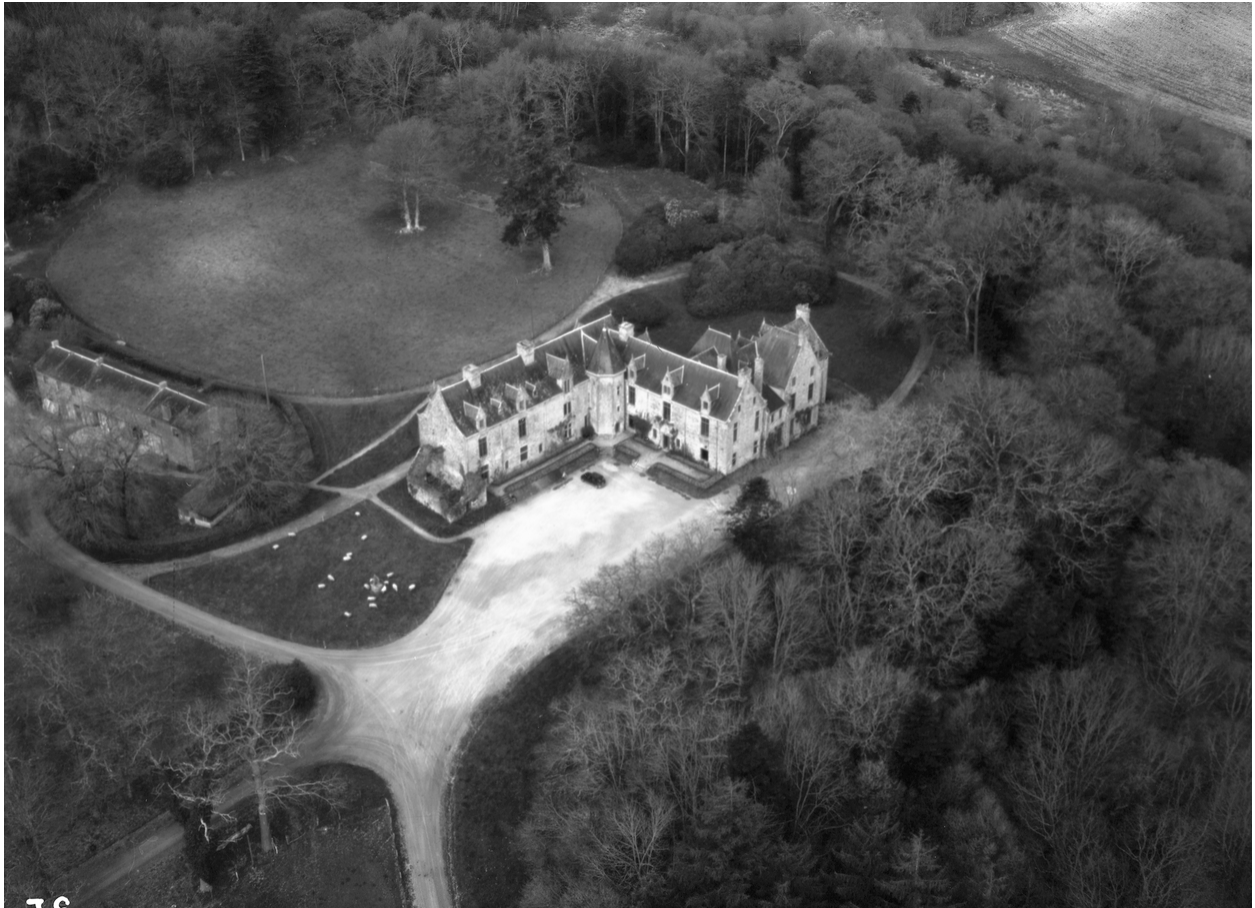
Vue aérienne sud-ouest
