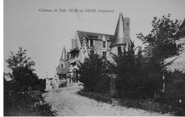
Vue depuis l'arrivée Phot. Elise Lauranceau IVR53_20052904369NUCB
