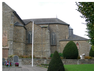
Vue du chevet côté sud Phot. Sabrina Dalibard IVR53_20063512585NUCA
