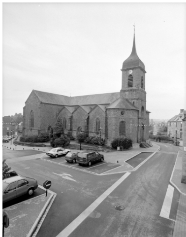
Elévation Nord : vue générale Phot. Guy Artur, Phot. Norbert Lambart IVR53_19943501779X
