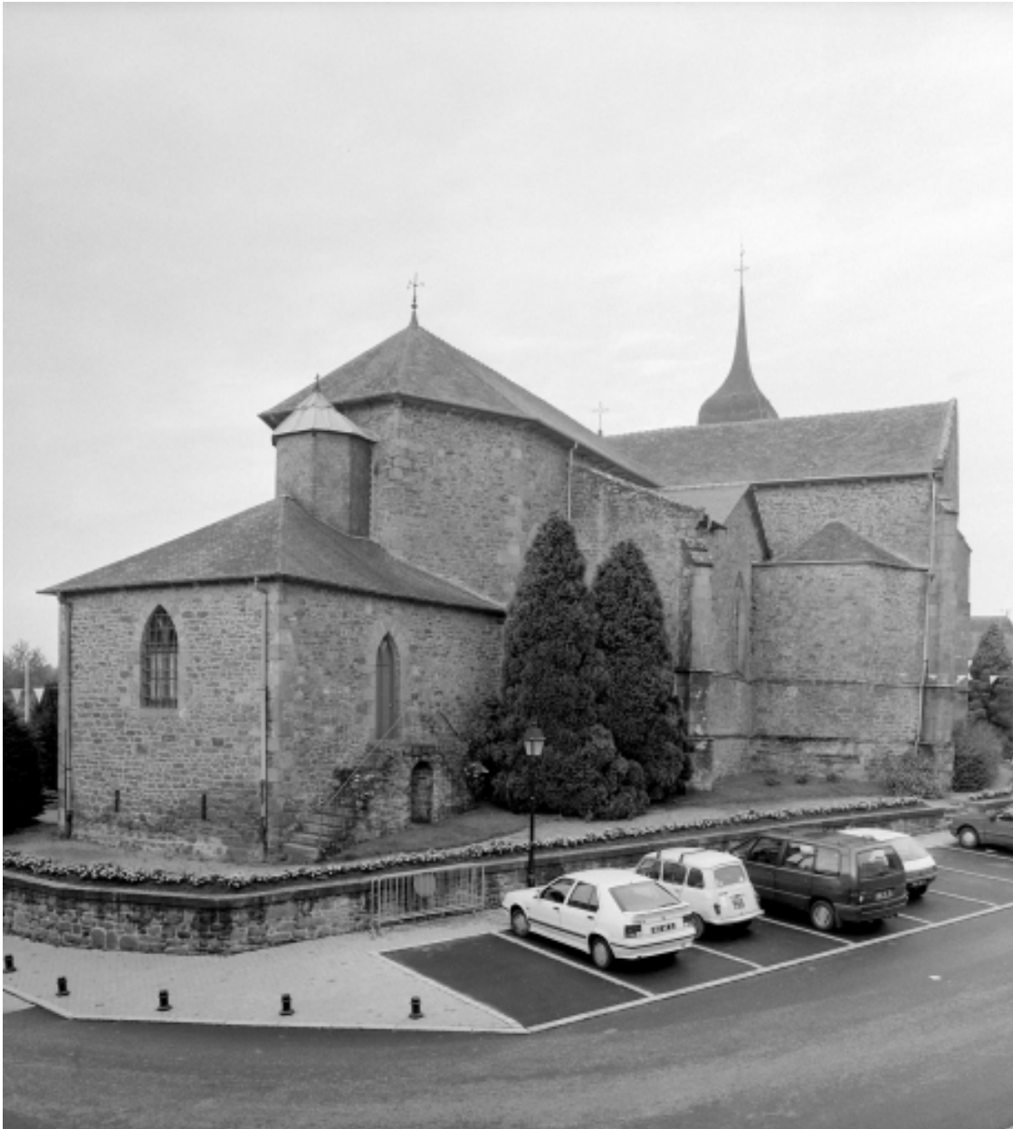
Elévation Nord-Est : vue générale
