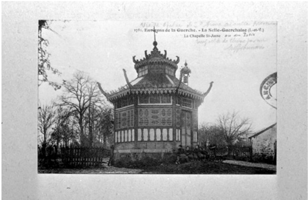
Élévation est : vue générale (carte postale ancienne)
