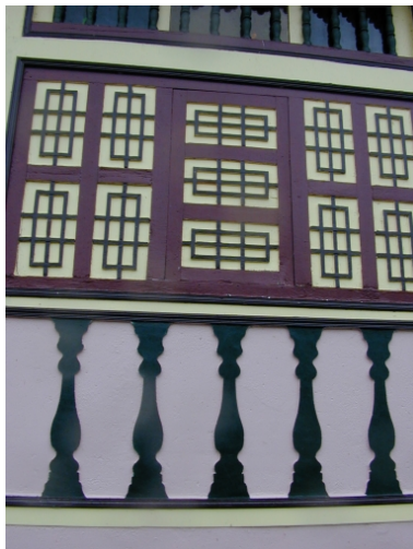
Détail du pan de bois Phot. Vanessa Hue IVR53_20043514389NUCA
