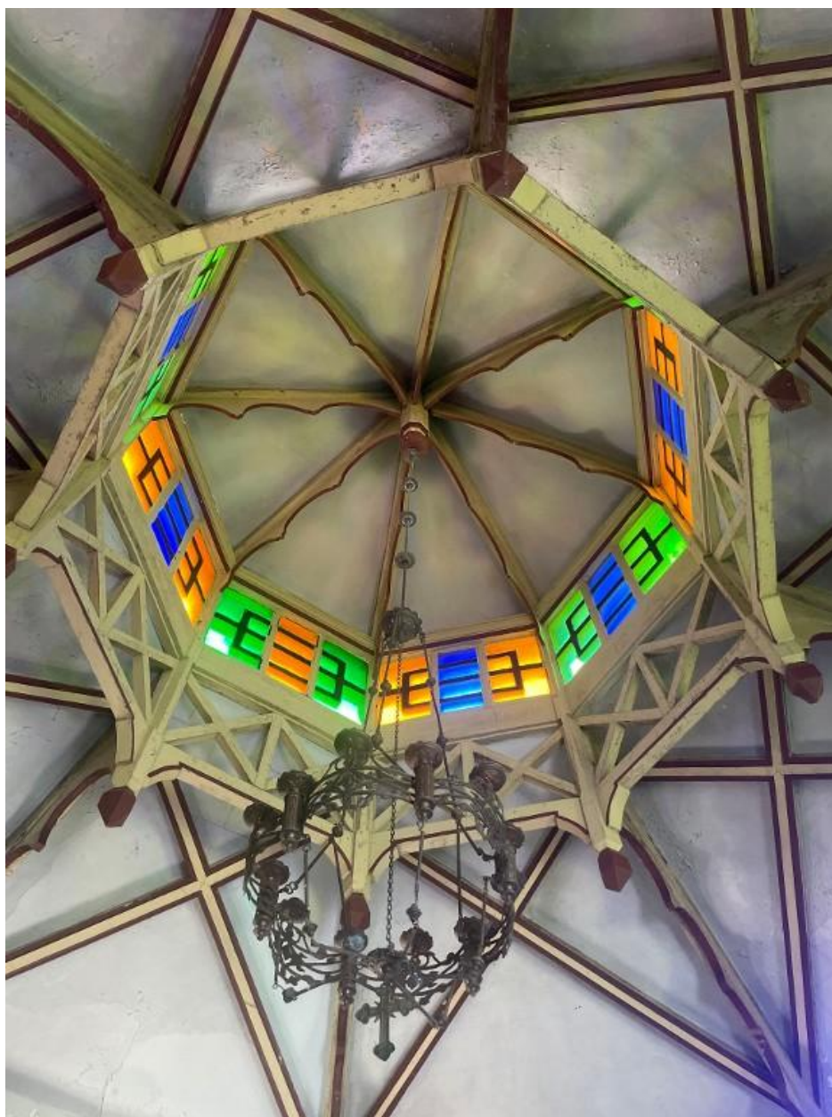
Détail de la voûte de la chapelle
