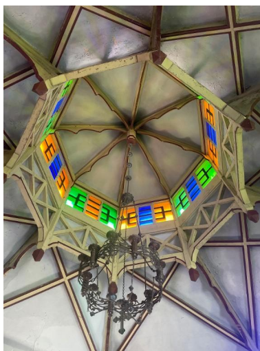
Détail de la voûte de la chapelle Phot. Enora Boisson IVR53_20243510447NUCA
