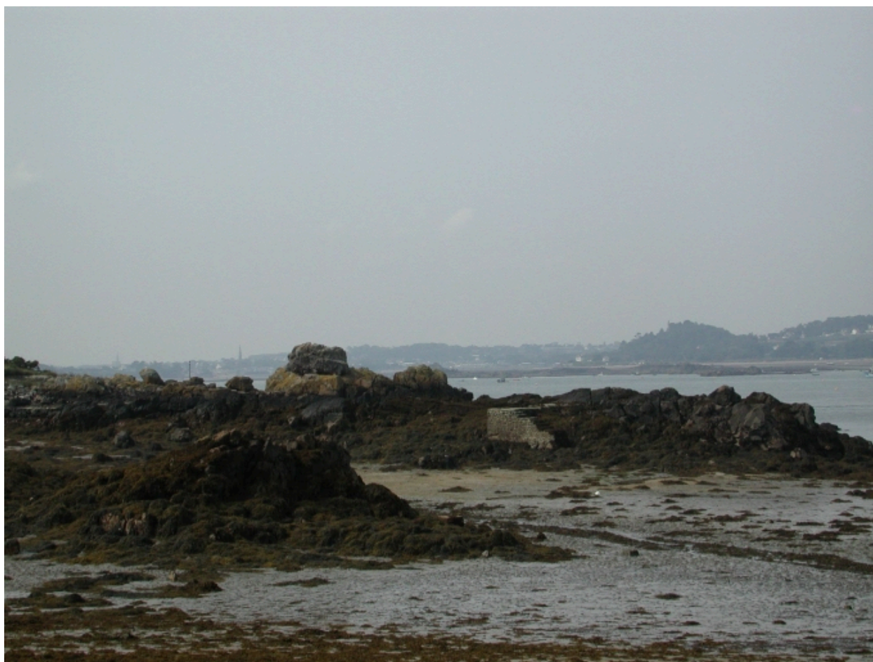
Vue du mur du quai Sud à son extrémité
