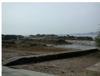
Vue générale de la 'cale des Moines' Phot. Guy Prigent IVR53_20082207705NUCA
