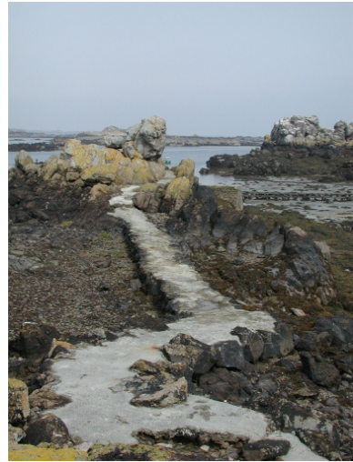
Vue du chemin de circulation de la portion de jetée Sud Phot. Guy Prigent IVR53_20082207710NUCA
