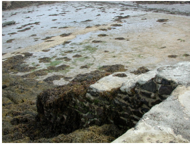
Vue des marches cimentées de l'escalier du quai Sud Phot. Guy Prigent IVR53_20082207712NUCA
