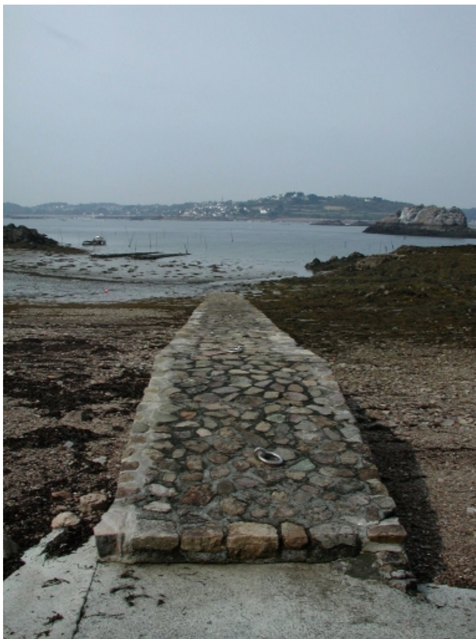
Vue du recouvrement de la 'cale des Moines'
