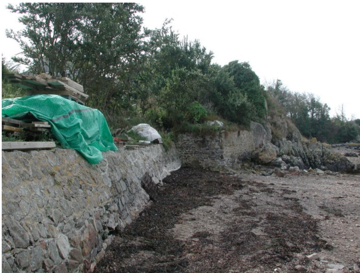
Vue du mur-digue de soutènement
