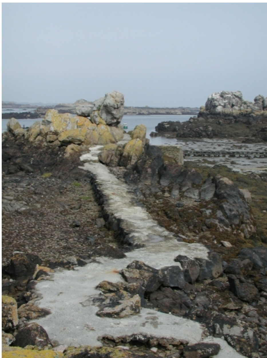
Vue du chemin de circulation de la portion de jetée Sud
