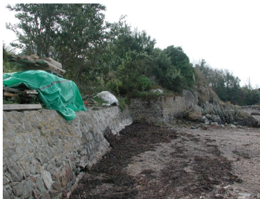
Vue du mur-digue de soutènement Phot. Guy Prigent IVR53_20082207704NUCA
