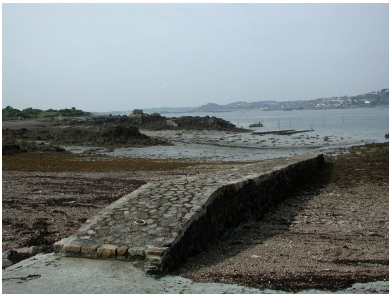
Vue générale du quai ou 'cale des Moines', entièrement restaurée
