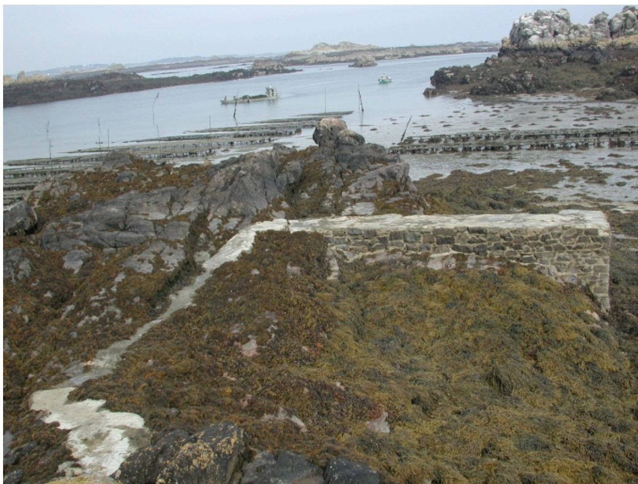
Vue du mur de quai de la cale Sud, entièrement rénové
