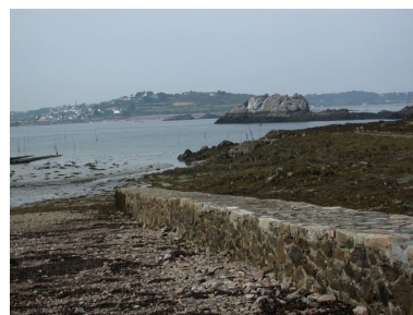
Vue de la face externe de la cale des Moines Phot. Guy Prigent IVR53_20082207707NUCA
