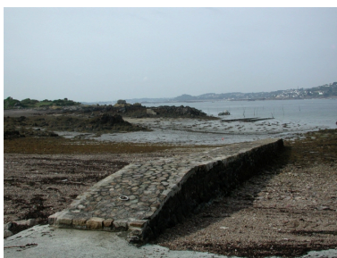
Vue générale du quai ou 'cale des Moines', entièrement restaurée Phot. Guy Prigent IVR53_20082207706NUCA
