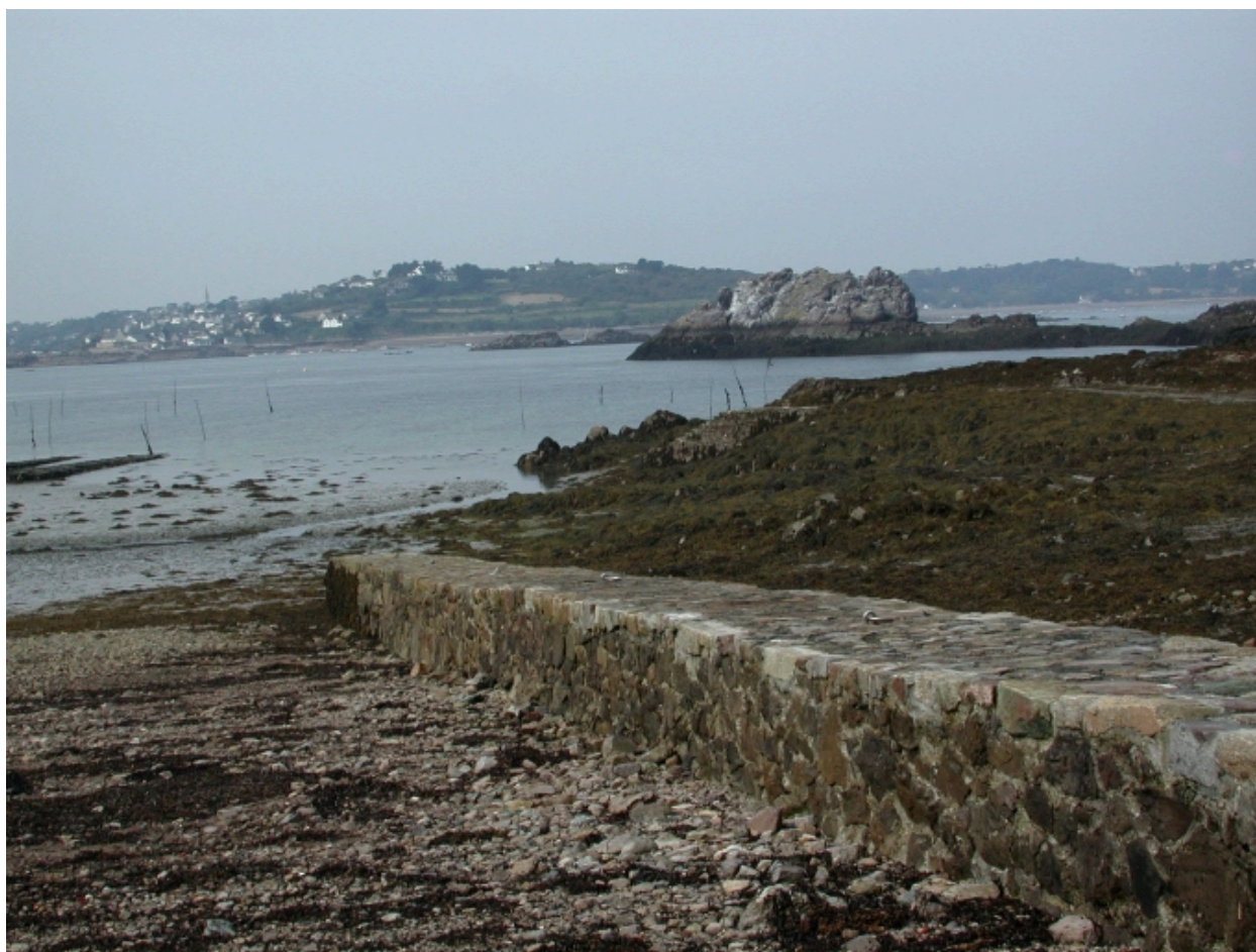
Vue de la face externe de la cale des Moines
