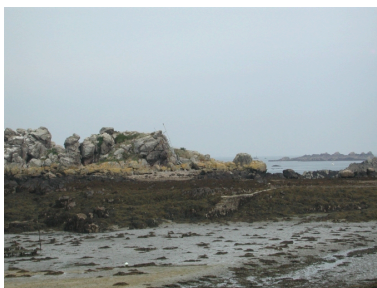
Vue générale de la jetée Ouest Phot. Guy Prigent IVR53_20082207714NUCA
