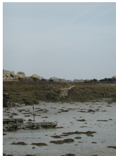
Vue de l'escalier de la jetée Ouest Phot. Guy Prigent IVR53_20082207713NUCA
