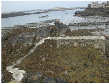
Vue du mur de quai de la cale Sud, entièrement rénové Phot. Guy Prigent IVR53_20082207711NUCA
