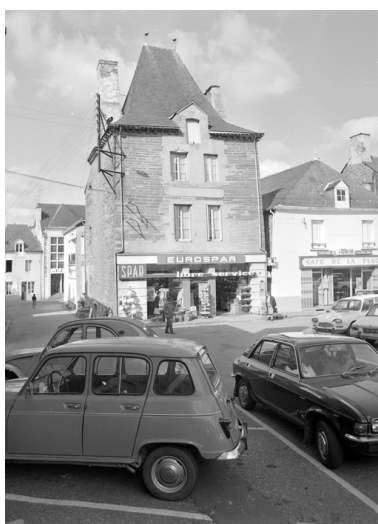
Maison 3 place de la Mairie, élévation antérieure est. Phot. Auteur inconnu IVR53_19775601003X
