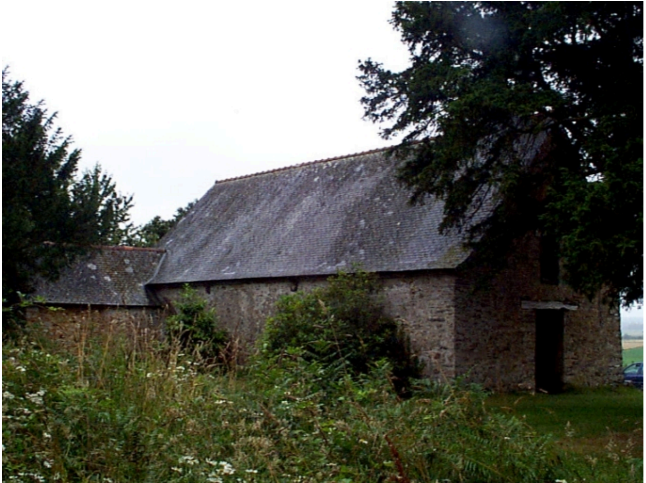
Vue partielle de la sacristie au nord.
