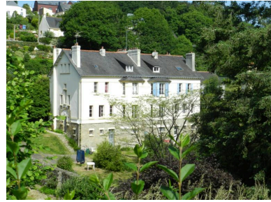
Vue côté jardin de deux des villas des ingénieurs de la rue du Meunier Phot. Pierre Laurent Constantin IVR53_20225605157NUCA
