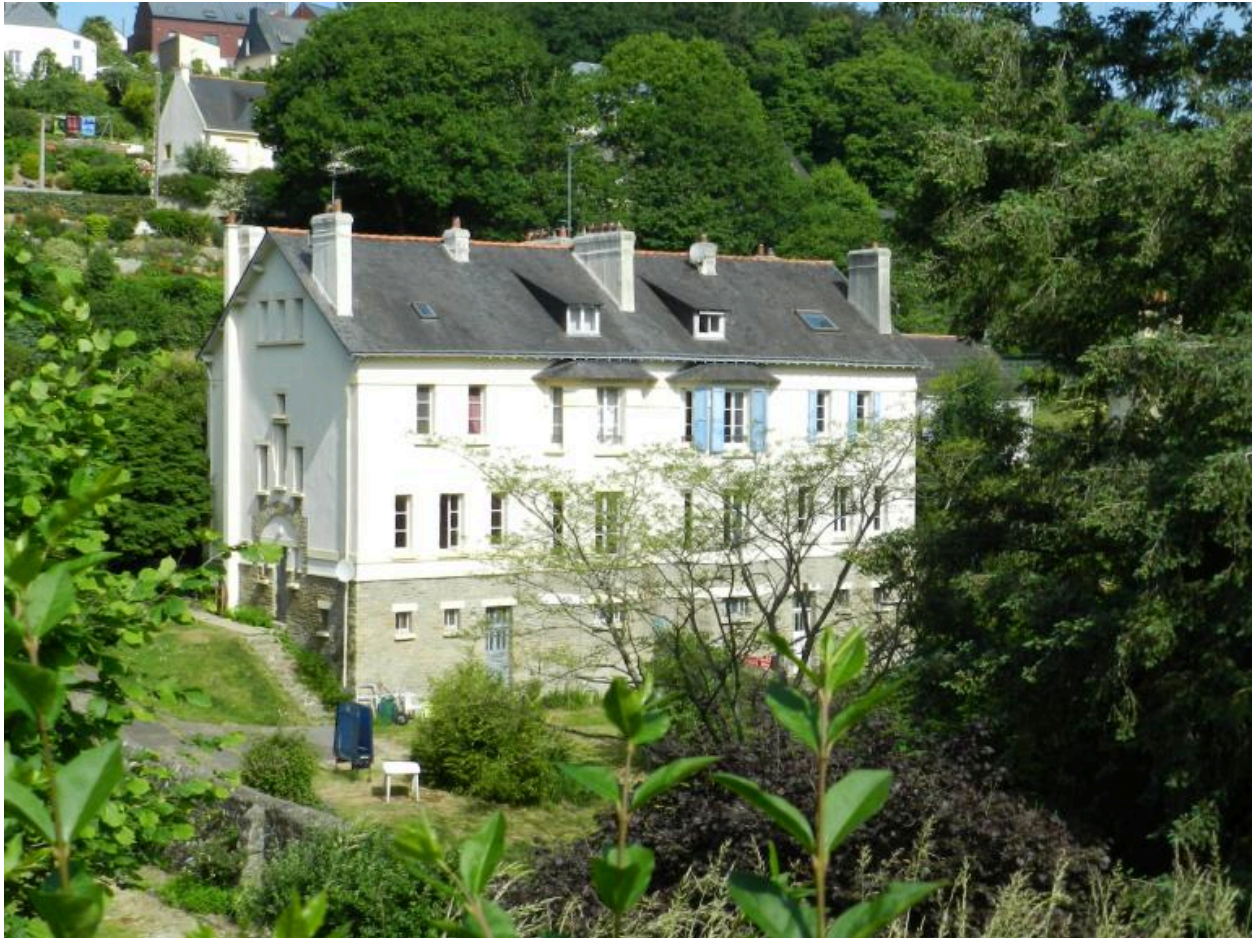
Vue côté jardin de deux des villas des ingénieurs de la rue du Meunier
