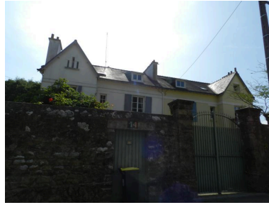
Villas accolées par deux sur la rue du Meunier Phot. Pierre Laurent Constantin IVR53_20225605156NUCA
