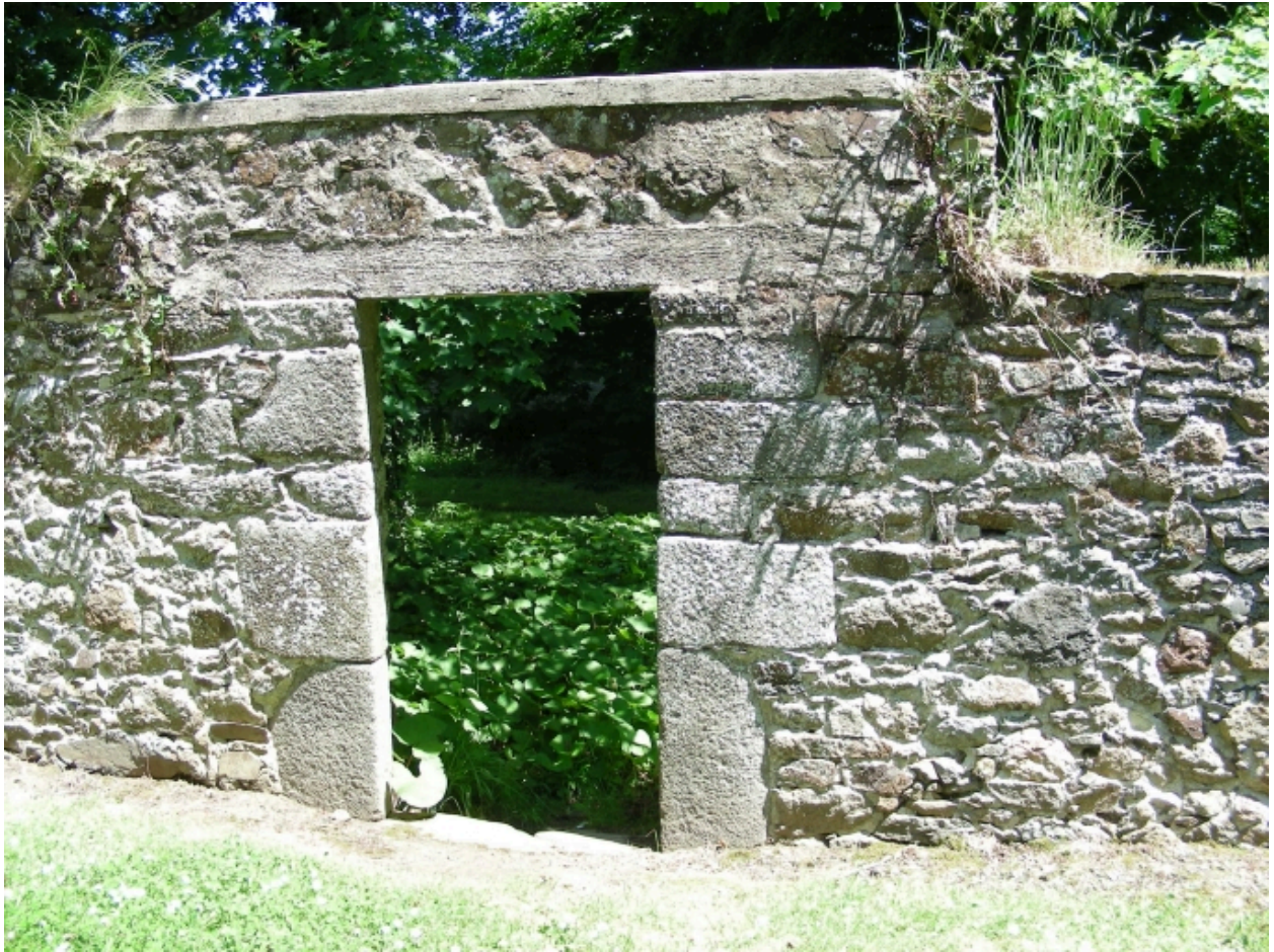
Mur d'enceinte de l'église
