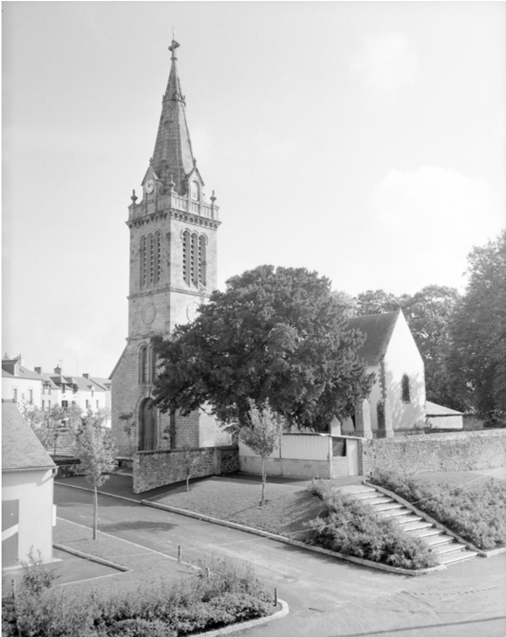
Elévation Sud-Ouest : vue générale
