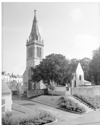
Elévation Sud-Ouest : vue générale Phot. Guy Artur, Phot. Norbert Lambart IVR53_19943501792X
