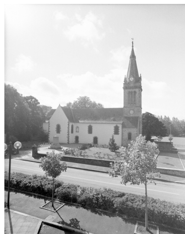
Elévation Nord : vue générale Phot. Guy Artur, Phot. Norbert Lambart IVR53_19943501794X
