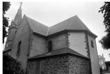
Vue oblique, ensemble sud de l'église Phot. F. Coutel IVR53_19713500759NUC
