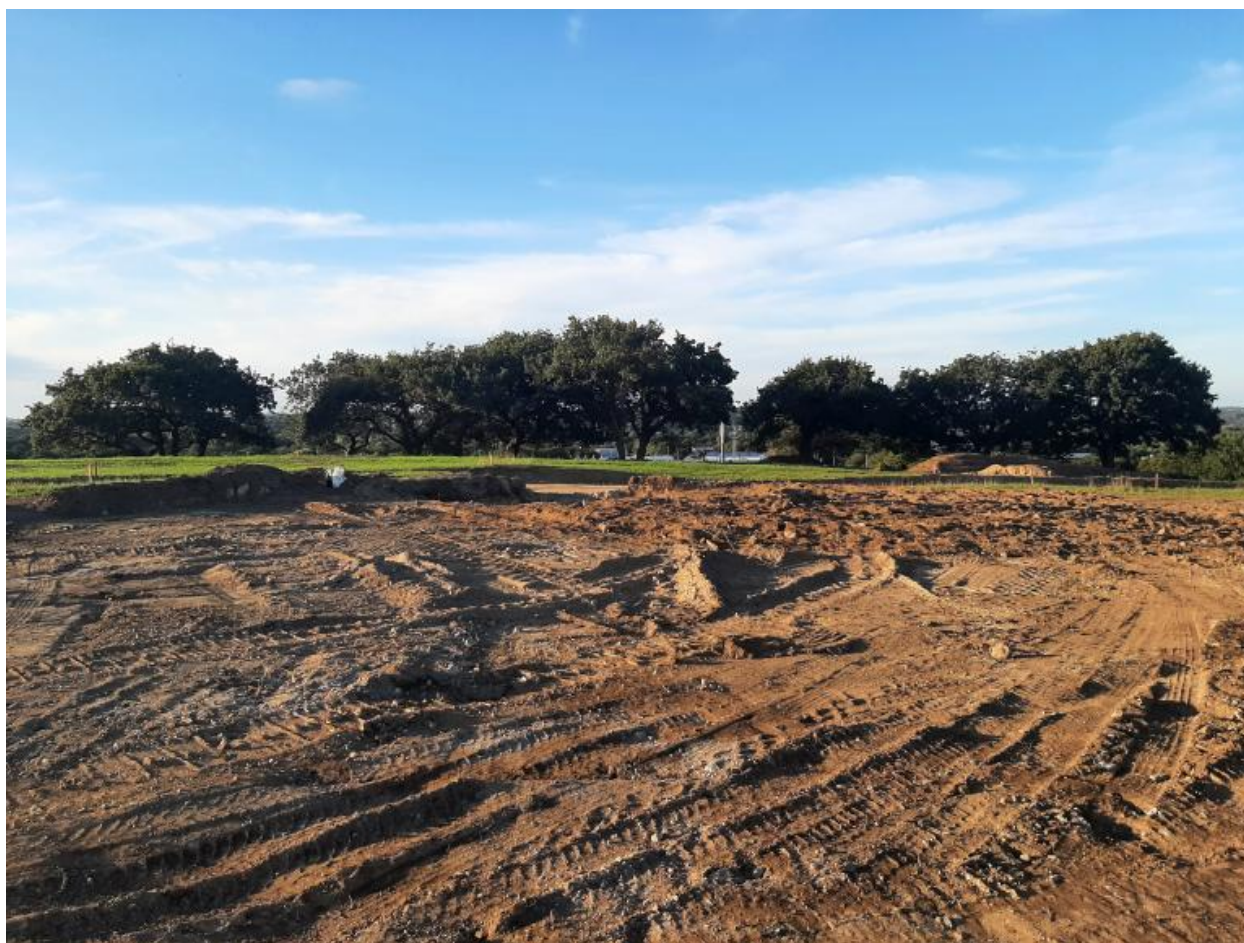
Vue générale après la déconstruction (11 octobre 2022)
