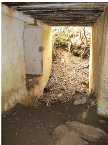
Vue de l'entrée ouest en partie remblayée et envahie par la végétation (état en 2013) Phot. Guillaume Lécueillier IVR53_20222905268NUCA
