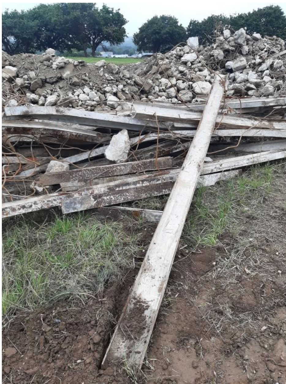
Vue de la déconstruction : matériaux (2 octobre 2022). Au premier plan : poutres en acier en I
