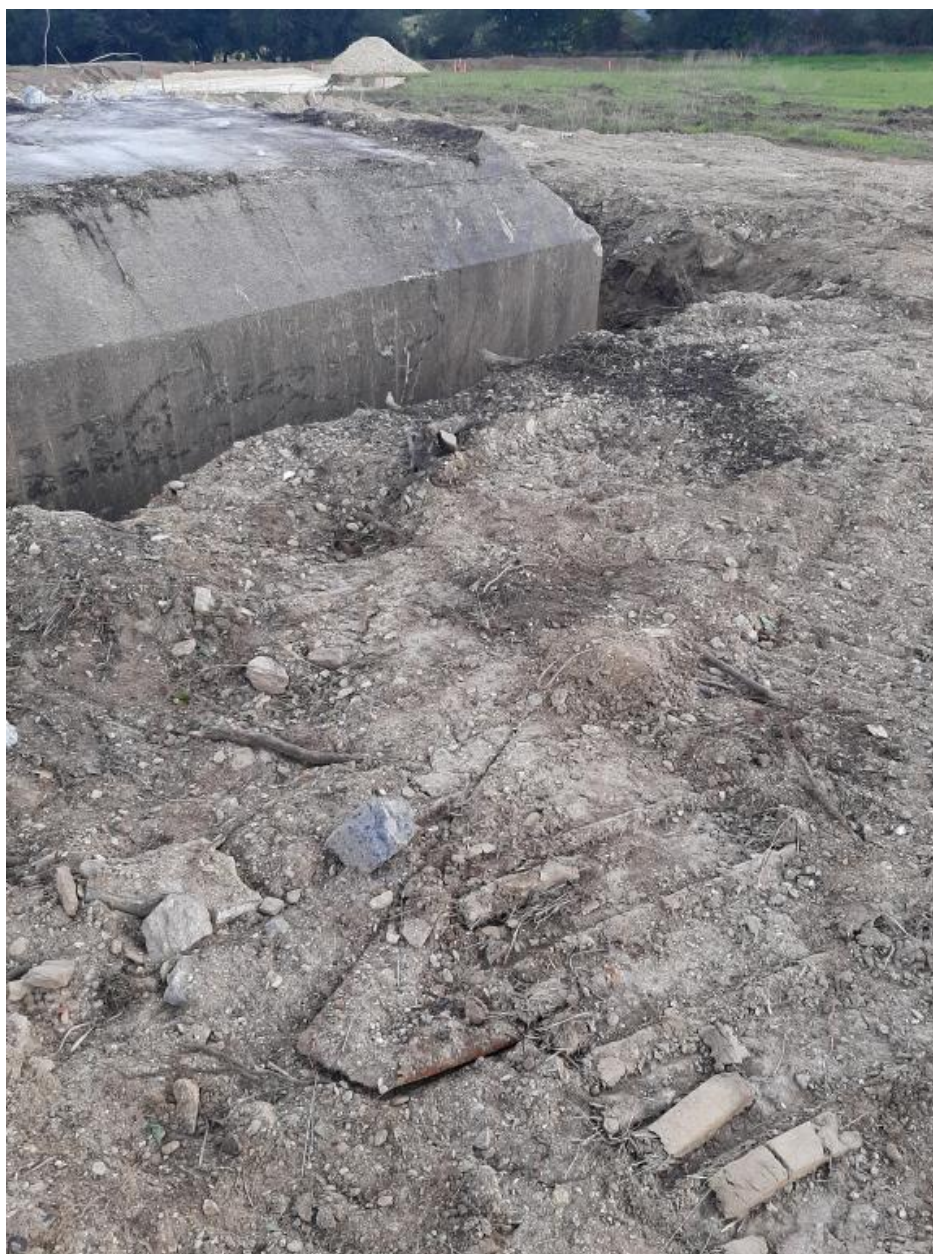
Vue de la déconstruction depuis le sud (25 septembre 2022)
