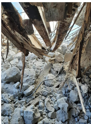
Vue de la déconstruction : pièce de vie - chambre de troupe (25 septembre 2022). Le plafond est constitué d'une alternance de poutres en acier en I et de poutres en bois avec au-dessus une couche de béton armé Phot. Simon Roudot IVR53_20222905932NUCA
