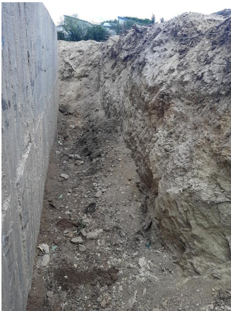
Vue de la déconstruction : mur sud (25 septembre 2022)
