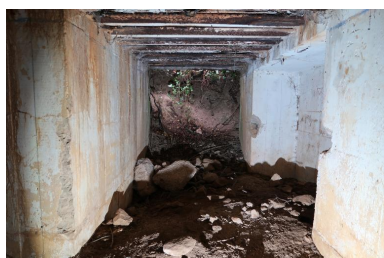
Vue de l'entrée est en partie remblayée et envahie par la végétation (état en 2021). A droite, niche murale (un liseré de couleur bleue est visible sur le mur) Phot. Guillaume Lécueillier IVR53_20222905274NUCA
