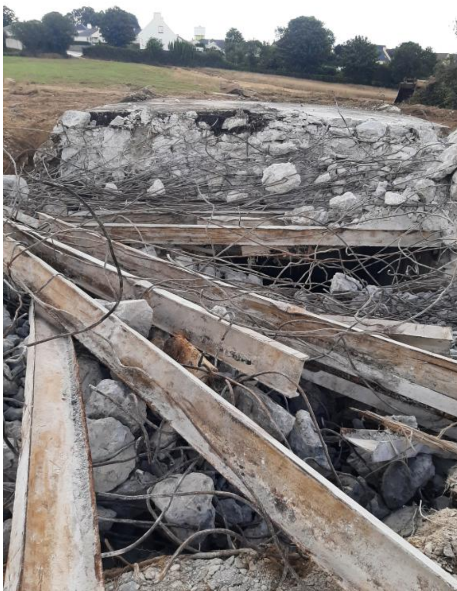
Vue de la déconstruction : dalle de couverture et murs périphériques en béton armé (25 septembre 2022). Dans le béton : fers et poutrelles en acier en I
