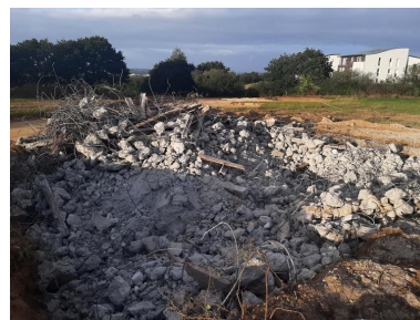
Vue de la déconstruction (26 septembre 2022)
