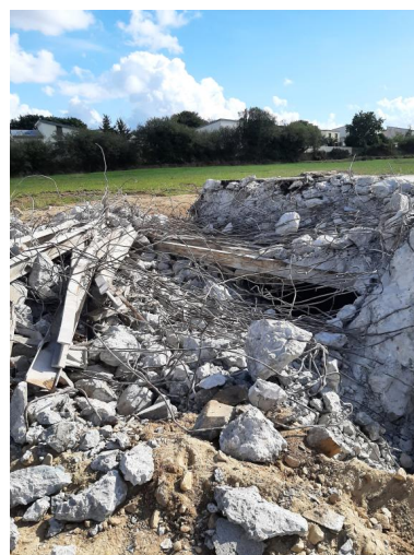
Vue de la déconstruction : dalle de couverture et murs périphériques en béton armé (25 septembre 2022). Le plafond est constitué d'une alternance de poutres en acier en I et de poutres en bois avec au-dessus une couche de béton armé Phot. Simon Roudot IVR53_20222905936NUCA
