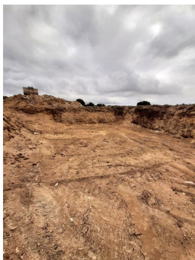
Vue de la fouille après déconstruction (4 octobre 2022) Phot. Simon Roudot IVR53_20222905958NUCA
