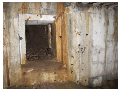
Vue de la sortie de secours de la pièce de vie - chambre de troupe (état en 2013). Sur le mur, liseré de couleur bleue faisant frise et fleur
