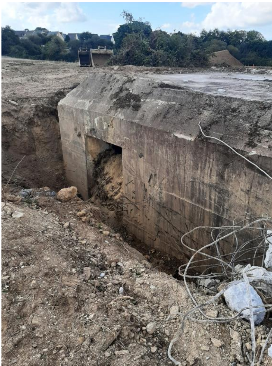
Vue de la déconstruction : entrée est (25 septembre 2022)
