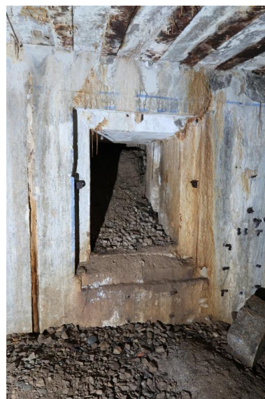
Vue de la sortie de secours de la pièce de vie - chambre de troupe (état en 2021). Sur le mur, liseré de couleur bleue faisant frise
