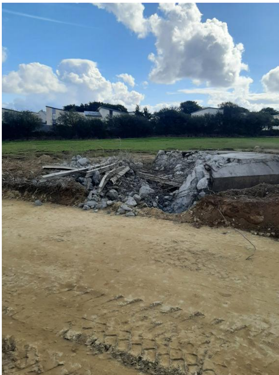
Vue de la déconstruction (25 septembre 2022)
