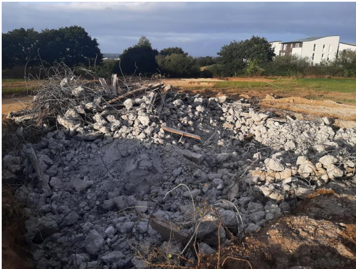
Vue de la déconstruction (26 septembre 2022)
