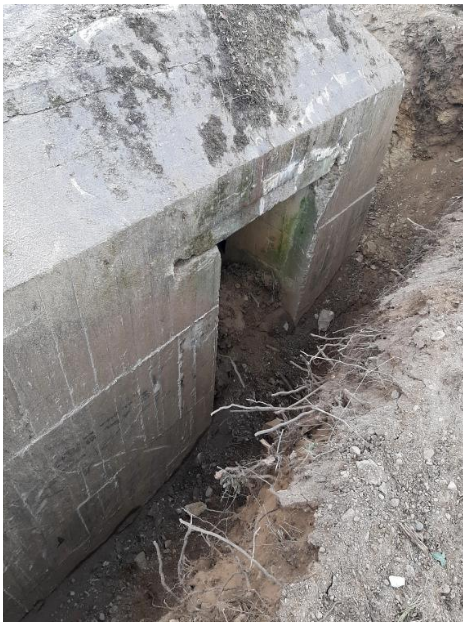
Vue de la déconstruction : entrée ouest (25 septembre 2022)
