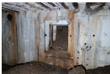
Vue de la sortie de secours de la pièce de vie - chambre de troupe (état en 2021). Sur le mur, liseré de couleur bleue faisant frise et fleur (à droite)
