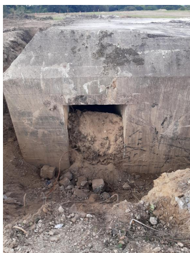
Vue de la déconstruction : entrée est (25 septembre 2022) Phot. Simon Roudot IVR53_20222905913NUCA
