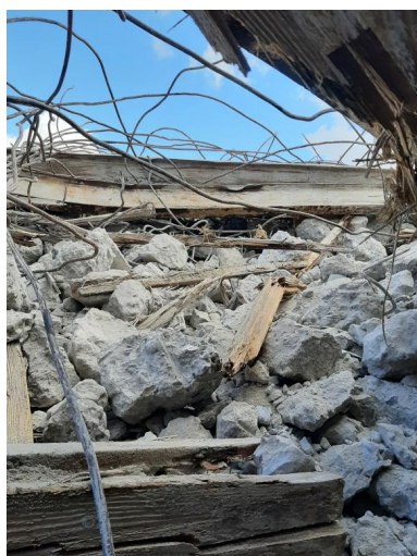
Vue de la déconstruction : pièce de vie - chambre de troupe (25 septembre 2022). Le plafond est constitué d'une alternance de poutres en acier en I et de poutres en bois avec au-dessus une couche de béton armé Phot. Simon Roudot IVR53_20222905931NUCA
