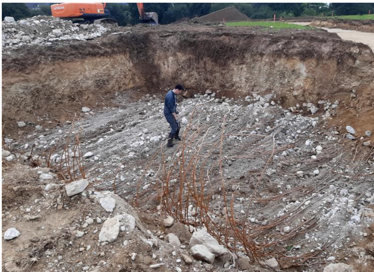
Vue de la déconstruction (1er octobre 2022). Au sol : fers et granulat de béton
