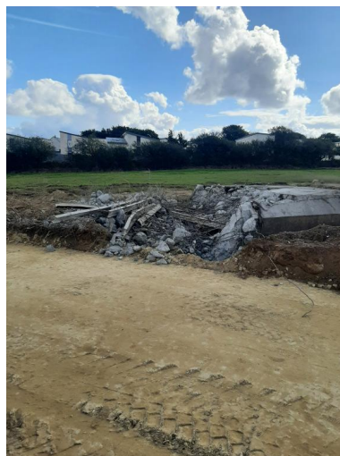
Vue de la déconstruction (25 septembre 2022) Phot. Simon Roudot IVR53_20222905908NUCA
