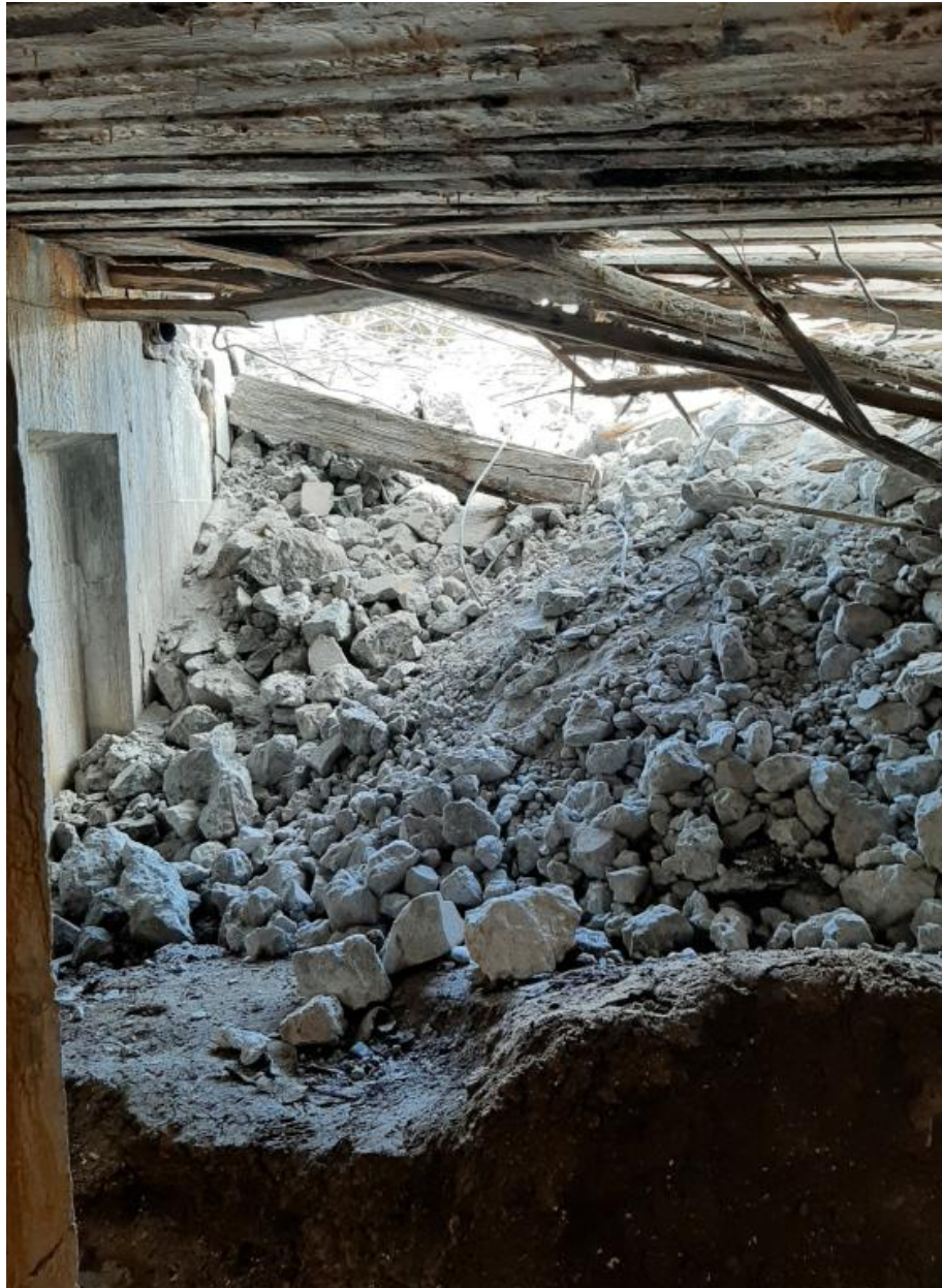
Vue de la déconstruction : pièce de vie - chambre de troupe (25 septembre 2022). Le plafond est constitué d'une alternance de poutres en acier en I et de poutres en bois avec au-dessus une couche de béton armé
