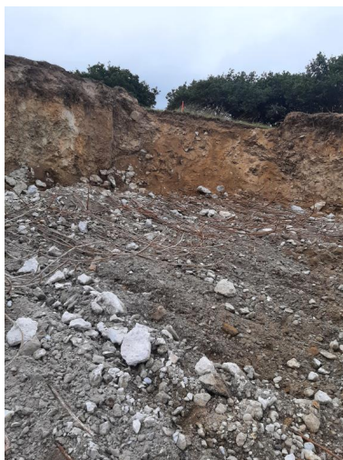
Vue de la déconstruction (1er octobre 2022). Au sol : fers et granulat de béton Phot. Simon Roudot IVR53_20222905947NUCA
