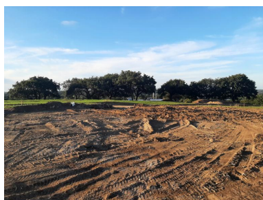
Vue générale après la déconstruction (11 octobre 2022) Phot. Simon Roudot IVR53_20222905961NUCA
