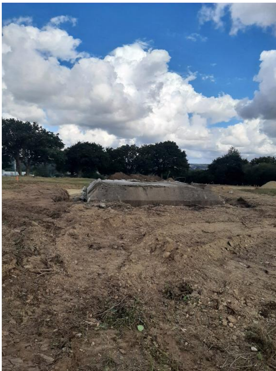
Vue de la déconstruction depuis la sud (25 septembre 2022)
