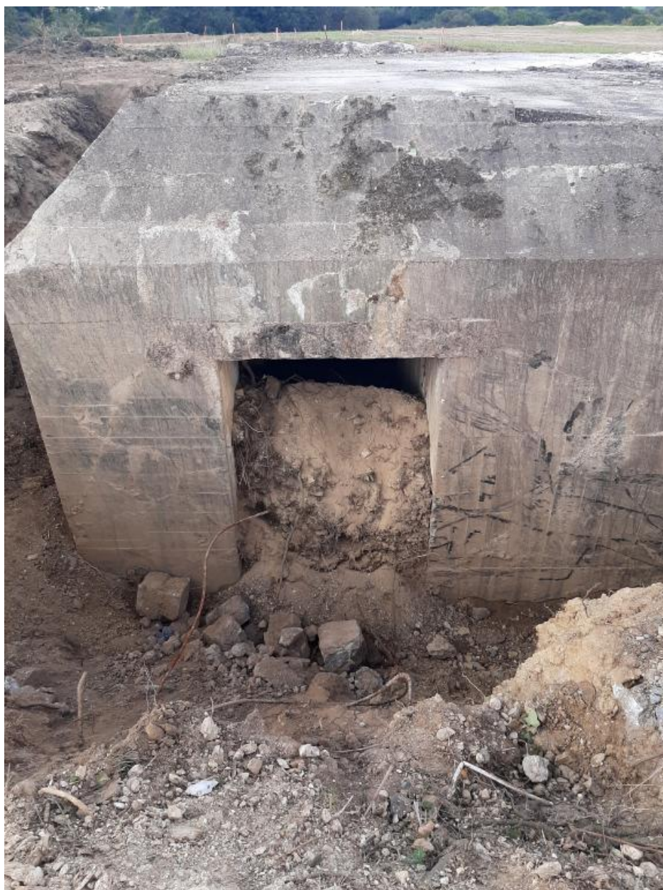
Vue de la déconstruction : entrée est (25 septembre 2022)
