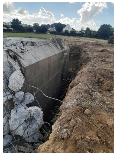
Vue de la déconstruction (25 septembre 2022) Phot. Simon Roudot IVR53_20222905909NUCA
