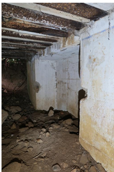
Vue de l'entrée est en partie remblayée et envahie par la végétation (état en 2021). A droite, niche murale (un liseré de couleur bleue est visible sur le mur) Phot. Guillaume Lécueillier
