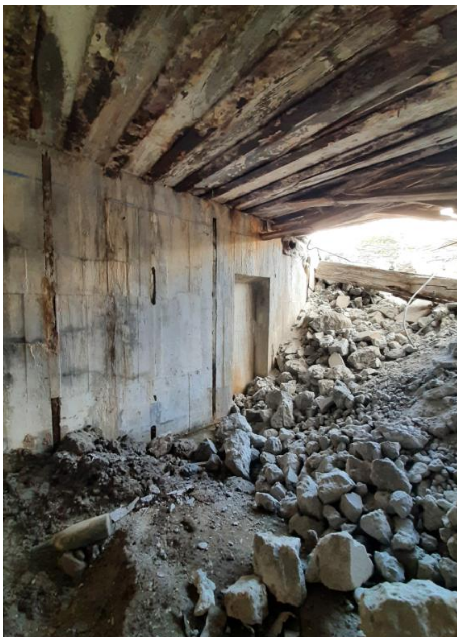
Vue de la déconstruction : pièce de vie - chambre de troupe (25 septembre 2022). Le plafond est constitué d'une alternance de poutres en acier en I et de poutres en bois avec au-dessus une couche de béton armé
