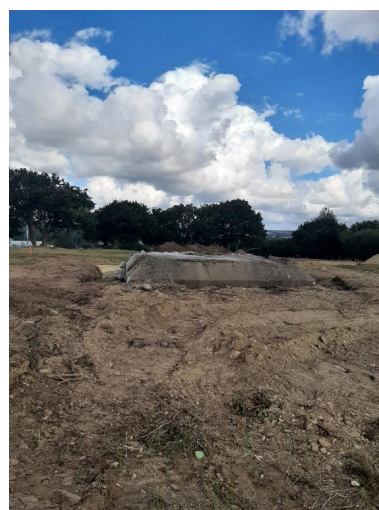
Vue de la déconstruction depuis la sud (25 septembre 2022) Phot. Simon Roudot IVR53_20222905915NUCA
