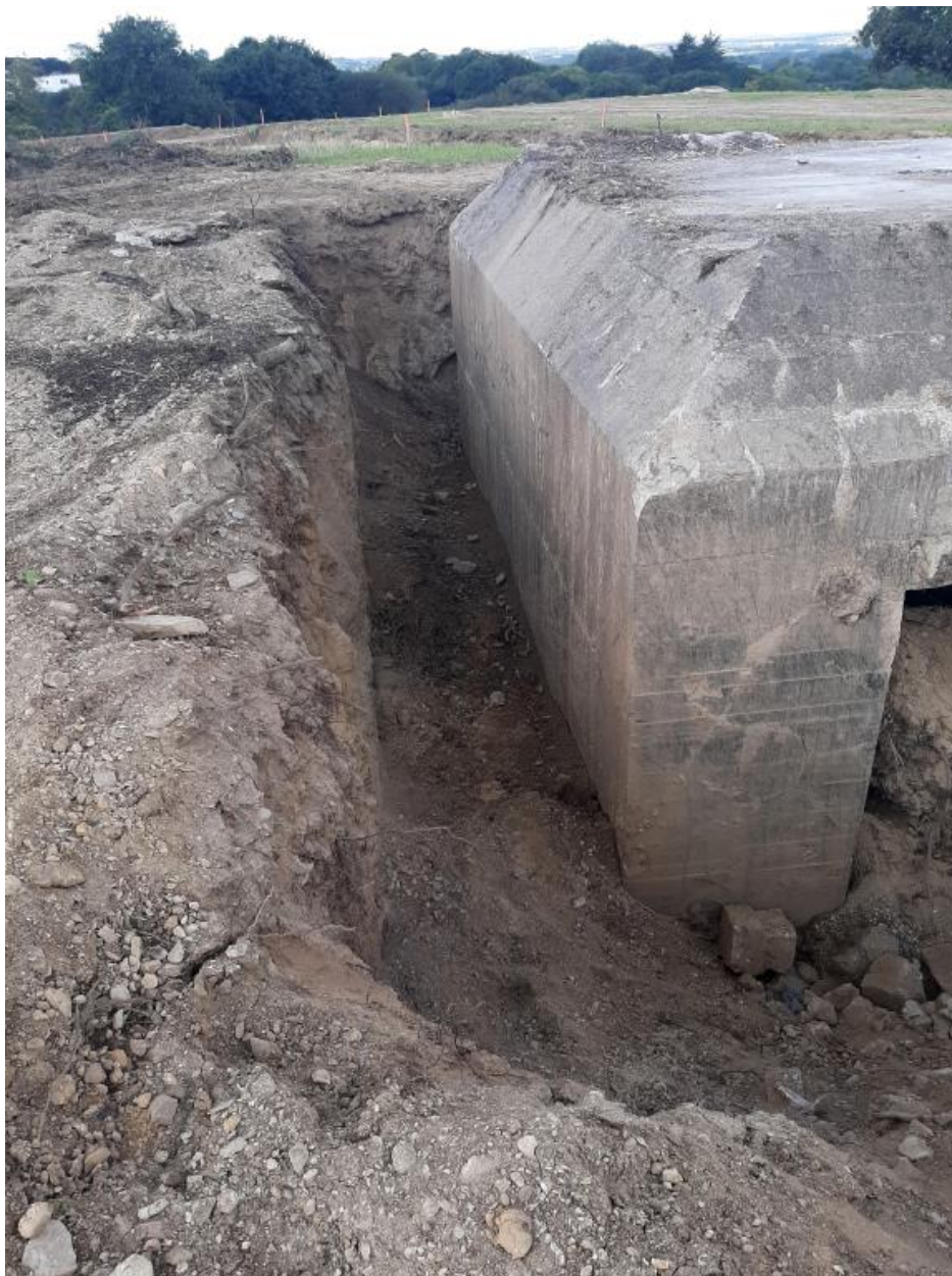
Vue de la déconstruction : mur sud (25 septembre 2022). A droite, l'entrée est
