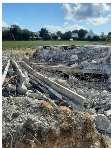
Vue de la déconstruction : dalle de couverture et murs périphériques en béton armé (25 septembre 2022).
