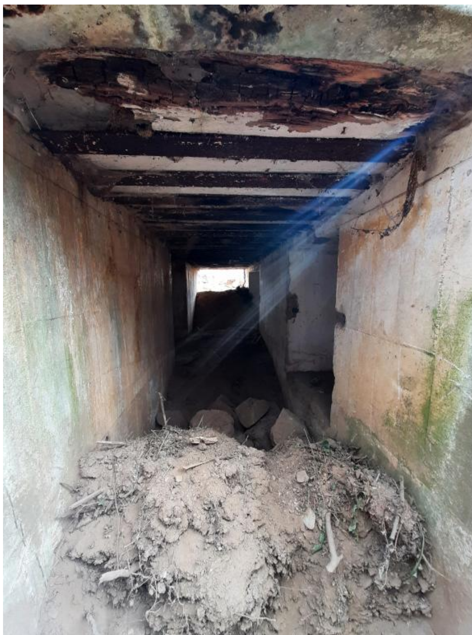
Vue de la déconstruction : couloir d'entrée (25 septembre 2022)
