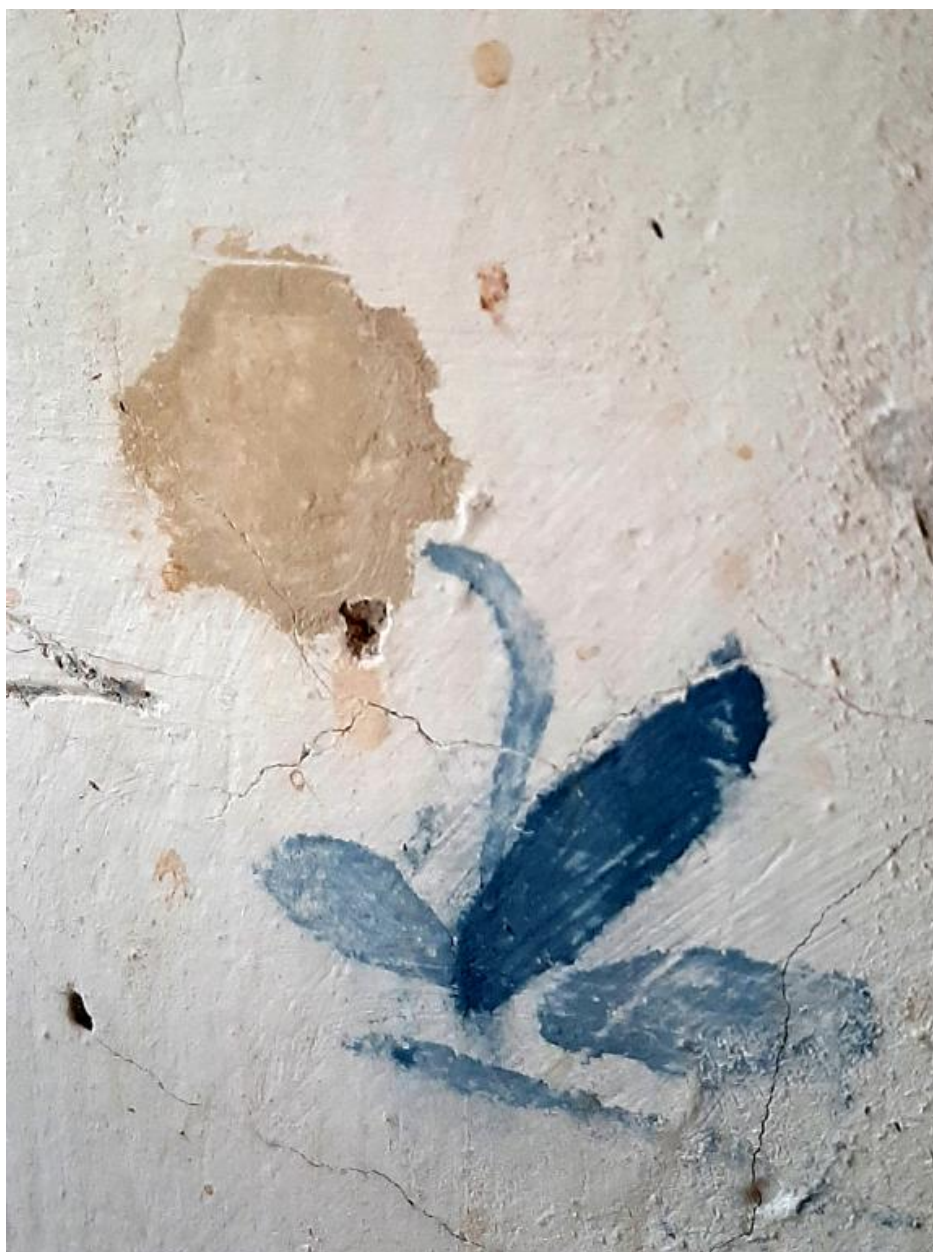
Vue de la déconstruction : pièce de vie - chambre de troupe, peinture murale imitant une tapisserie constituée de fleurs (25 septembre 2022)
