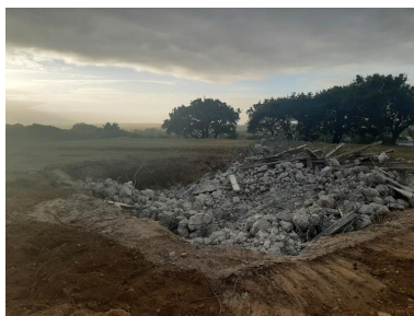
Vue de la déconstruction (26 septembre 2022)
