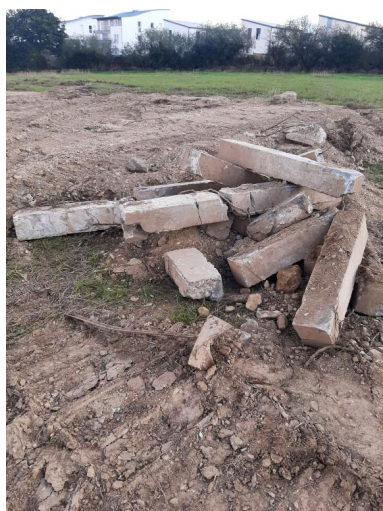
Vue de la déconstruction : poteaux en béton armé (25 septembre 2022) Phot. Simon Roudot IVR53_20222905916NUCA
