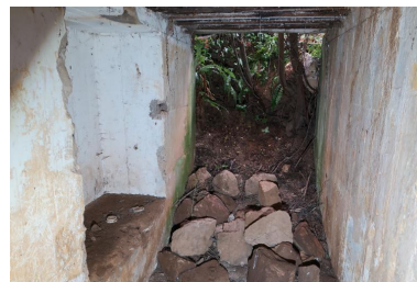
Vue de l'entrée ouest en partie remblayée et envahie par la végétation (état en 2021). A gauche, niche murale Phot. Guillaume Lécueillier IVR53_20222905277NUCA
