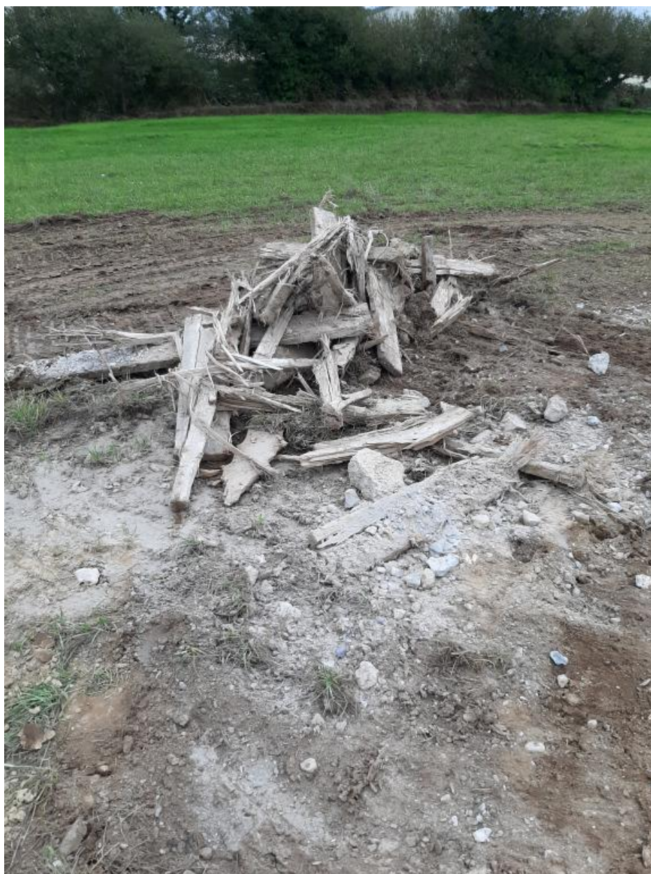
Vue de la déconstruction : vestiges de poutre en bois du plafond (4 octobre 2022)
