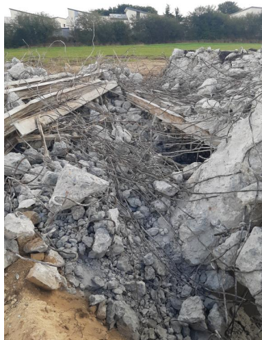
Vue de la déconstruction : dalle de couverture et murs périphériques en béton armé (25 septembre 2022). Dans le béton : fers et poutrelles en acier en I Phot. Simon Roudot IVR53_20222905910NUCA
