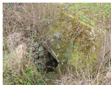
Vue de l'entrée ouest envahie par la végétation (état en 2013) Phot. Guillaume Lécueillier IVR53_20222905267NUCA
