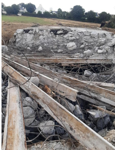
Vue de la déconstruction : dalle de couverture et murs périphériques en béton armé (25 septembre 2022). Dans le béton : fers et poutrelles en acier en I Phot. Simon Roudot IVR53_20222905911NUCA
