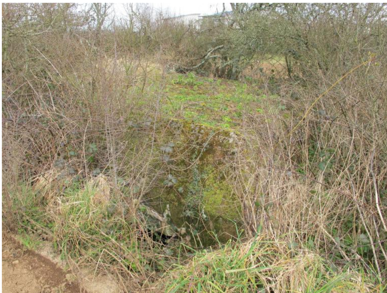
Vue générale depuis le sud-ouest (état en 2013)
