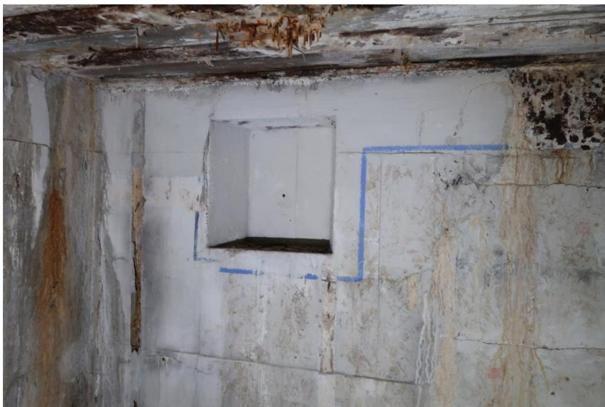
Vue de la pièce de vue - chambre de troupe (état en 2021). Sur le mur doté d'une niche, liseré de couleur bleue faisant frise et fleur au pétale rouge
