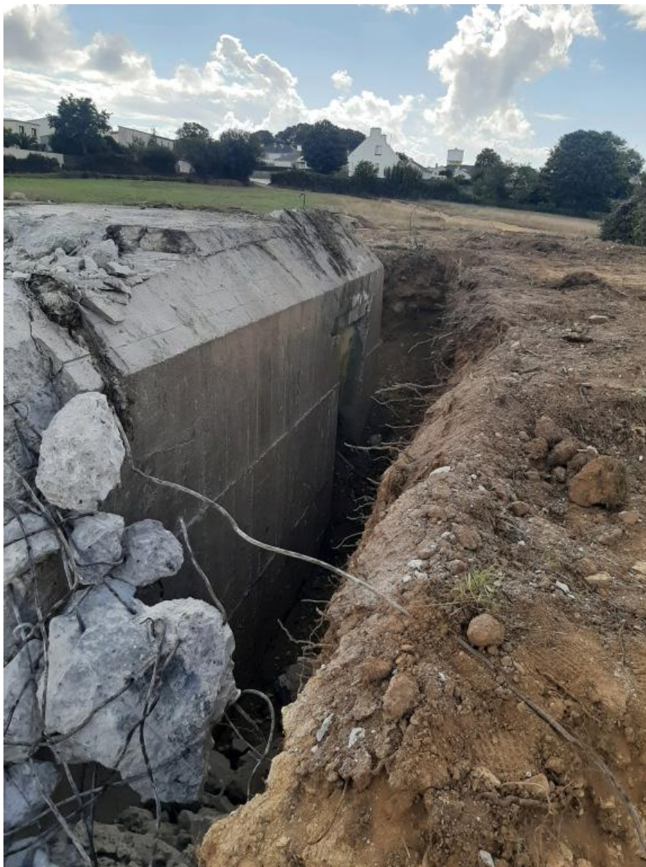
Vue de la déconstruction (25 septembre 2022)
