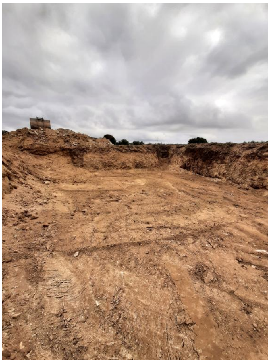
Vue de la fouille après déconstruction (4 octobre 2022)
