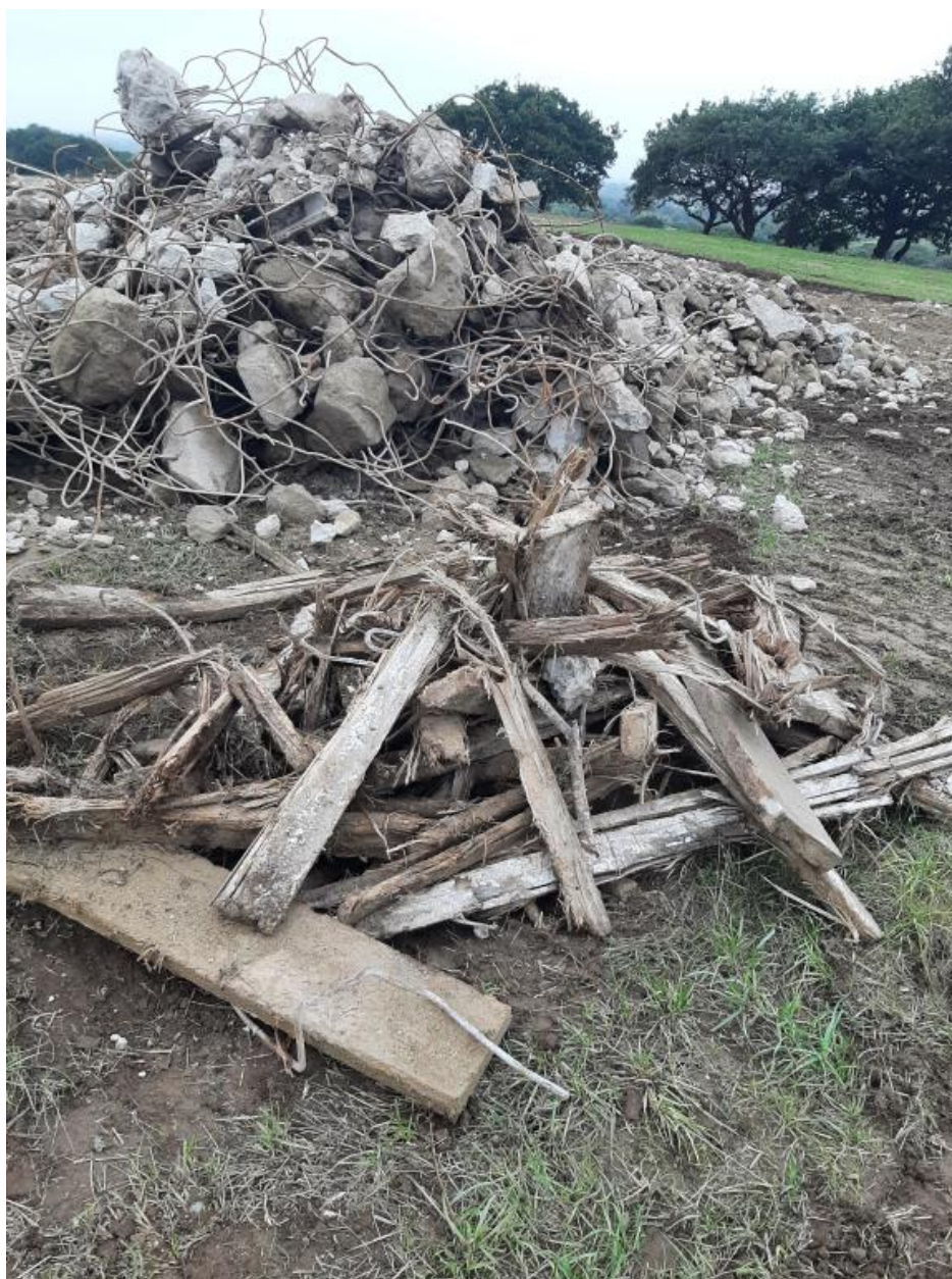
Vue de la déconstruction : matériaux (2 octobre 2022). Au premier plan : vestiges de poutre de bois du plafond
