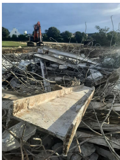
Vue de la déconstruction (26 septembre 2022). Au premier plan : poutre en acier en I Phot. Simon Roudot IVR53_20222905943NUCA
