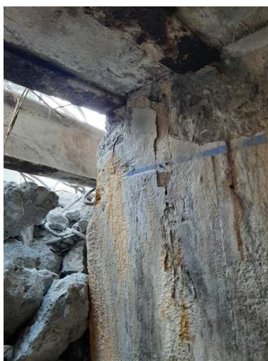
Vue de la déconstruction : pièce de vie - chambre de troupe, liseré de couleur bleue (25 septembre 2022). Le plafond est constitué d'une alternance de poutres en acier en I et de poutres en bois avec au-dessus une couche de béton armé Phot. Simon Roudot IVR53_20222905935NUCA
