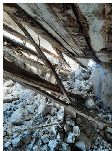
Vue de la déconstruction : pièce de vie - chambre de troupe (25 septembre 2022). Le plafond est constitué d'une alternance de poutres en acier en I et de poutres en bois avec au-dessus une couche de béton armé Phot. Simon Roudot IVR53_20222905933NUCA
