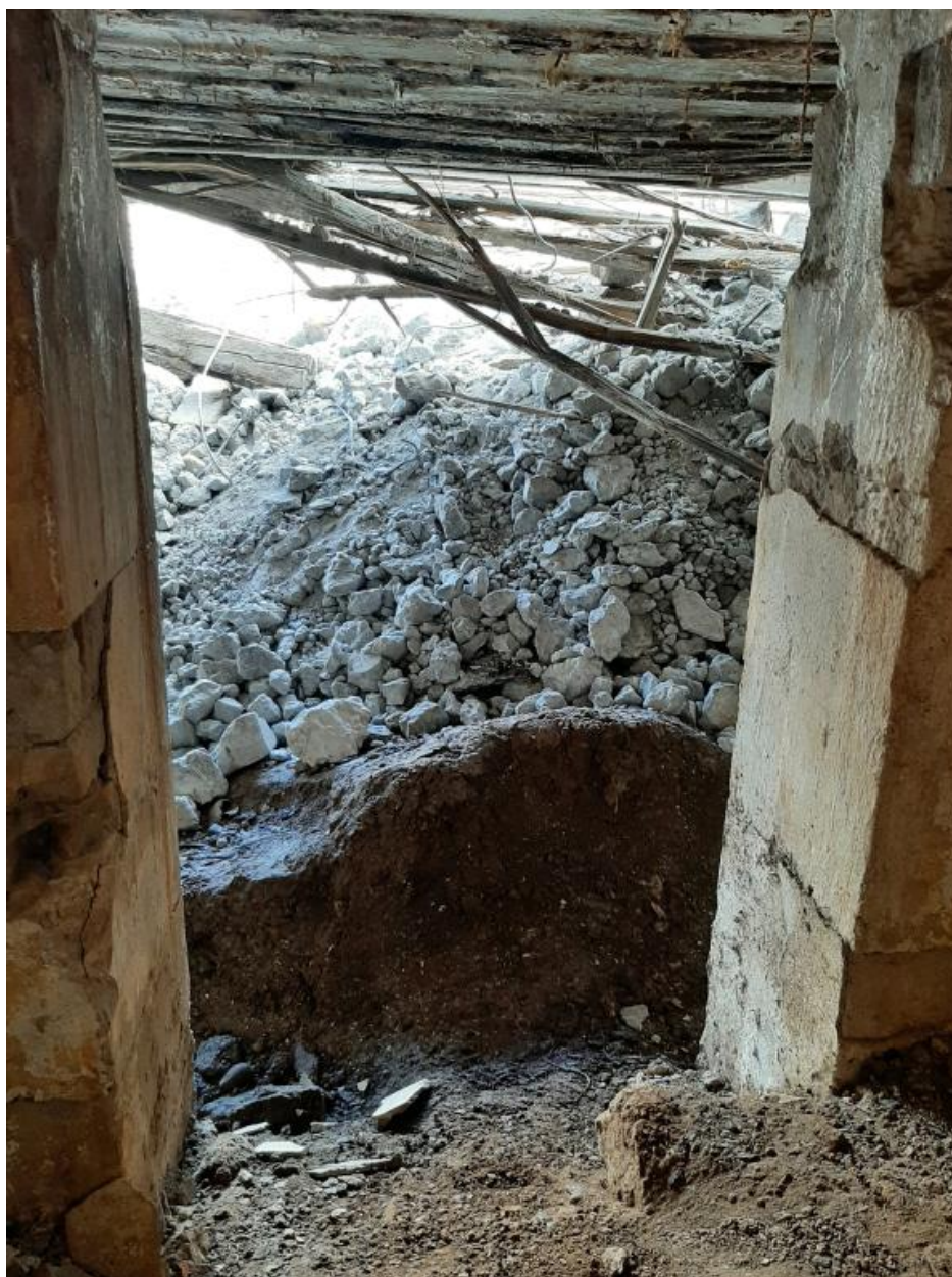
Vue de la déconstruction : entrée de la pièce de vie - chambre de troupe (25 septembre 2022)
