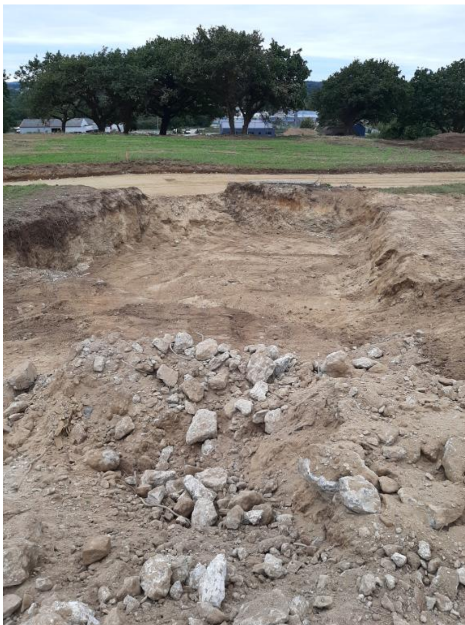
Vue de la fouille après déconstruction (4 octobre 2022)
