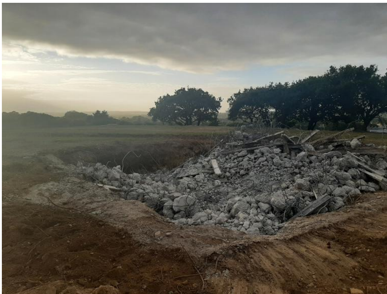
Vue de la déconstruction (26 septembre 2022)
