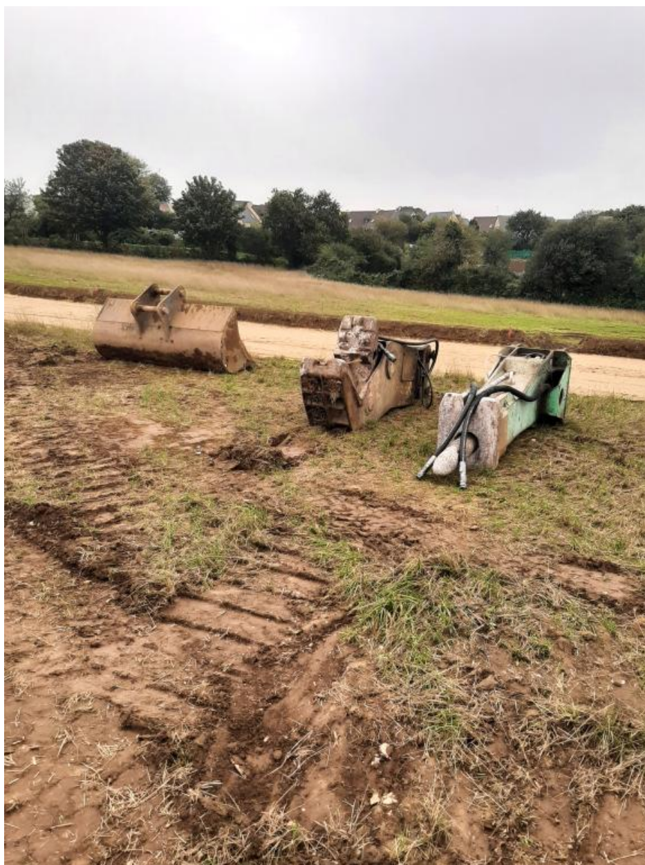
Vue de la déconstruction : outils utilisés par l'engin de terrassement, godet et brise-roche hydraulique (2 octobre 2022)
