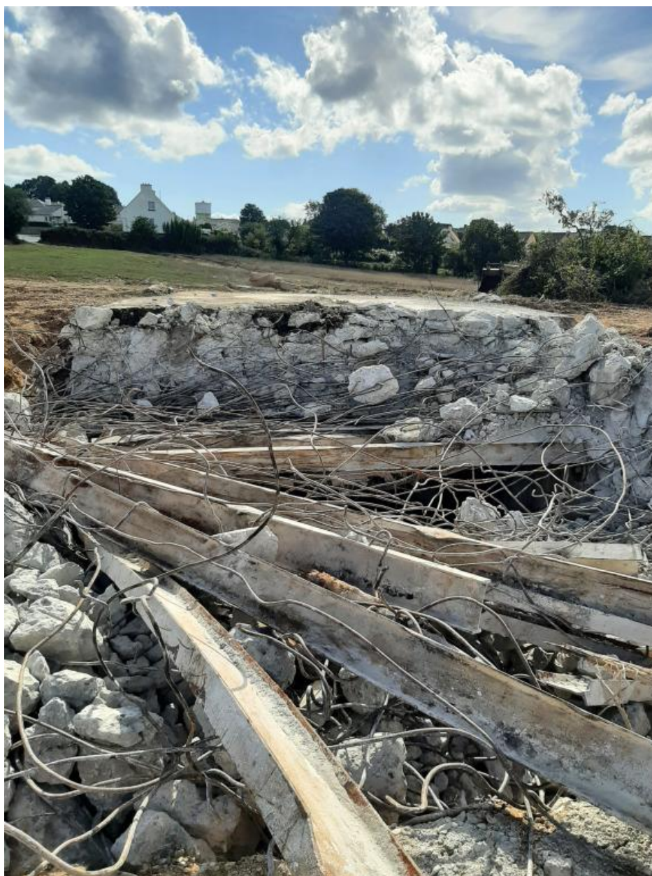
Vue de la déconstruction : dalle de couverture et murs périphériques en béton armé (25 septembre 2022). Le plafond est constitué d'une alternance de poutres en acier en I et de poutres en bois avec au-dessus une couche de béton armé
