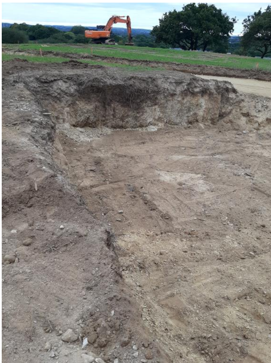
Vue de la fouille après déconstruction (4 octobre 2022)
