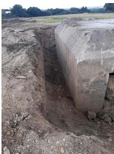
Vue de la déconstruction : mur sud (25 septembre 2022). A droite, l'entrée est Phot. Simon Roudot IVR53_20222905914NUCA
