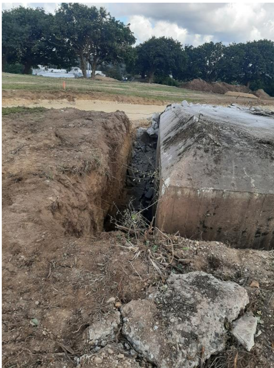
Vue de la déconstruction : angle sud-ouest (25 septembre 2022). Dans l'alignement se trouve le bunker - casemate, variante du type 667
