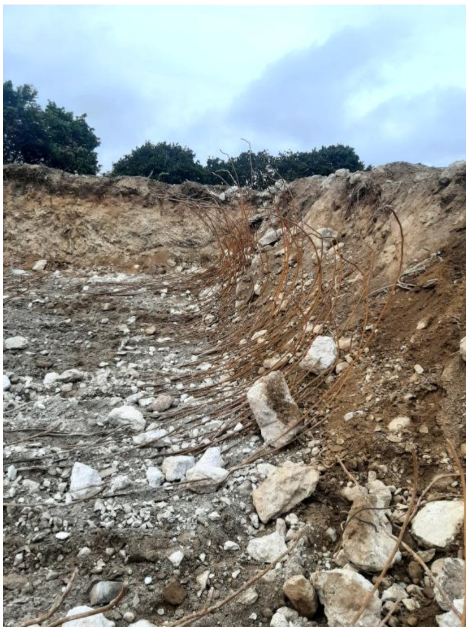
Vue de la déconstruction (1er octobre 2022). Au premier plan : fers et blocs de béton
