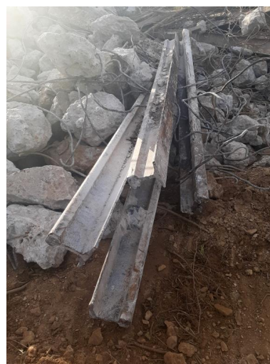
Vue de la déconstruction (26 septembre 2022). Au premier plan : blocs de béton et rails de chemin de fer Phot. Simon Roudot IVR53_20222905945NUCA
