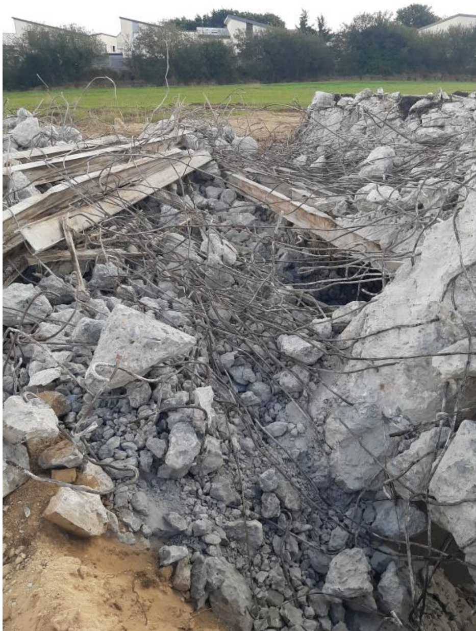
Vue de la déconstruction : dalle de couverture et murs périphériques en béton armé (25 septembre 2022). Dans le béton : fers et poutrelles en acier en I
