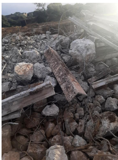
Vue de la déconstruction (26 septembre 2022). Au premier plan : blocs de béton, poutres, fers à béton et rails de chemin de fer Phot. Simon Roudot IVR53_20222905944NUCA
