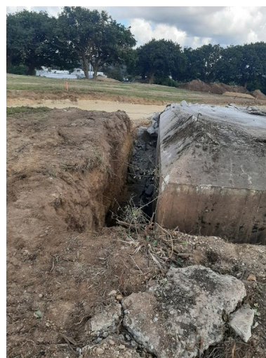
Vue de la déconstruction : angle sud-ouest (25 septembre 2022). Dans l'alignement se trouve le bunker - casemate, variante du type 667 Phot. Simon Roudot IVR53_20222905918NUCA
