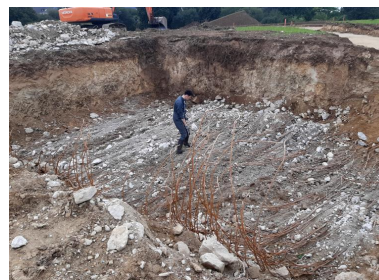
Vue de la déconstruction (1er octobre 2022). Au sol : fers et granulat de béton Phot. Simon Roudot IVR53_20222905948NUCA
