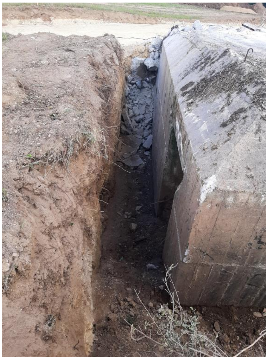
Vue de la déconstruction : mur ouest (25 septembre 2022). Au centre, l'entrée ouest
