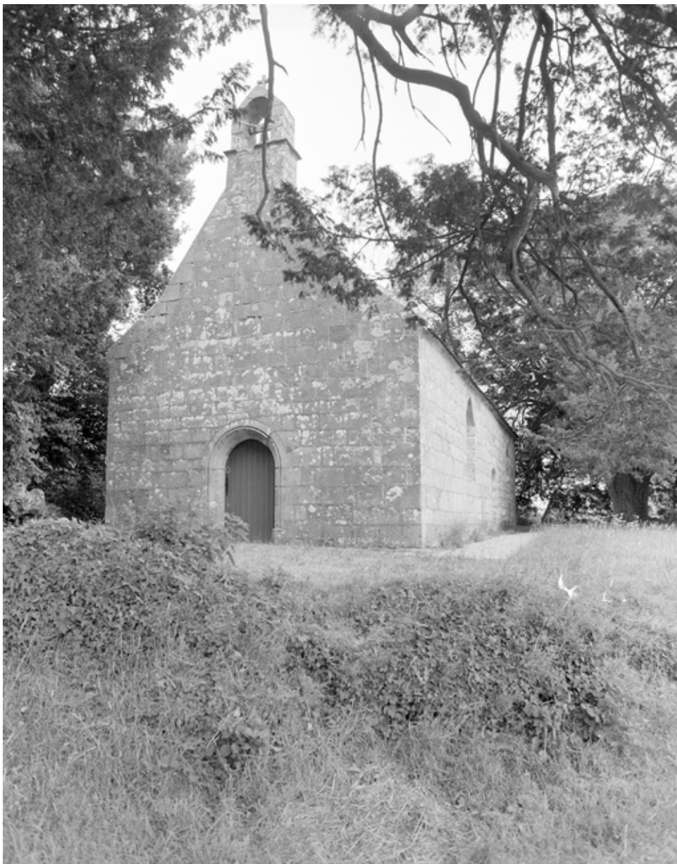
Vue générale de l'élévation ouest
