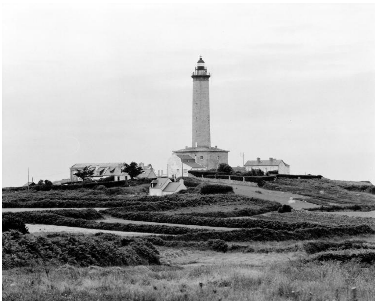
vue de situation sud-ouest
