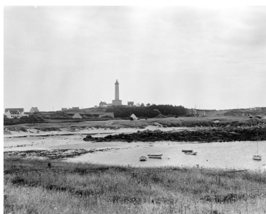
Vue de situation ouest
