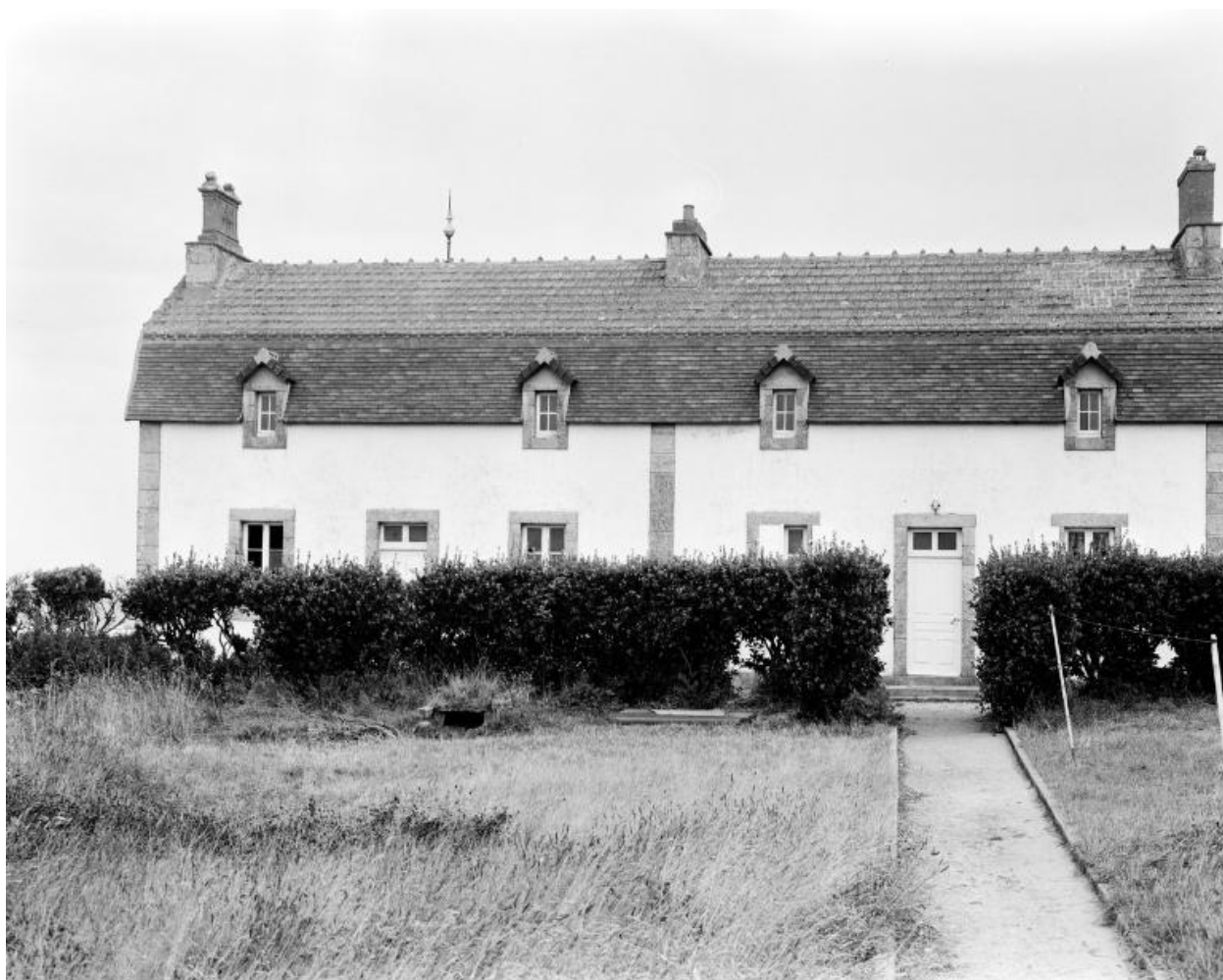
Bâtiment ouest, vue générale sud
