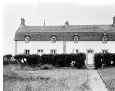
Bâtiment ouest, vue générale sud Phot. Guy Artur, Phot. Norbert Lambart IVR53_19862901522X
