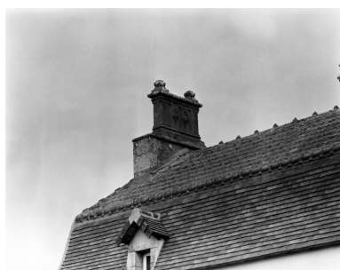
Bâtiment ouest, vue de détail de la couverture et de la souche de cheminée Phot. Guy Artur, Phot. Norbert Lambart IVR53_19862901524X
