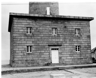
Entrée sud, vue générale Phot. Guy Artur, Phot. Norbert Lambart IVR53_19862901519X
