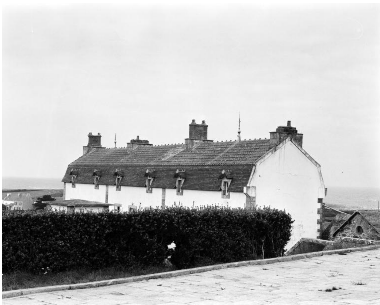
Bâtiment ouest, vue générale sud-est
