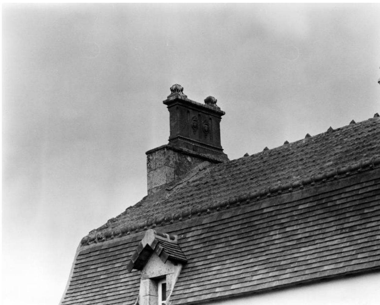
Bâtiment ouest, vue de détail de la couverture et de la souche de cheminée
