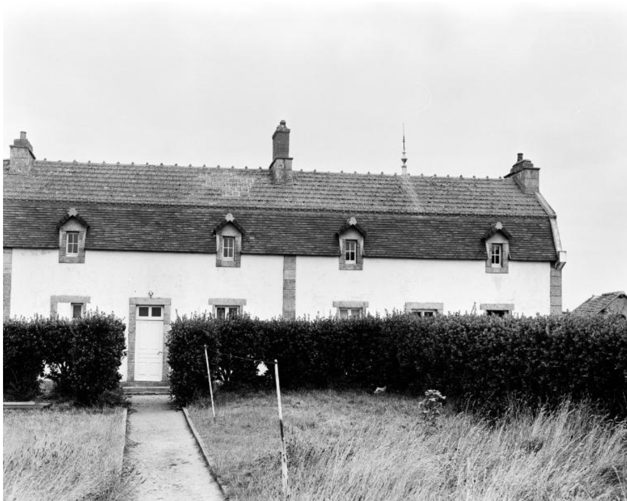
Logement, souche de cheminée nord, vue générale
