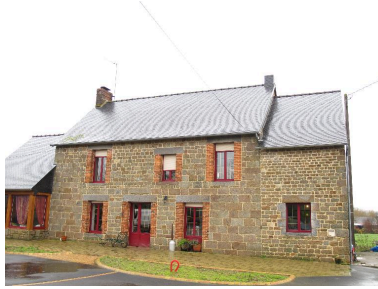
Maison construite avec des pierres de l'ancien château de la Chesnaye Phot. Stéphanie Bardel IVR53_20133518140NUCA
