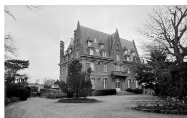
Vue de la façade antérieure sur jardin. Phot. Guy Artur, Phot. Norbert Lambart IVR53_19933501004X
