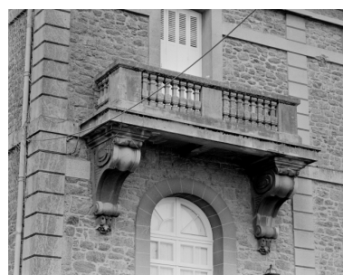
Vue de la façade antérieure sud, détail du balcon. Phot. Guy Artur, Phot. Norbert Lambart IVR53_19933501003X
