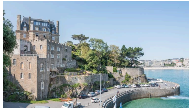
Vue générale depuis la Pointe du Moulinet, en second plan, l'anse de la plage de l'Ecluse Phot. Charlotte Barraud IVR53_20203500466NUCA
