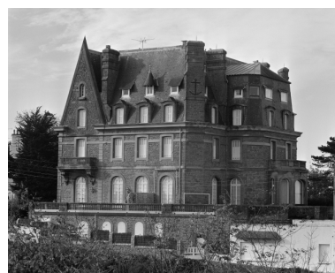
Vue rapprochée de la façade postérieure nord et de la façade latérale est du logis.. Phot. Guy Artur IVR53_19953500841X
