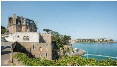
Vue prise depuis le "balcon d'Émeraude" Phot. Charlotte Barraud IVR53_20203500465NUCA
