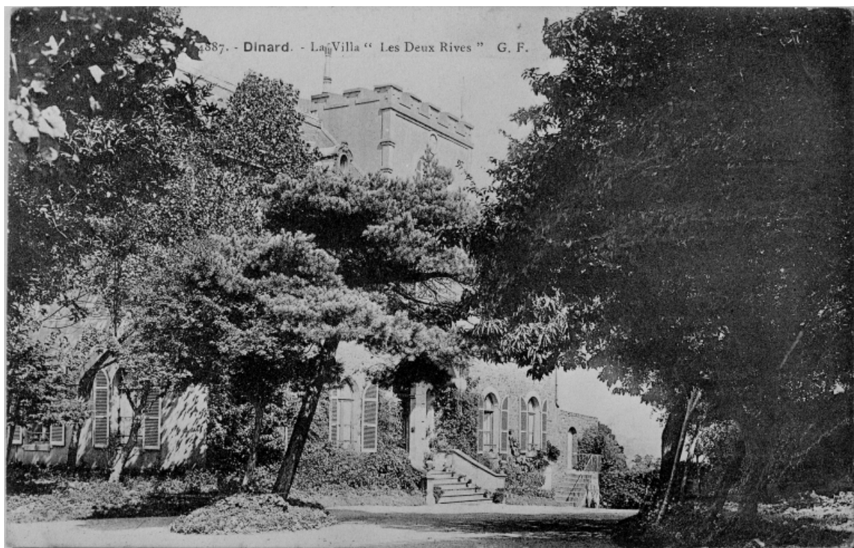
Carte postale ancienne. 4887. Dinard - Villa Les Deux Rives, 2eme état, vue sur le jardin.
