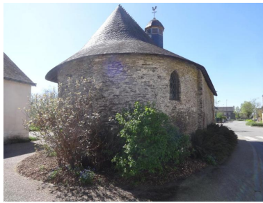
Vue générale nord-est Phot. Michèle Bureau IVR53_20255610280NUCA
