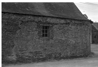
Vue du mur ouest Phot. Berthou Marie, Phot. Catherine Toscer IVR53_19765606214Z
