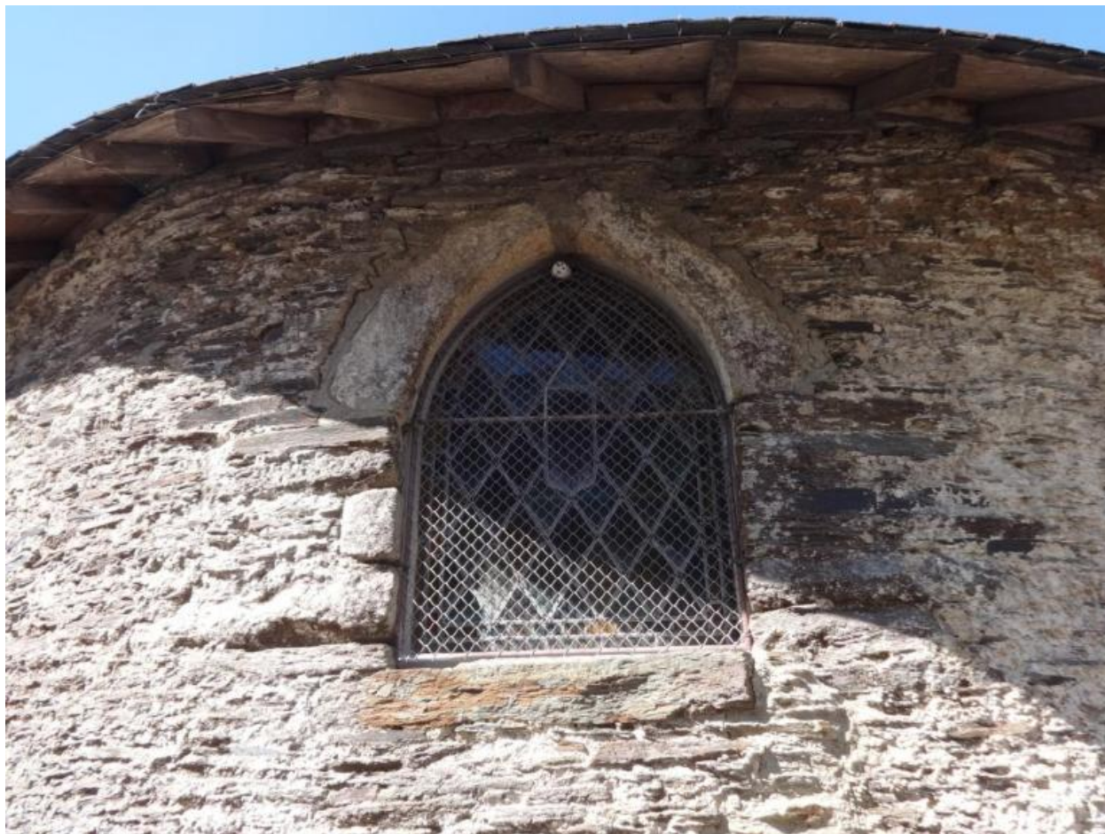
Détail, élévation nord
