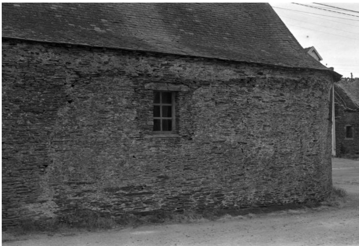
Vue du mur ouest
