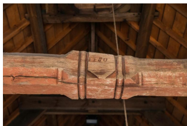
Poutre avec date Phot. Michèle Bureau IVR53_20255610282NUCA
