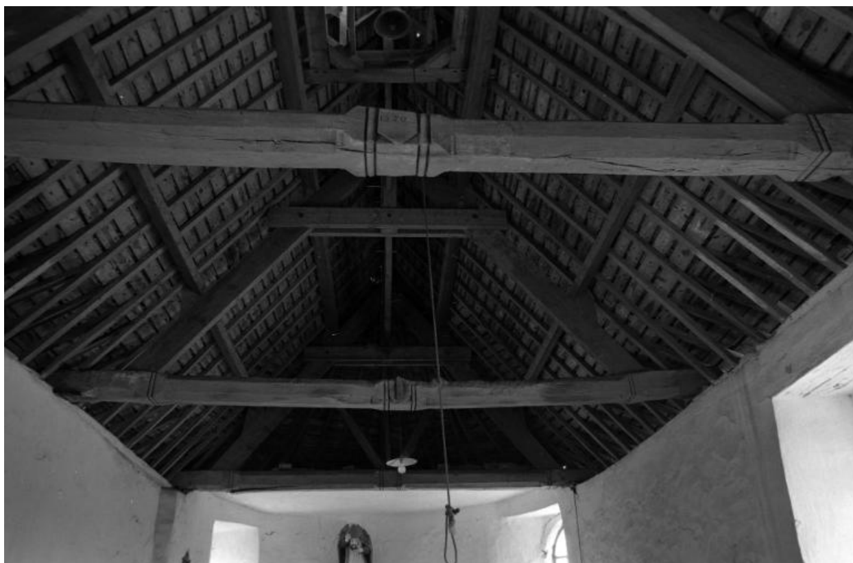
Vue de la charpente
