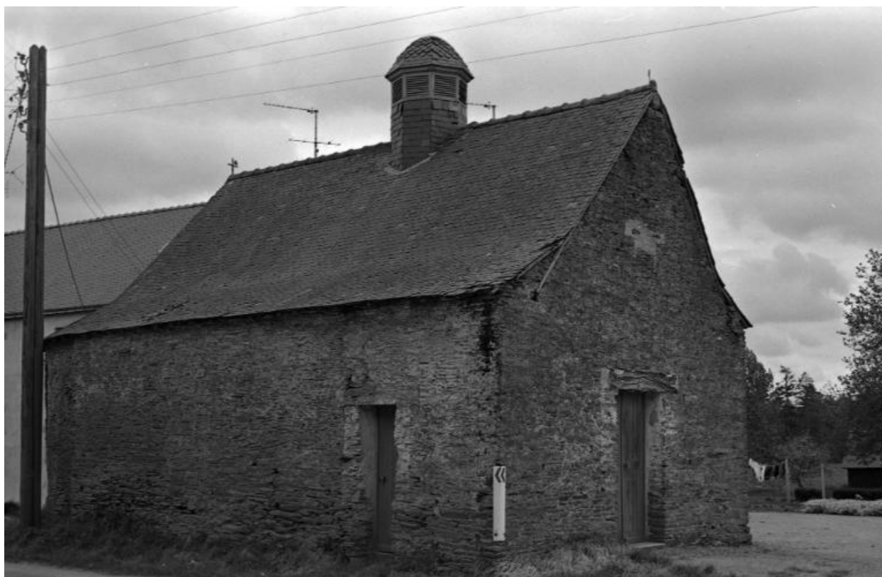
Vue du sud-ouest
