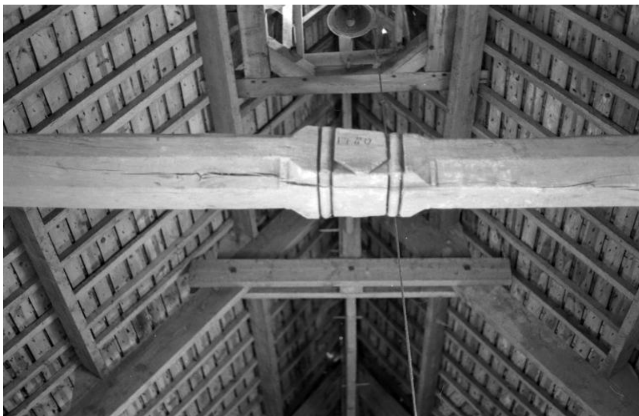
Vue de la charpente
