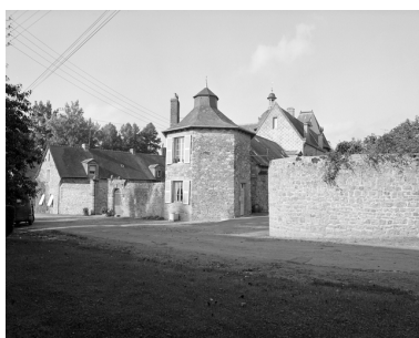
Vue générale sud-est. Phot. Guy Artur, Phot. Norbert Lambart IVR53_19843501353X
