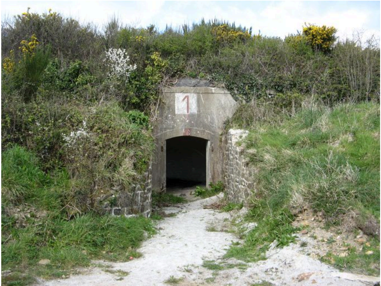
Soute de la batterie haute de Robert
