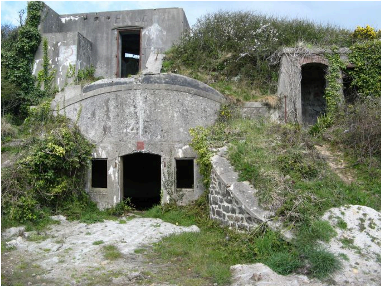
Magasin et poste de commandement de la batterie haute de Robert
