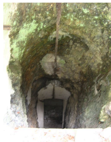
Intérieur d'un abri de la batterie haute de Robert Phot. Guillaume Marie IVR53_20082908430NUCA
