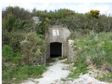
Soute de la batterie haute de Robert Phot. Guillaume Marie IVR53_20082908431NUCA
