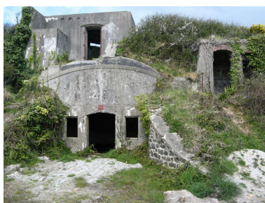
Magasin et poste de commandement de la batterie haute de Robert Phot. Guillaume Marie IVR53_20082908429NUCA
