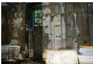
Vue intérieure : ouverture étroite de l'élévation ouest (état en 2013). La partie basse est murée par des parpaings Phot. Christian Moigne IVR53_20262910036NUCA
