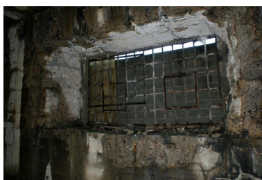
Vue intérieure : vestiges d'un châssis de fenêtre à petits carreaux (état en 2013). Cette ouverture située dans l'élévation ouest semble avoir été élargie Phot. Christian Moigne IVR53_20262910039NUCA
