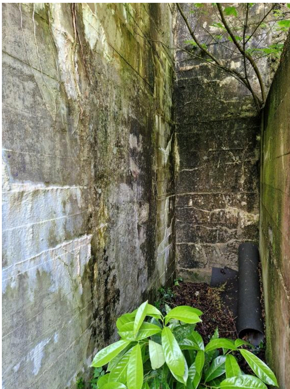
Vue de l'emplacement de l'entrée du sas nord (murée par des parpaings). Elle est protégée par un mur
