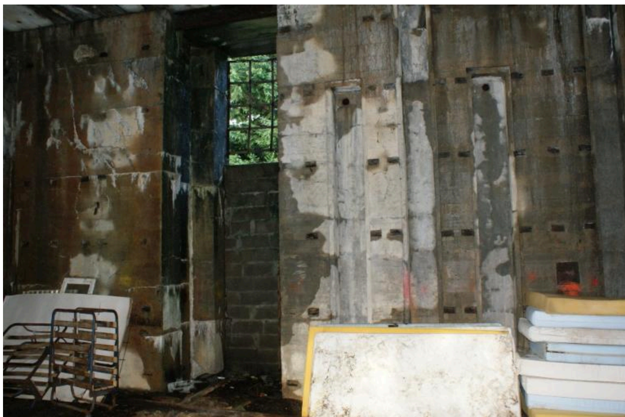
Vue intérieure : ouverture étroite de l'élévation ouest (état en 2013). La partie basse est murée par des parpaings
