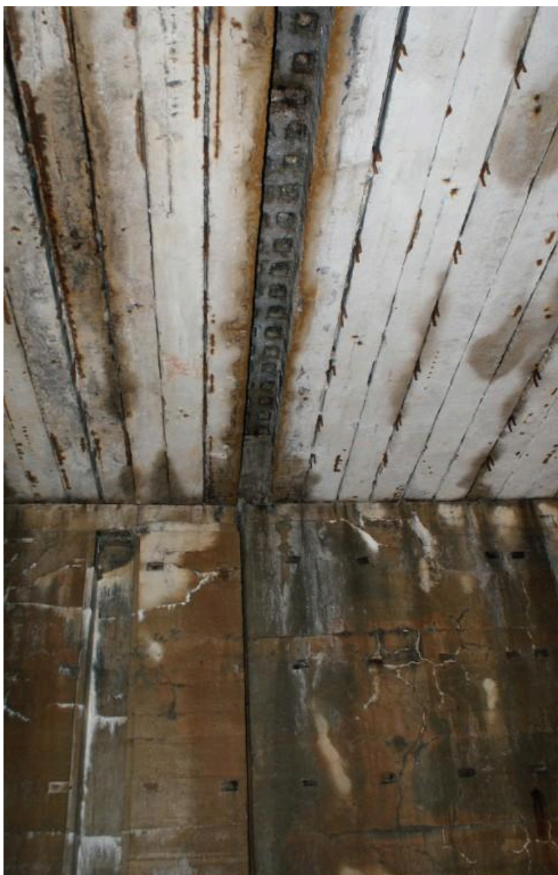
Vue intérieure : mur gouttereau et dalle de couverture supportée par des poutres en béton précontraint du système Hoyer (état en 2013)
