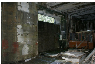
Vue intérieure : large ouverture est (état en 2013). La partie basse est murée par des parpaings Phot. Christian Moigne IVR53_20262910035NUCA
