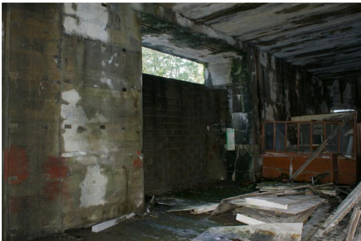
Vue intérieure : large ouverture est (état en 2013). La partie basse est murée par des parpaings
