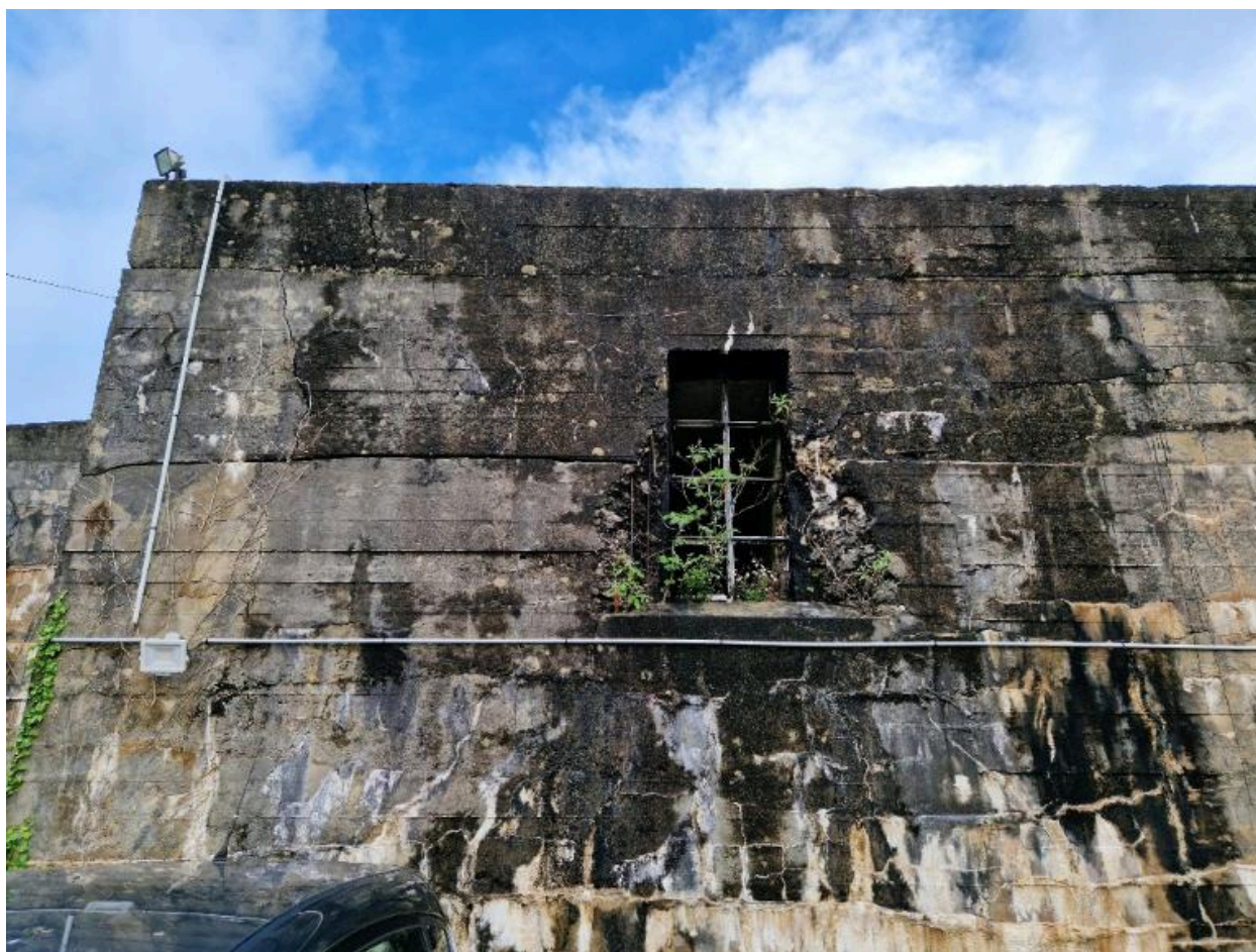
Vue de détail de l'élévation est : ouverture haute. On observe les vestiges d'un châssis de fenêtre
