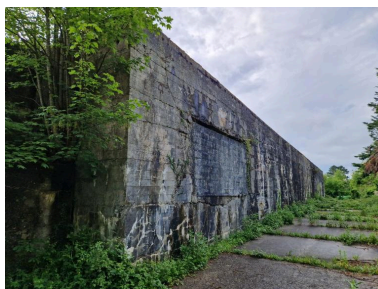
Vue générale de l'élévation ouest : on observe une large ouverture à mi-hauteur (murée par des parpaings). Autour du bunker se trouve une vaste aire bétonnée Phot. Guillaume Lécueillier IVR53_20262910015NUCA
