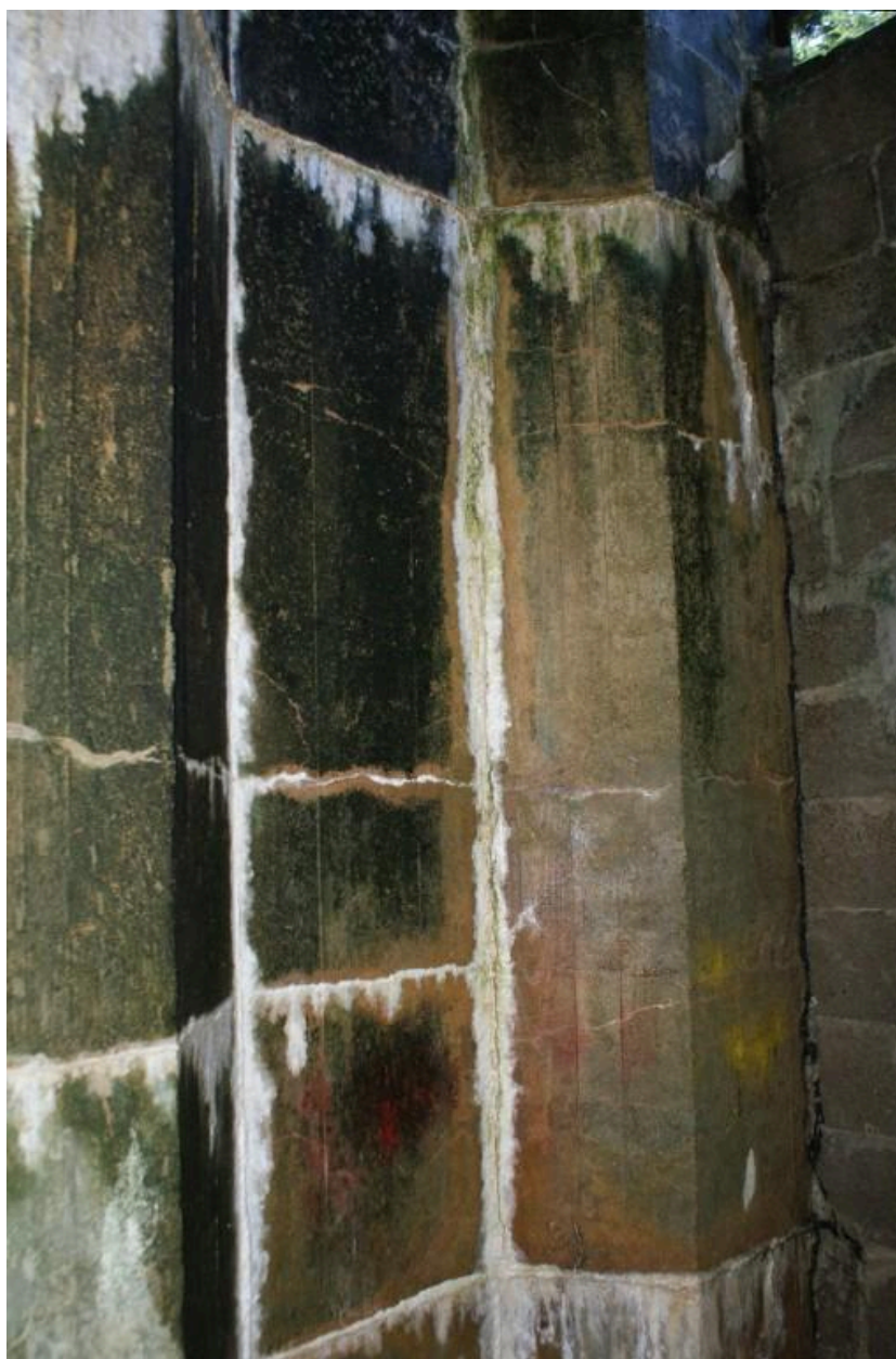
Vue intérieure : détail de l'embrasure de l'ouverture étroite est (état en 2013). La partie basse est murée par des parpaings
