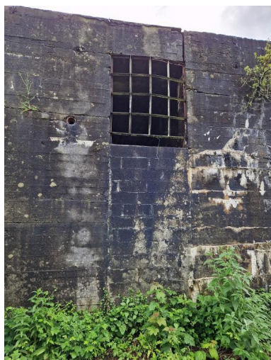
Vue de l'emplacement de l'entrée du sas nord (murée par des parpaings). Elle est protégée par un mur Phot. Guillaume Lécueillier IVR53_20262910014NUCA
