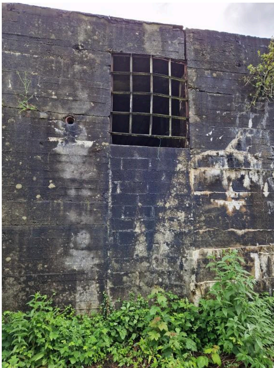
Vue de détail de l'élévation ouest : haute ouverture (la partie basse est murée par des parpaings). On observe les vestiges d'un châssis de fenêtre
