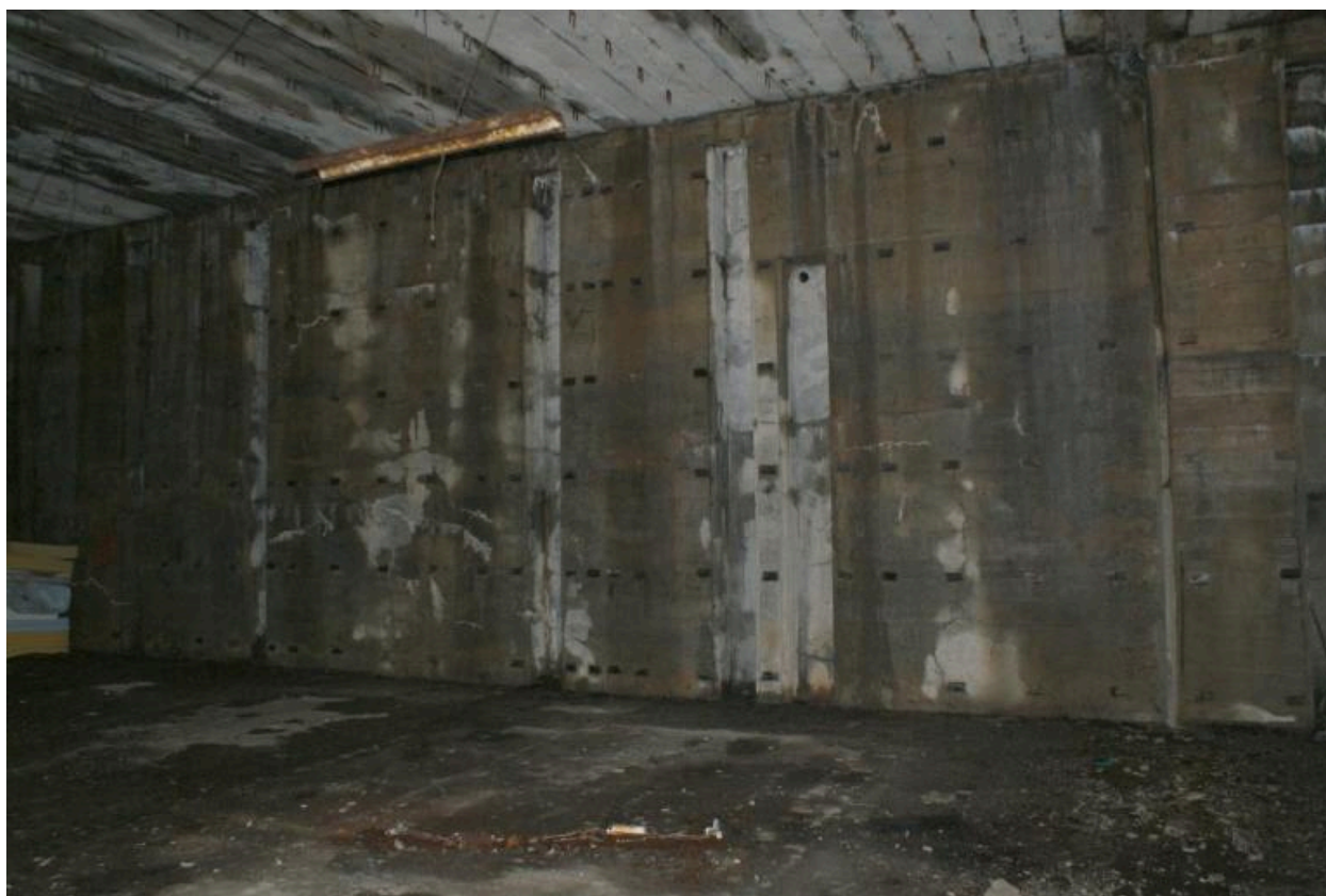
Vue intérieure : mur gouttereau et dalle de couverture supportée par des poutres en béton précontraint du système Hoyer (état en 2013)
