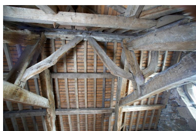
Charpente au -dessus du choeur. Phot. Bernard Bègne IVR53_20152200731NUCA
