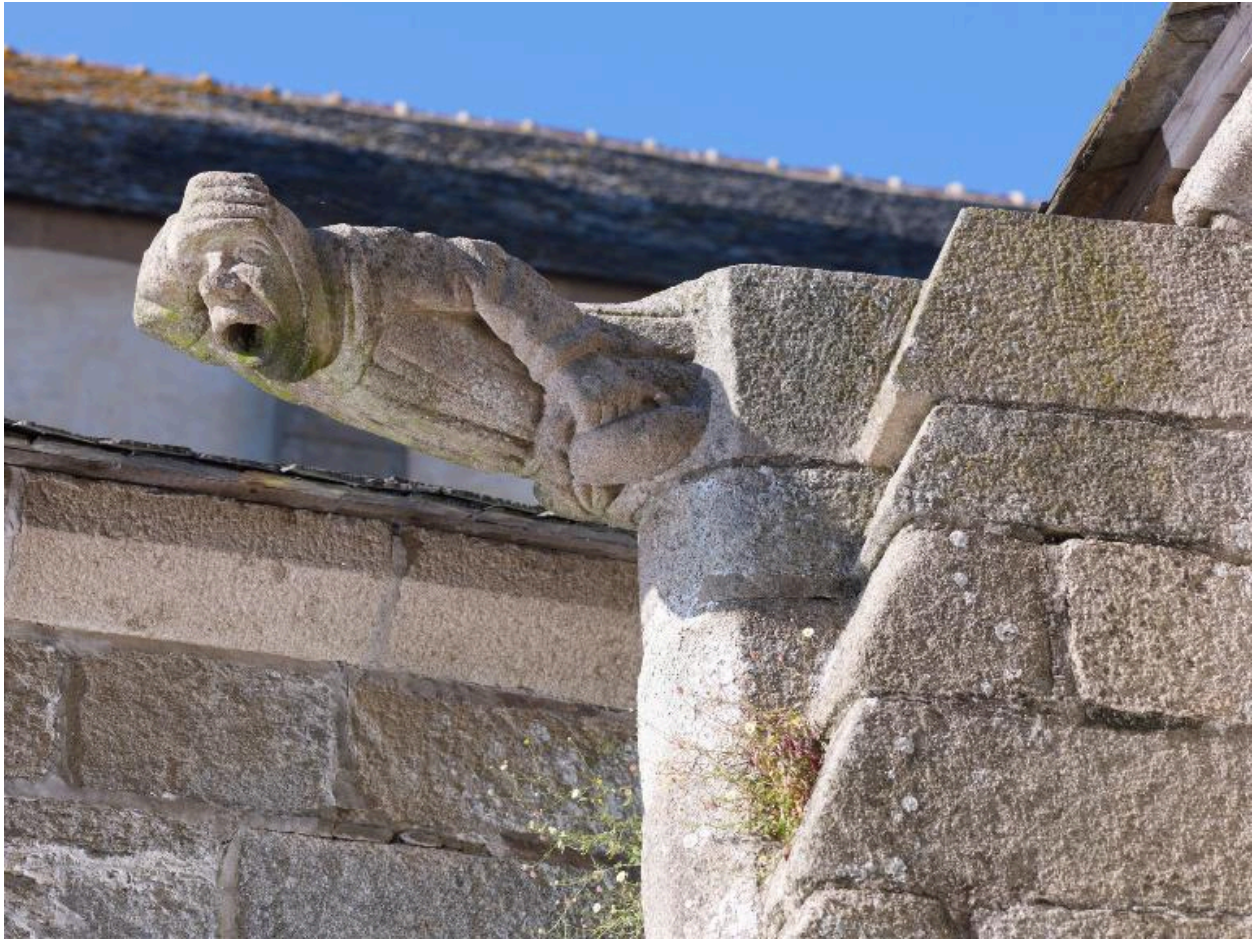
Chapelle sud. Détail d'une gargouille
