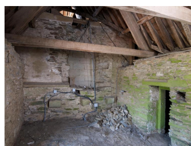
Construction d'angle nord-est. Vue intérieure de la pièce haute située à l'est avec ancienne fenêtre donnant sur le vaisseau central Phot. Bernard Bègne IVR53_20142201175NUCA
