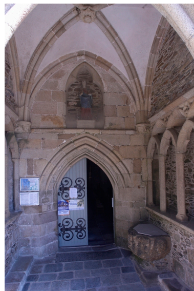
Porche sud. Vue générale intérieure sud Phot. Bernard Bègne IVR53_20092200193NUCA
