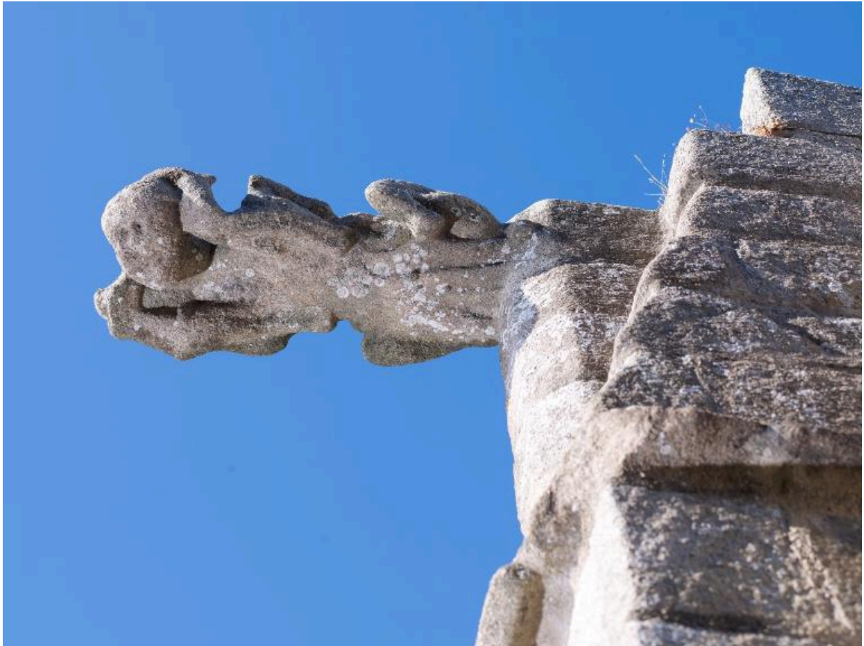
Chapelle sud. Détail du dessous d'une gargouille
