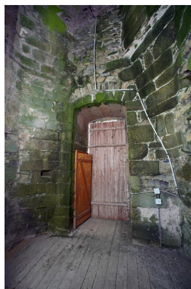
Tour sud-ouest, pièce de l'étage, revers de la porte haute pour hisser les cloches. Phot. Bernard Bègne IVR53_20152200724NUCA
