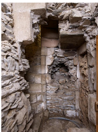
Construction d'angle nord-est. Détail du sas et de l'escalier en vis Phot. Bernard Bègne IVR53_20142201171NUCA
