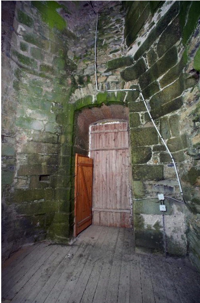
Tour sud-ouest, pièce de l'étage, revers de la porte haute pour hisser les cloches.
