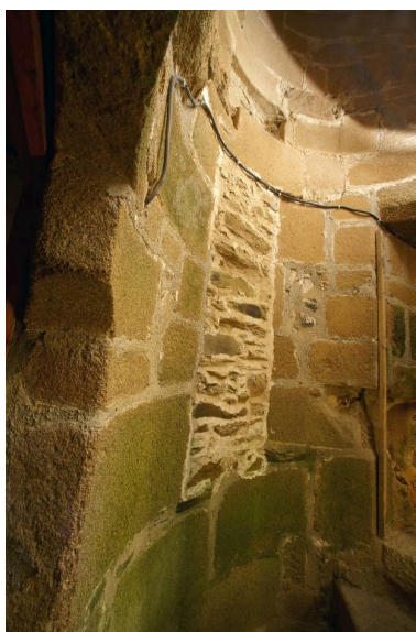
Massif nord-ouest ouverture murée dans la cage de l'escalier. Phot. Bernard Bègne IVR53_20152200655NUCA
