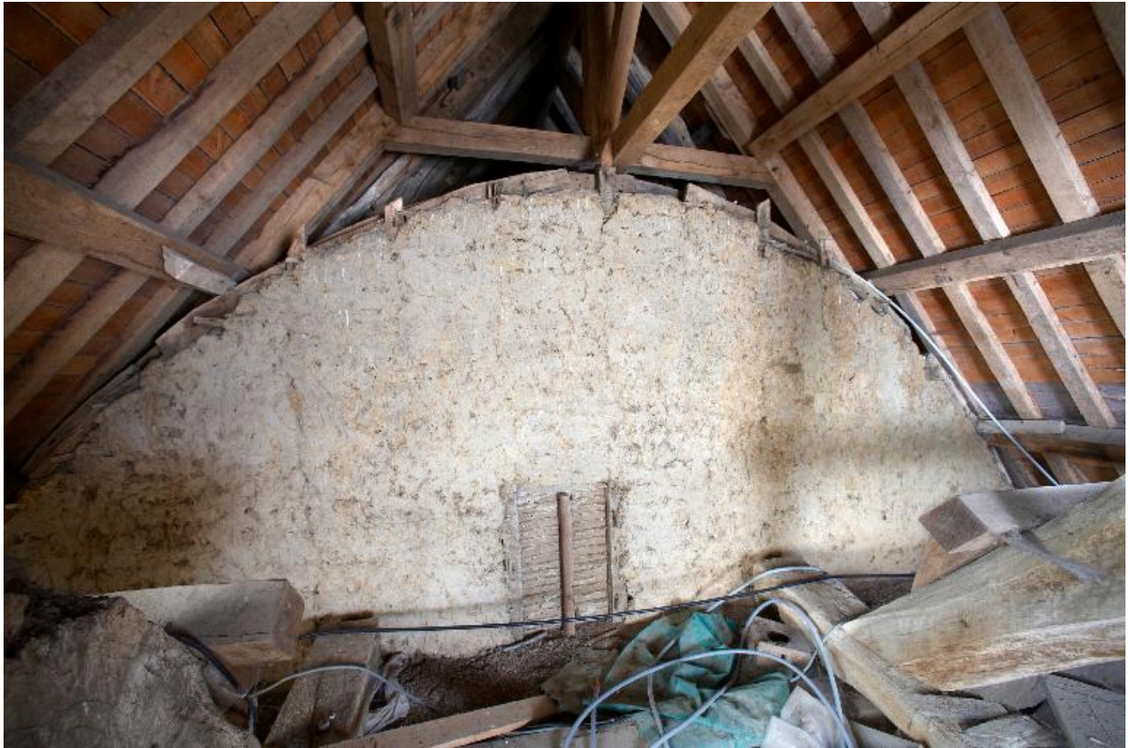
Raccord entre le comble du choeur et le bras sud avec cloison en torchis.
