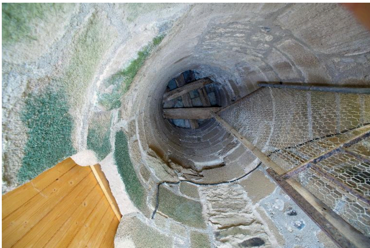
Massif nord-ouest, escalier en vis, vue vers le sommet avec traces de marches arrachées.
