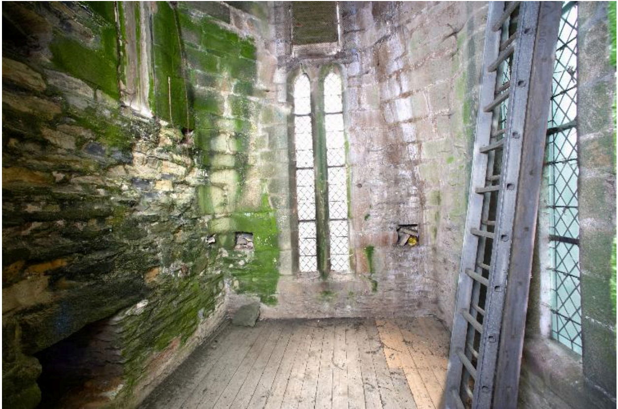
Tour sud-ouest, pièce de l'étage.
