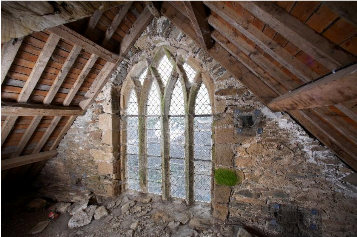
Comble du choeur, revers du pignon oriental avec grande baie à lancettes.
