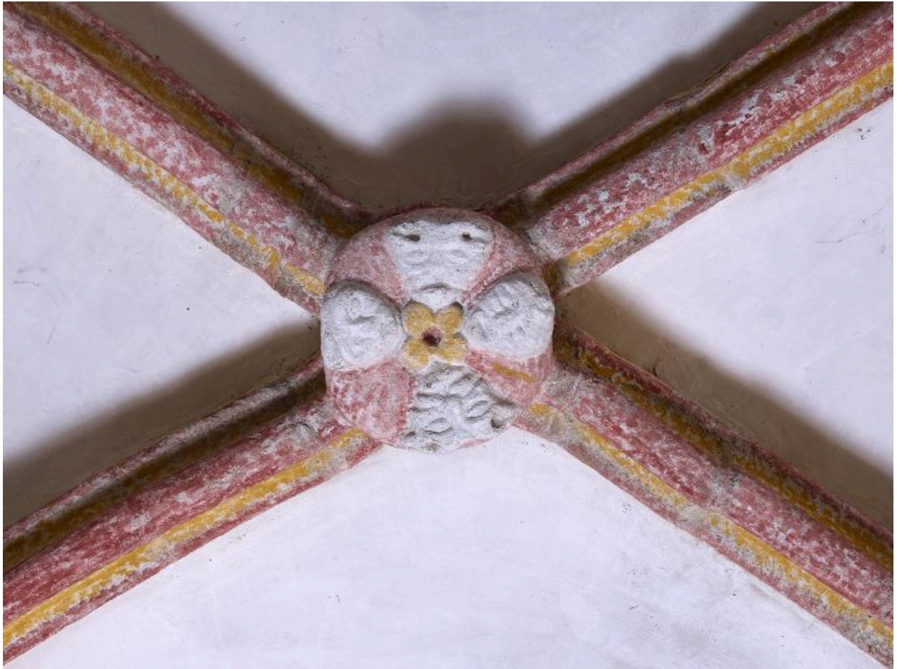
Collatéral nord. Détail d'une clef de voûte
