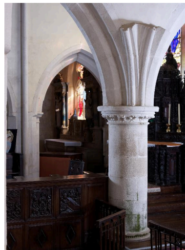
Chapelle sud. Détail d'un pilier et d'un départ de voute Phot. Bernard Bègne IVR53_20142200392NUCA
