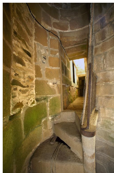
Massif nord-ouest, arrivée de l'escalier en vis sur la coursière ouest. Phot. Bernard Bègne IVR53_20152200656NUCA
