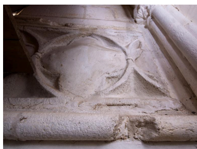
Nef. Ancienne tribune située à l'ouest partiellement dissimulée par le buffet d'orgue. Détail d'un quadrilobe bouché Phot. Bernard Bègne IVR53_20142201182NUCA
