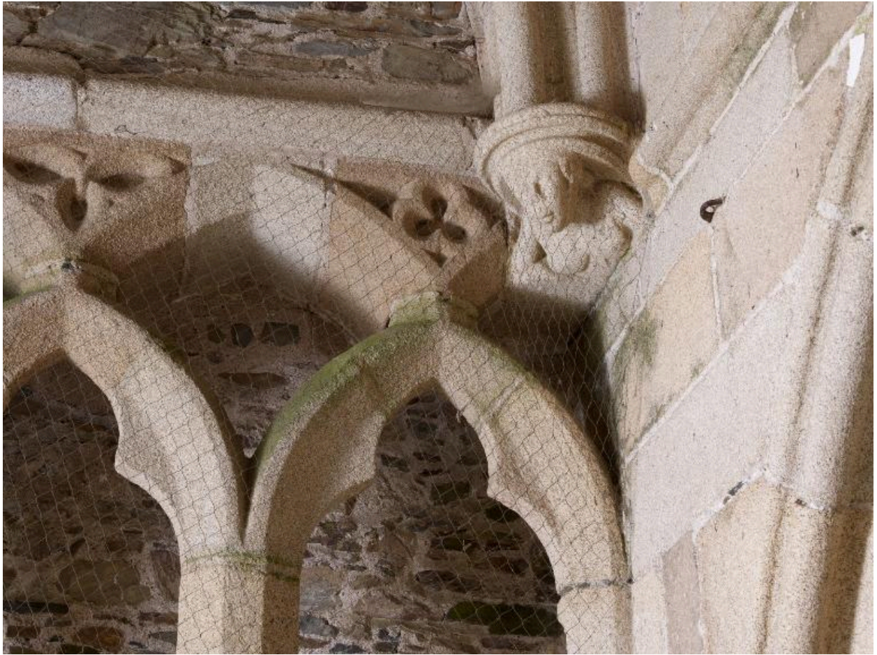
Porche sud. Détail du décor d'arcatures évidées détachées des parois latérales et de la retombée de la voûte sur un culot figuré
