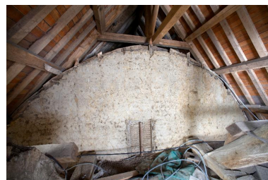
Raccord entre le comble du choeur et le bras sud avec cloison en torchis. Phot. Bernard Bègne IVR53_20152200730NUCA
