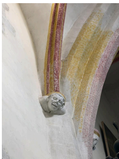
Collatéral nord. Retombée des voûtes. Détail d'un culot sculpté d'un personnage en buste Phot. Bernard Bègne IVR53_20142201135NUCA
