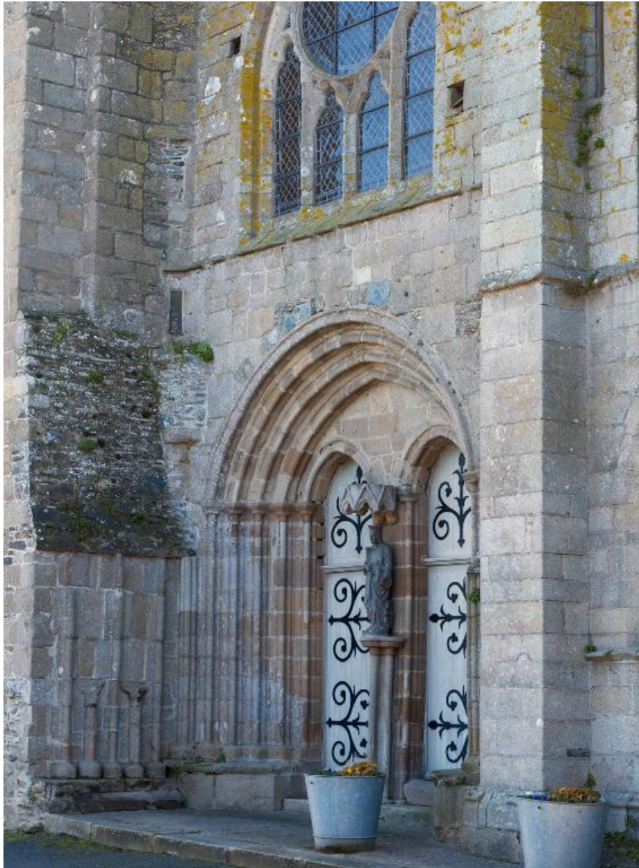
Façade ouest. Le portail
