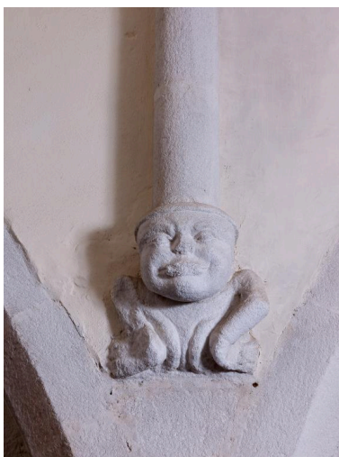
Nef. Colonne portée par un culot sculpté d'un moine en buste Phot. Bernard Bègne IVR53_20142201133NUCA
