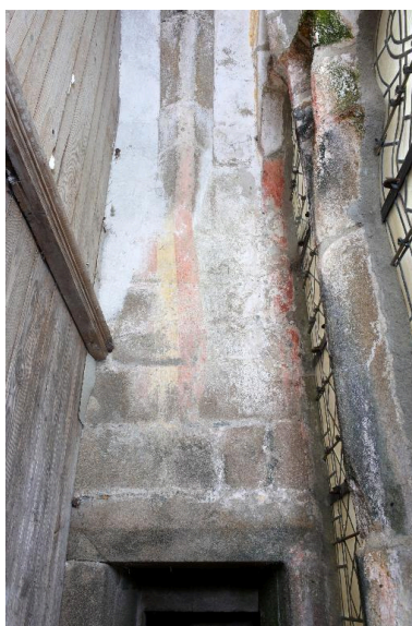
Revers façade occidentale, ébrasement, vestiges de décor peint. Phot. Bernard Bègne IVR53_20152200720NUCA
