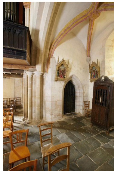
Porte d'accès dans le massif nord-ouest du côté du colalléral nord. Phot. Bernard Bègne IVR53_20152200648NUCA
