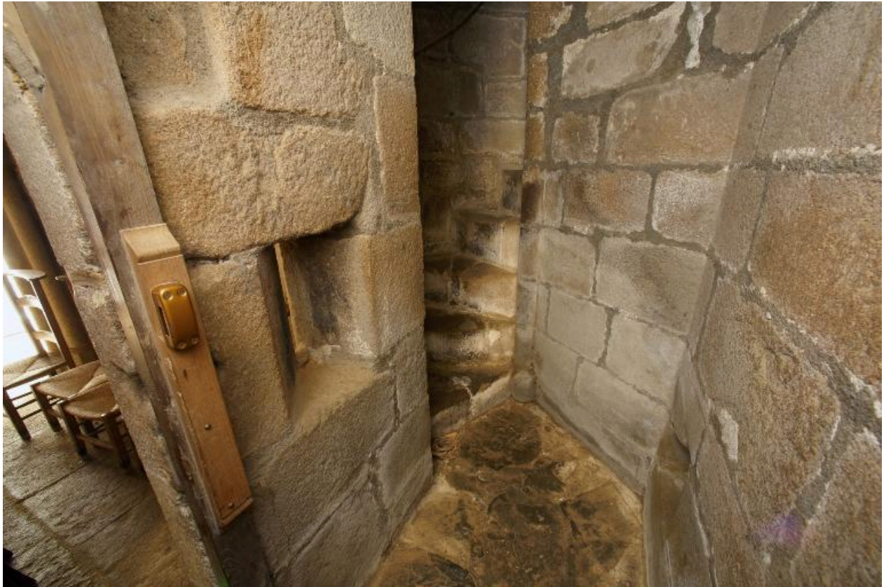
Massif nord-ouest, intérieur du sas d'accès à l'escalier en vis.
