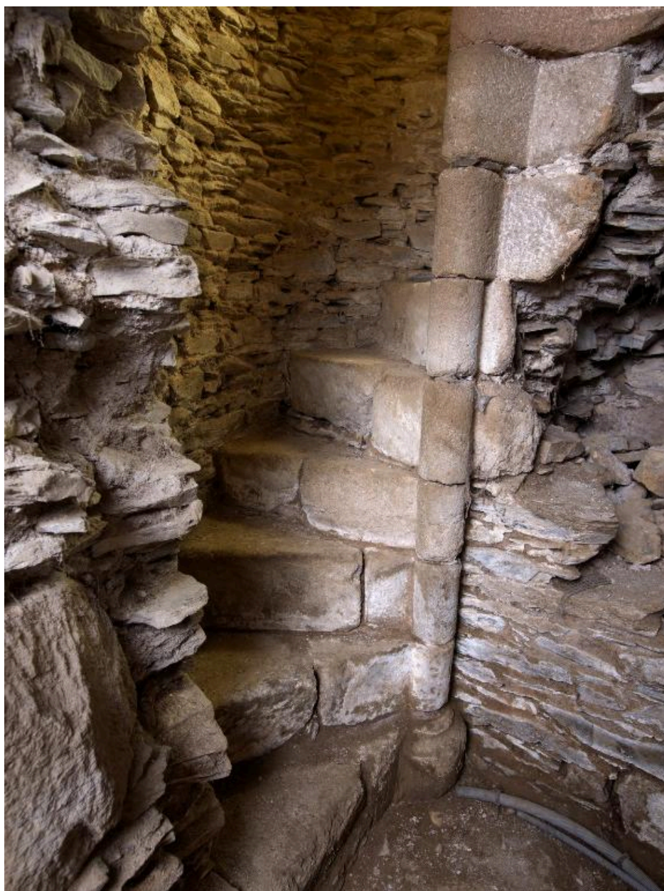
Construction d'angle nord-est. Détail de l'escalier en vis
