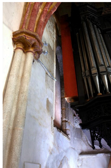
Tour sud-ouest, mur nord, porte haute pour hisser les cloches. Phot. Bernard Bègne IVR53_20152200718NUCA
