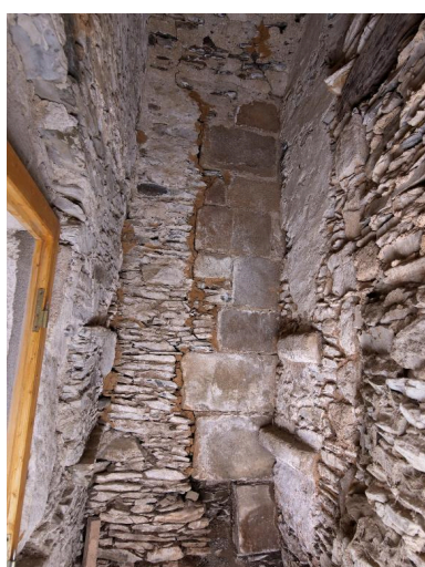
Construction d'angle nord-est. Sas. Détail Phot. Bernard Bègne
