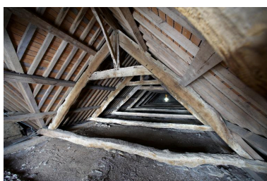
Charpente du vaisseau central, vue générale vers l'ouest. Phot. Bernard Bègne IVR53_20152200732NUCA
