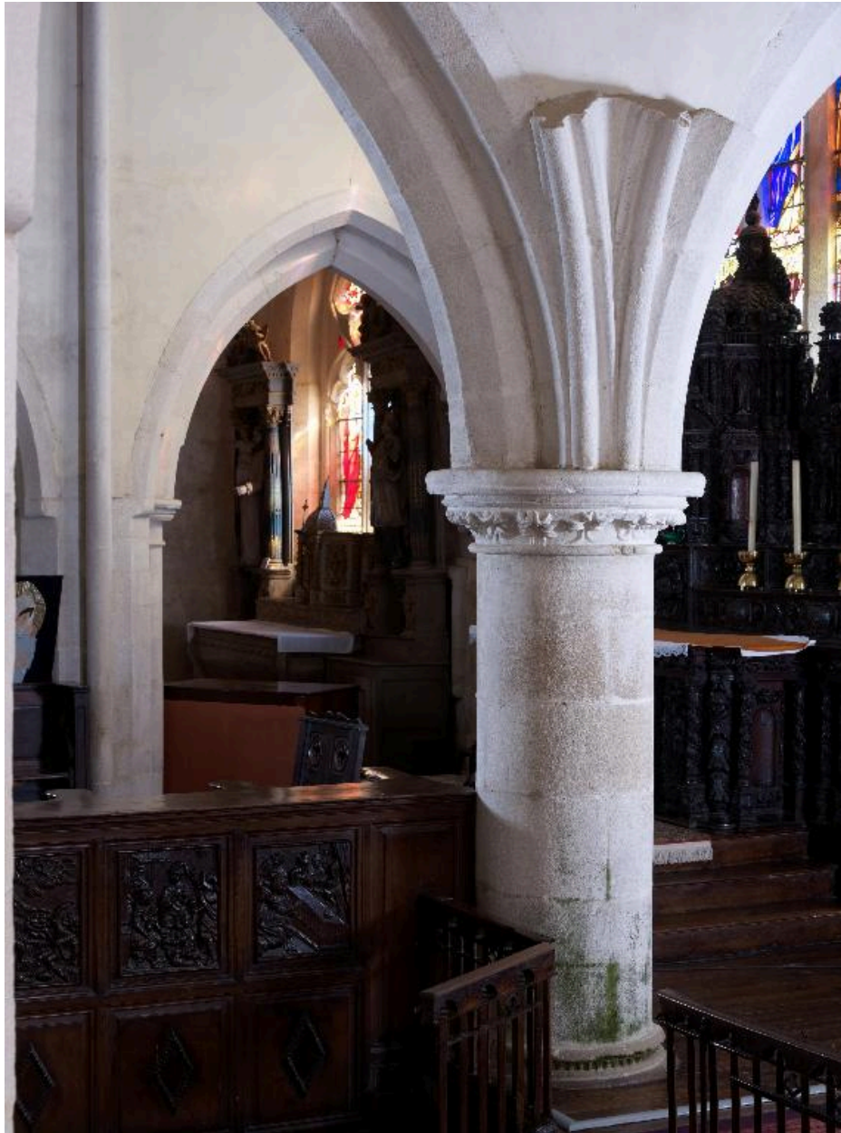
Chapelle sud. Détail d'un pilier et d'un départ de voute
