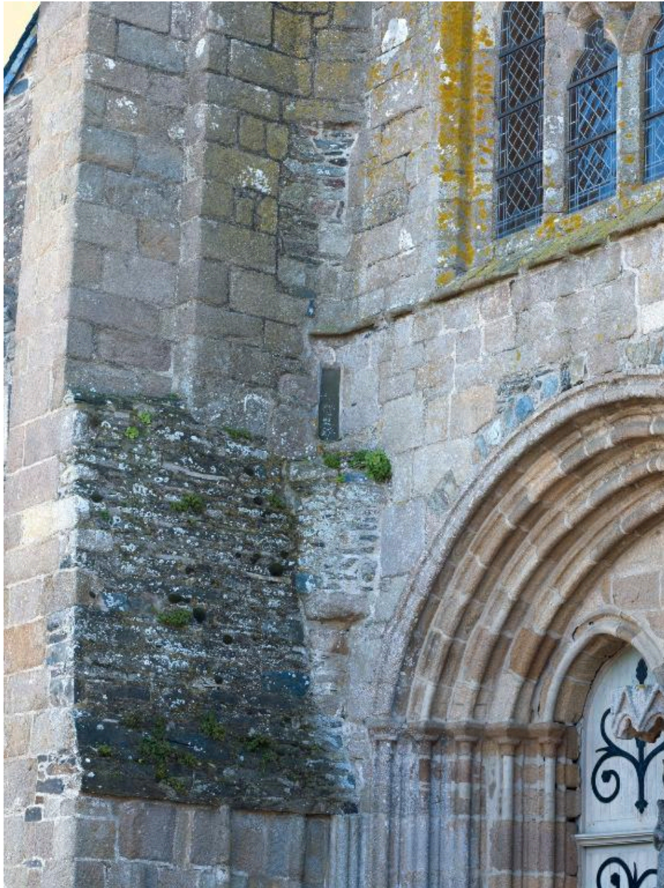
Façade ouest. Détail d'une fenêtre et d'un jour de tir bouchés
