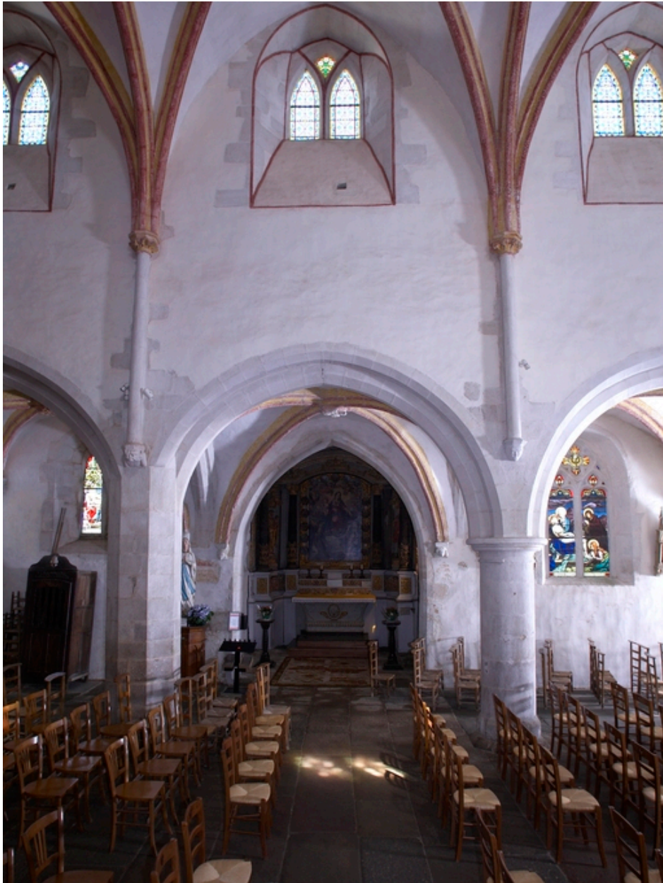
Travée centrale de la nef et chapelle nord. Vue générale intérieure sud
