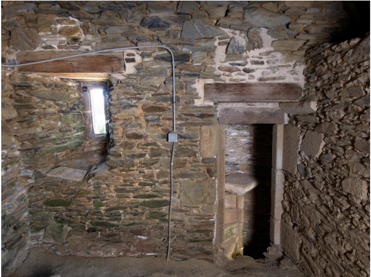
Construction d'angle nord-est. Pièce haute située au nord. Vue intérieure avec desserte de l'escalier en vis et jour
