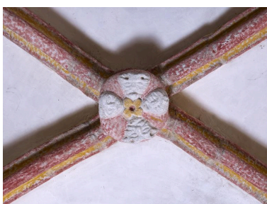
Collatéral nord. Détail d'une clef de voûte Phot. Bernard Bègne IVR53_20142201129NUCA
