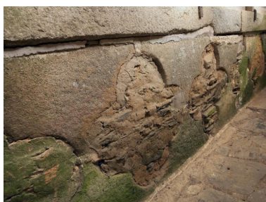
Revers de l'ancienne tribune dissimulée derrière le buffet d'orgue. Détail des motifs quadrilobés bouchés Phot. Bernard Bègne IVR53_20142201180NUCA
