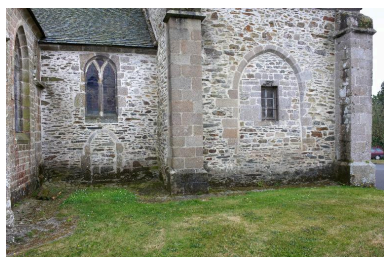
Massif nord-ouest, vue extérieur du nord. Phot. Bernard Bègne IVR53_20152200737NUCA
