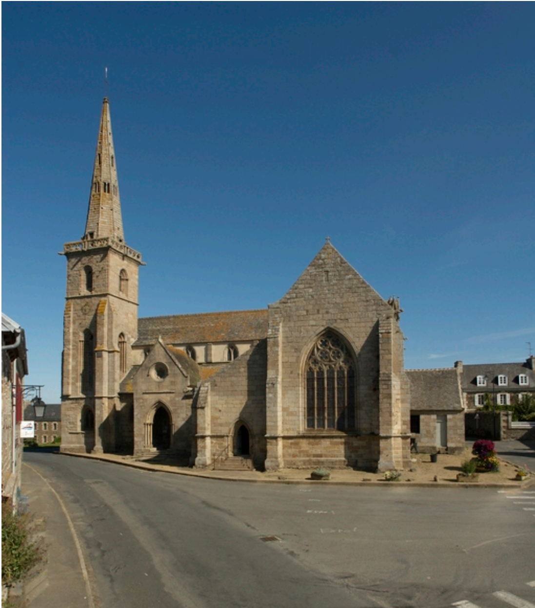
Vue générale sud
