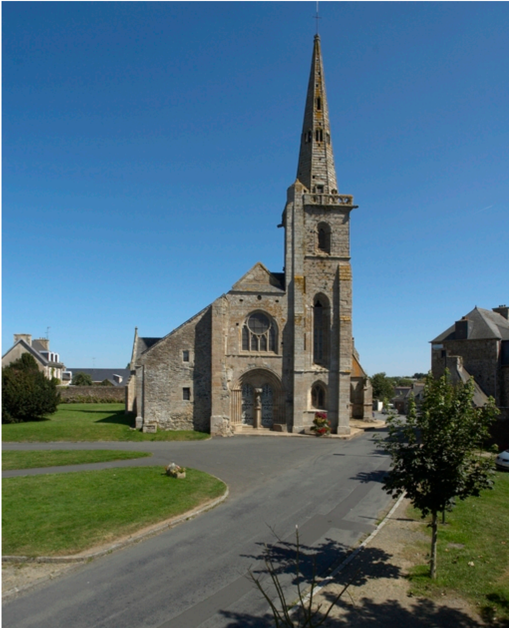
Vue générale ouest
