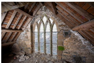
Comble du choeur, revers du pignon oriental avec grande baie à lancettes. Phot. Bernard Bègne IVR53_20152200729NUCA
