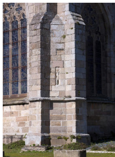
Chapelle sud. Contrefort sud-est. Détail d'un jour de tir bouché Phot. Bernard Bègne IVR53_20152200242NUCA
