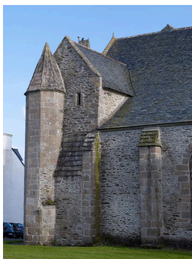
Construction d'angle nord- est. vue générale nord
