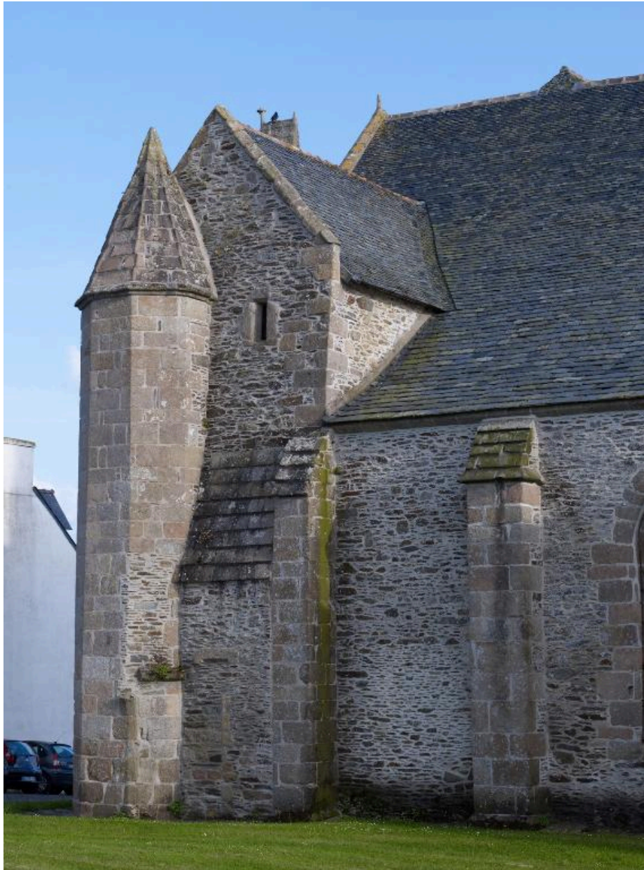
Construction d'angle nord-est. vue générale nord
