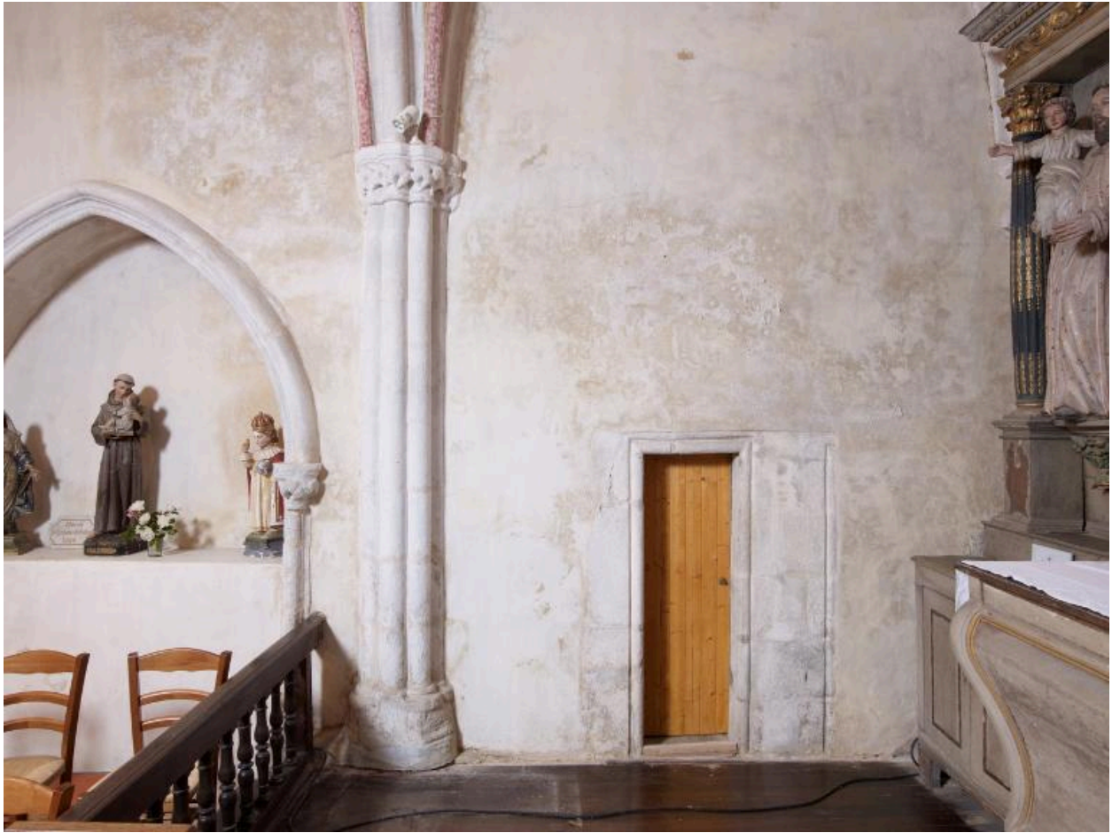
Bas-côté du chœur. Détail de la porte ouvrant sur la tour d'angle nord-est
