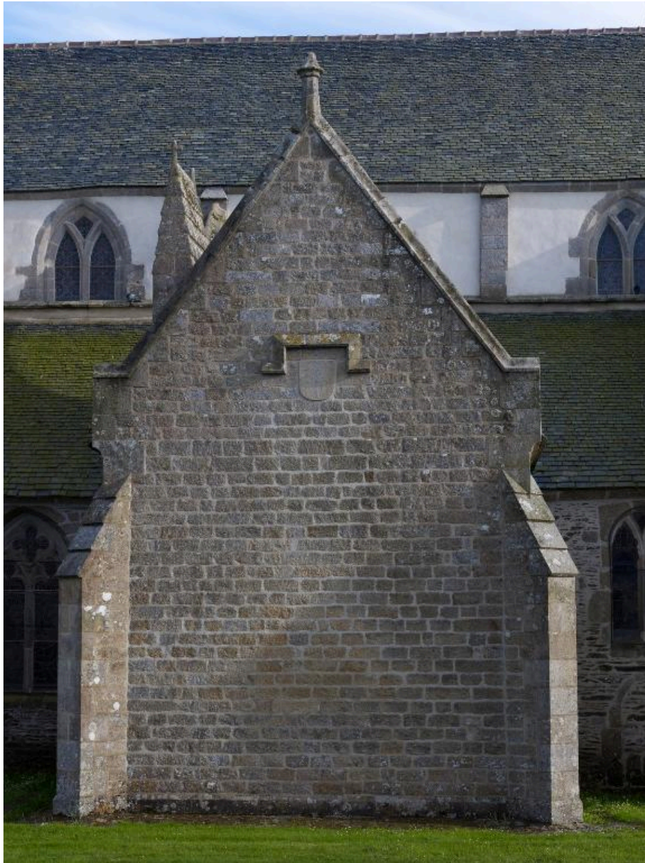
Chapelle nord. Pignon nord
