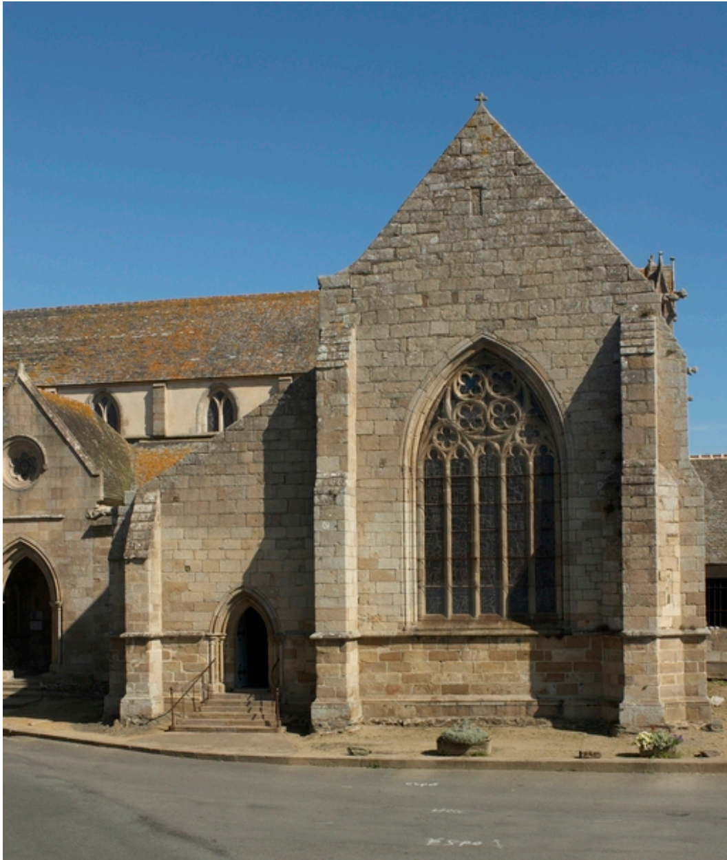
Chapelle et porche sud. Vue générale sud
