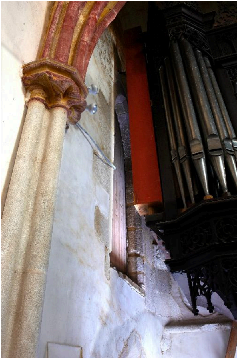
Tour sud-ouest, mur nord, porte haute pour hisser les cloches.
