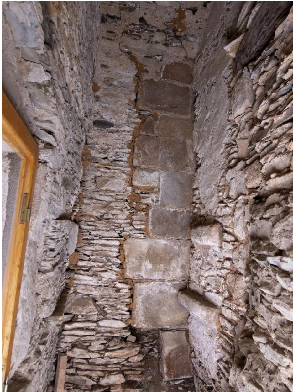
Construction d'angle nord-est. Sas. Détail
