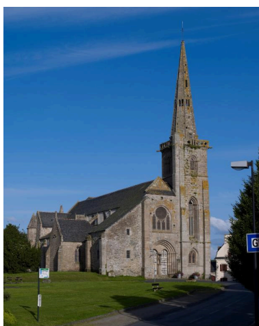
Vue générale nord-ouest Phot. Bernard Bègne IVR53_20142200681NUCA
