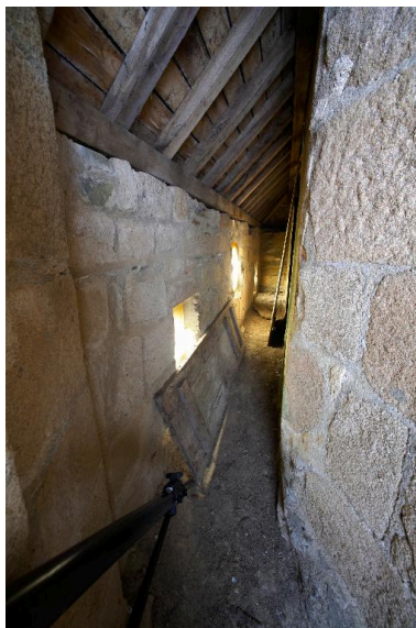
Coursière au sommet de la façade occidentale. Phot. Bernard Bègne IVR53_20152200726NUCA
