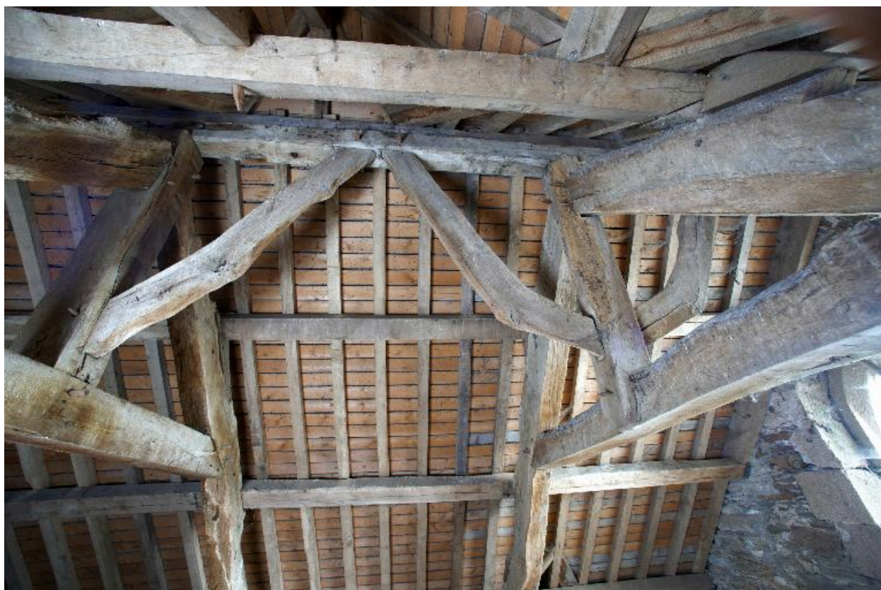
Charpente au -dessus du chœur.
