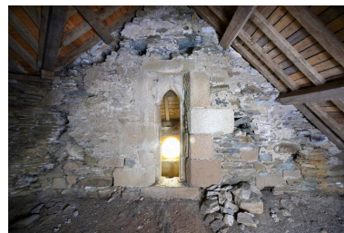
Revers du pignon de la façade occidentale depuis le comble. Phot. Bernard Bègne IVR53_20152200727NUCA
