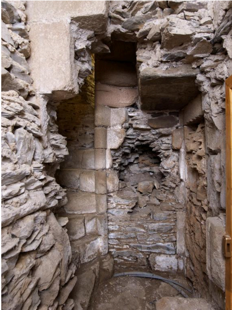
Construction d'angle nord-est. Détail du sas et de l'escalier en vis
