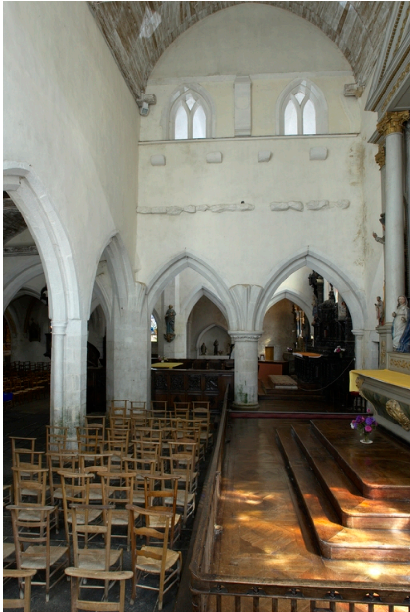
Chapelle sud. Vue générale intérieure sud
