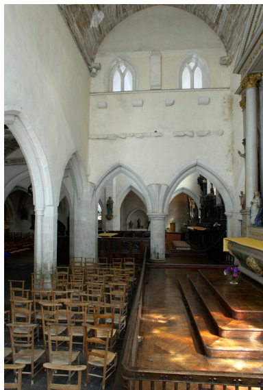
Chapelle sud. Vue générale intérieure sud Phot. Bernard Bègne IVR53_20092200192NUCA
