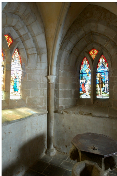
Chapelle des fonds. Vue intérieure Phot. Bernard Bègne IVR53_20092200197NUCA
