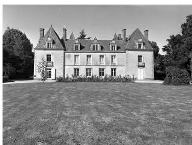
Le logis : vue générale sud Phot. François Dagorn IVR53_19775600932X
