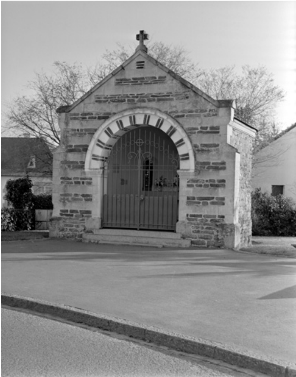
Elévation sud-est et chevet.
