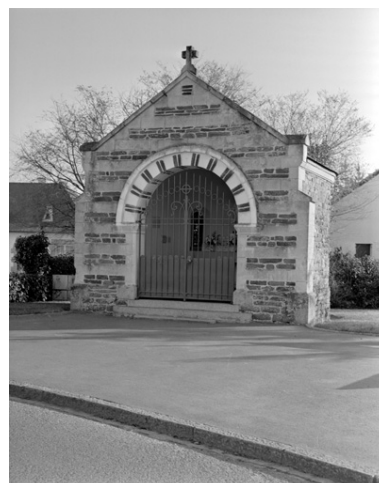
Elévation sud-est et chevet. Phot. M. Loyon IVR53_19933500118X
