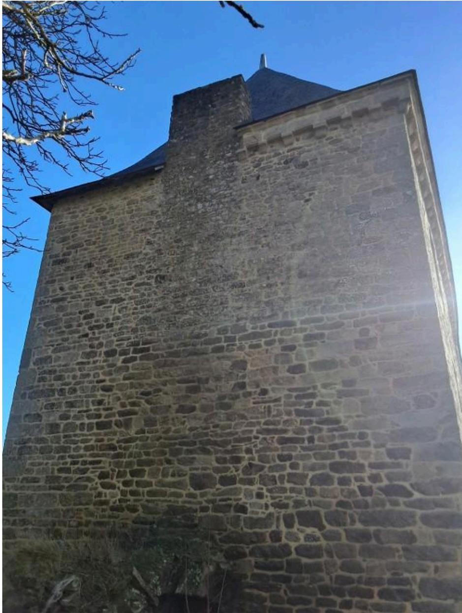
Façade ouest, détail : scission entre la façade antérieure et postérieure avec l'arrêt de la corniche réservée à la façade principale
