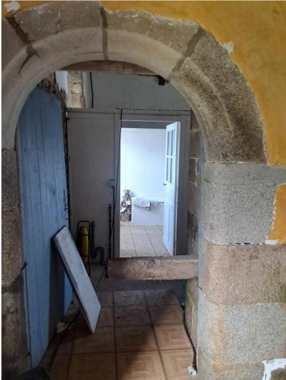
Rez-de-chaussée vue sur la porte cintrée en granit de taille, détail : Bâti de porte, élément défensif pour barrer la porte
