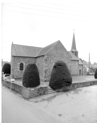
Elévation Nord : vue générale Phot. Guy Artur, Phot. Norbert Lambart IVR53_19943500731X
