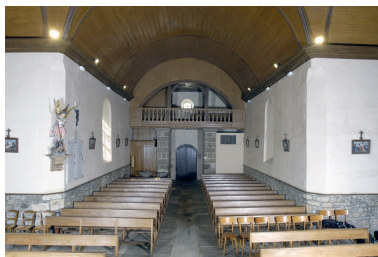
Vue intérieure prise du chœur vers la nef Phot. Alain Dagorn IVR53_20063500589NUCA
