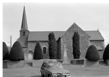
Vue générale en 1976 Phot. E. Morel IVR53_19763505000Z
