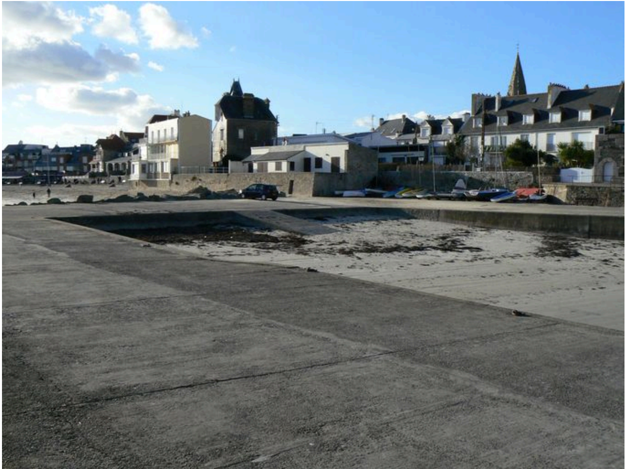
Vue générale de Port Maria avec rampe (premier plan) et terre-plein (arrière-plan)
