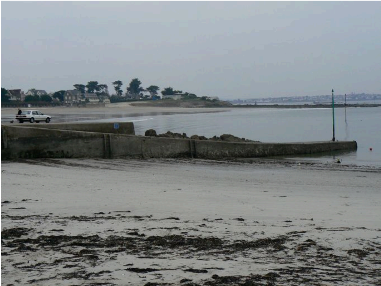
Vue générale de la cale récente de Port Maria
