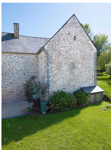
L'avancée nord, vue depuis la rue de la Commanderie. Phot. Bernard Bègne IVR53_20182200461NUCA
