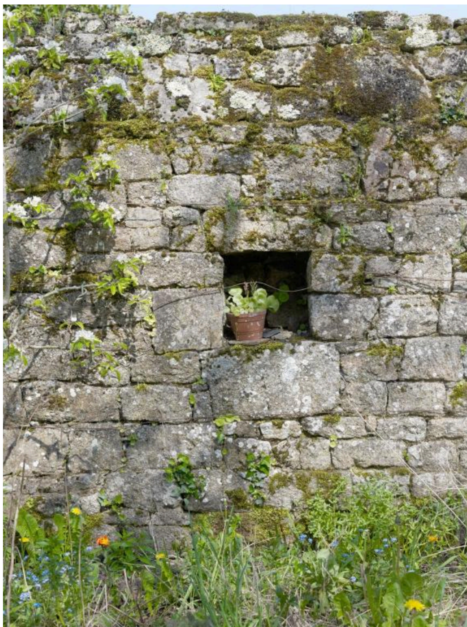
Détail d'une niche à ruche.
