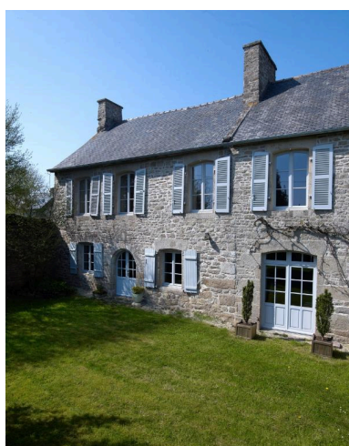
Partie la plus ancienne de l'édifice, à l'ouest. Phot. Bernard Bègne IVR53_20182200341NUCA
