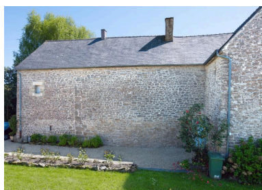
Le mur nord aveugle, vu depuis la rue de la Commanderie. Phot. Bernard Bègne IVR53_20182200460NUCA
