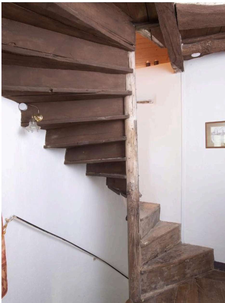
Prolongement de l'escalier à vis, réalisé en bois à l'étage.
