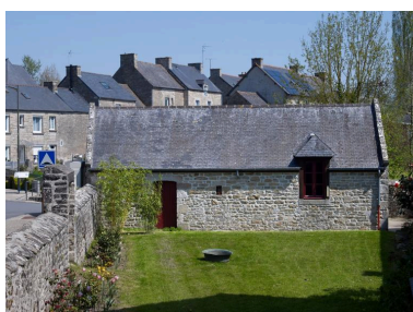
Façade ouest de la dépendance contemporaine. Phot. Bernard Bègne IVR53_20182200338NUCA
