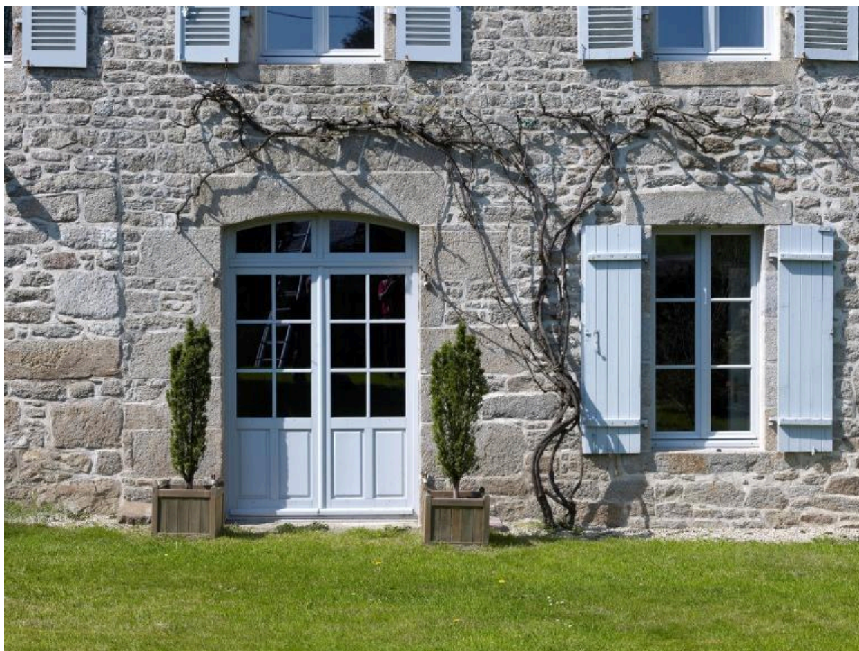
Ouvertures de la partie centrale en façade sud.
