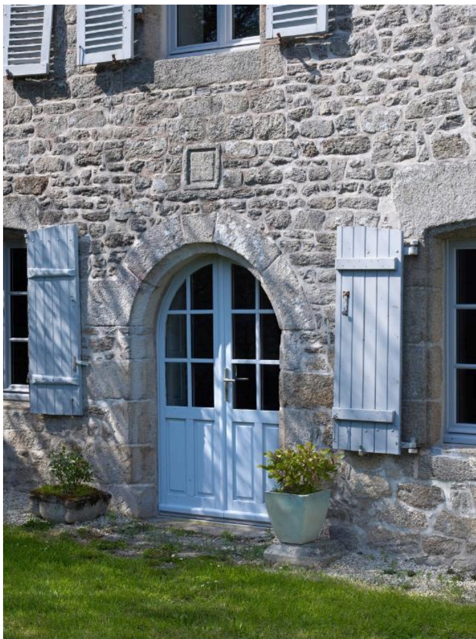
Ouverture en plein-cintre du XVIIe siècle, surmontée d'un élément de décor sculpté (mur sud).
