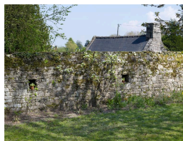
Le mur rucher côté ouest. Phot. Bernard Bègne IVR53_20182200344NUCA
