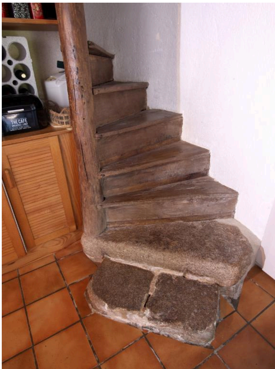
Vue rapprochée de l'escalier à vis.
