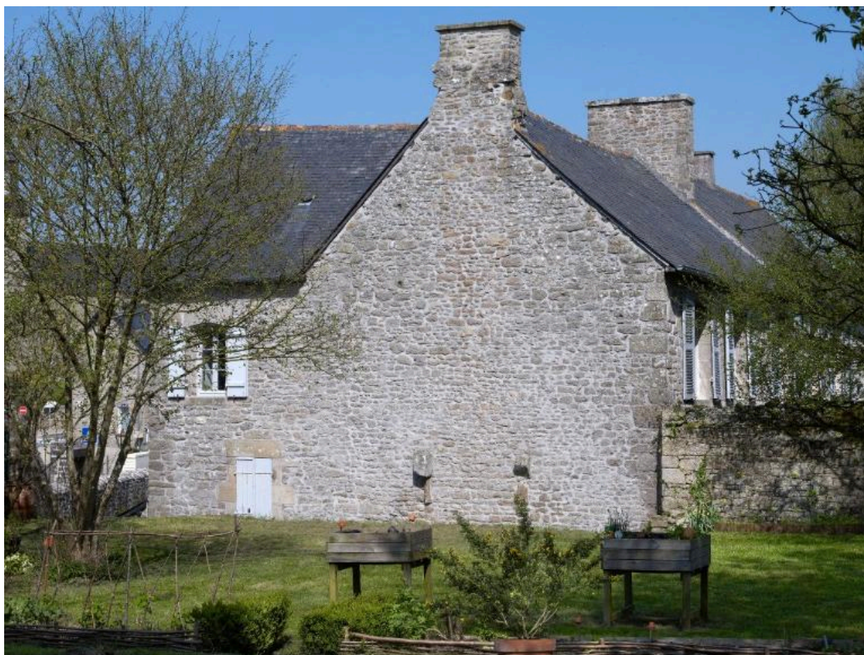
Mur pignon ouest.
