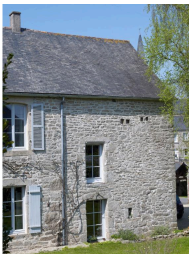
Les anciennes dépendances à l'est, avec trous de pigeons. Phot. Bernard Bègne IVR53_20182200346NUCA
