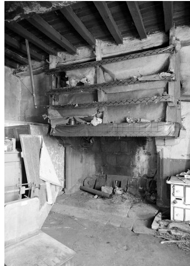
Cheminée au rez-de-chaussée pièce E de la partie occidentale du manoir Phot. Guy Artur IVR53_19712200146V
