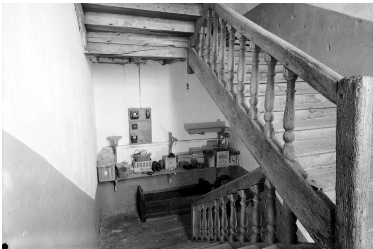
Escalier : vue générale
