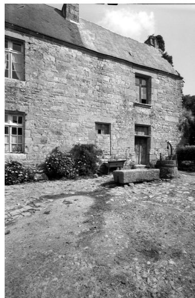
Façade sud du logis, détail partie est Phot. François Dagorn IVR53_19682200345V
