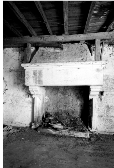
Etage, pièce est : cheminée Phot. François Dagorn IVR53_19682200348V
