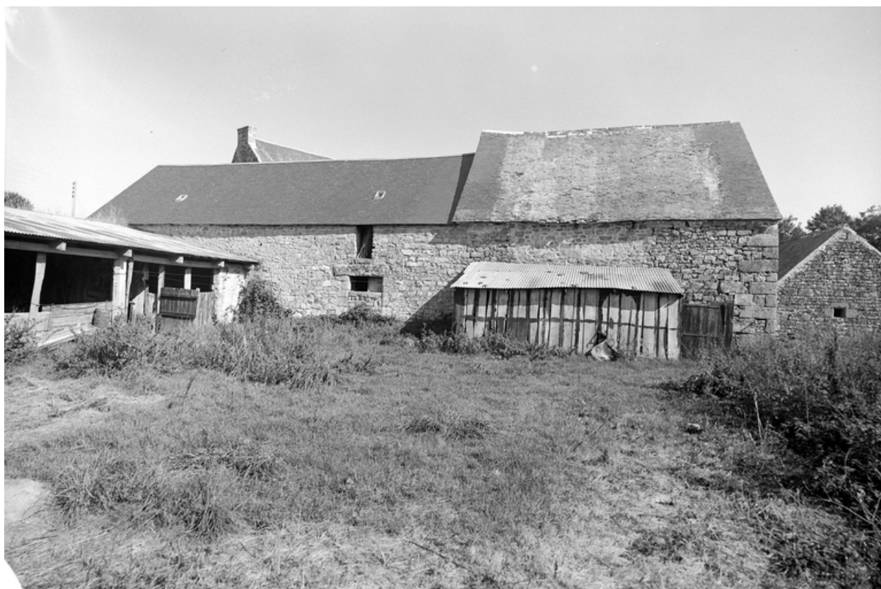
Vue générale des communs
