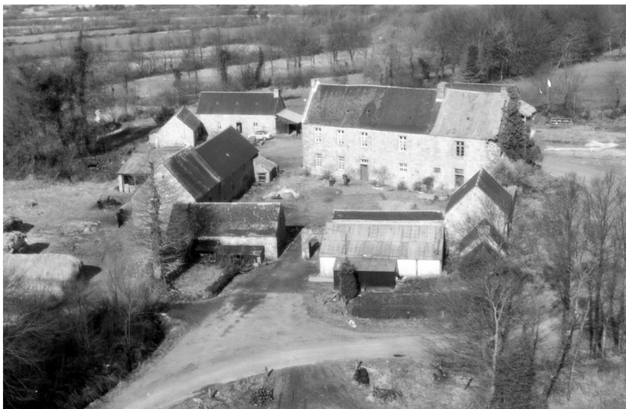
Vue aérienne prise du sud
