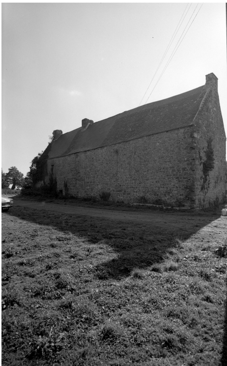
Vue générale de la face nord du logis
