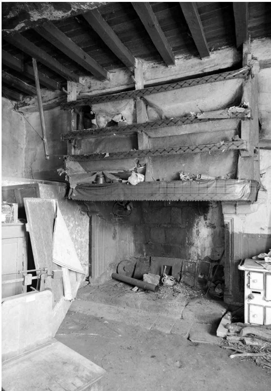
Cheminée au rez-de-chaussée pièce E de la partie occidentale du manoir
