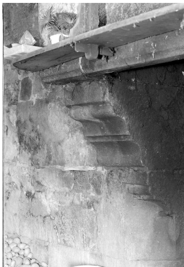
Cheminée à l'étage de la partie centrale : détail des moulures vu de côté
