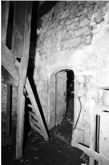
rez-de-chaussée : porte du mur nord Phot. François Dagorn IVR53_19682200349V
