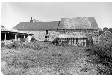
Vue générale des communs
