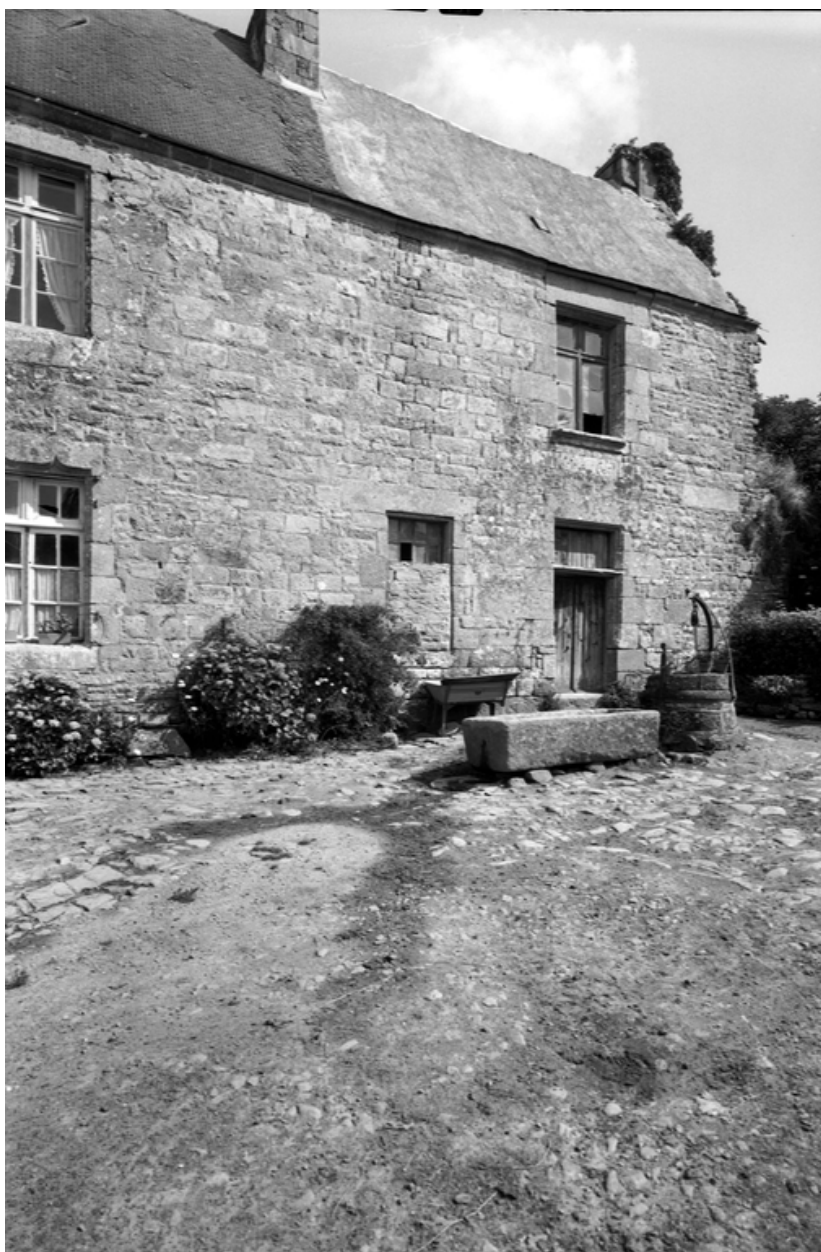
Façade sud du logis, détail partie est
