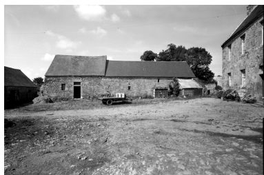
Bâtiment de communs Phot. François Dagorn IVR53_19682200343V
