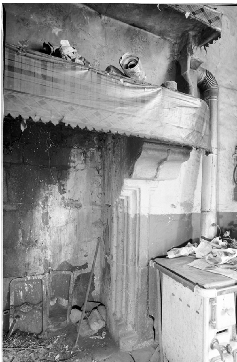
Cheminée au rez-de-chaussée pièce E de la partie occidentale du manoir : détail des moultures
