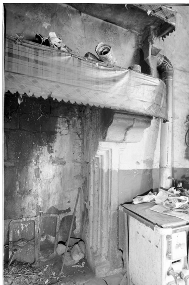
Cheminée au rez-de-chaussée pièce E de la partie occidentale du manoir : détail des moulures
