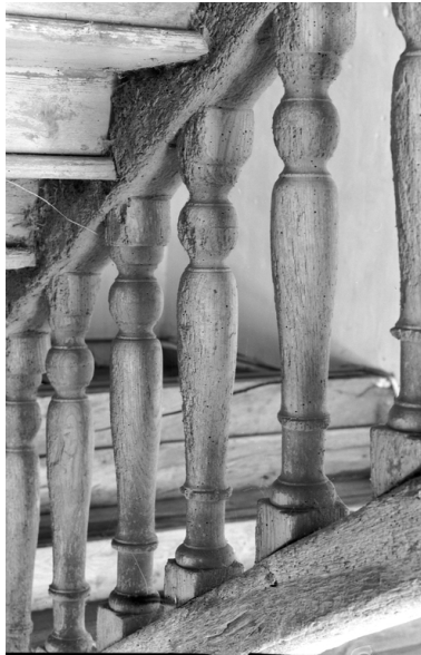
Escalier, détail : balustres Phot. François Dagorn IVR53_19682200347V
