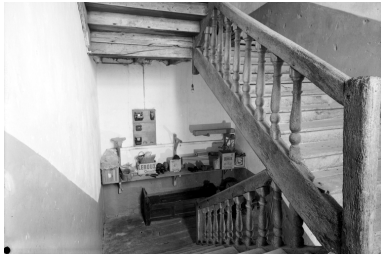
Escalier : vue générale Phot. François Dagorn IVR53_19682200346V
