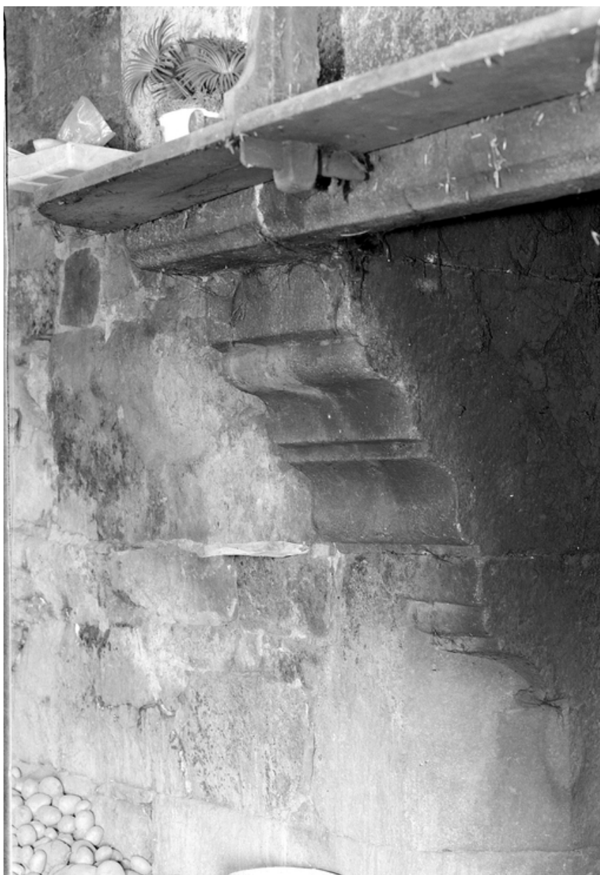
Cheminée à l'étage de la partie centrale : détail des moultures vu de côté
