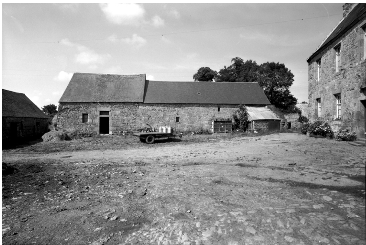
Bâtiment de communs
