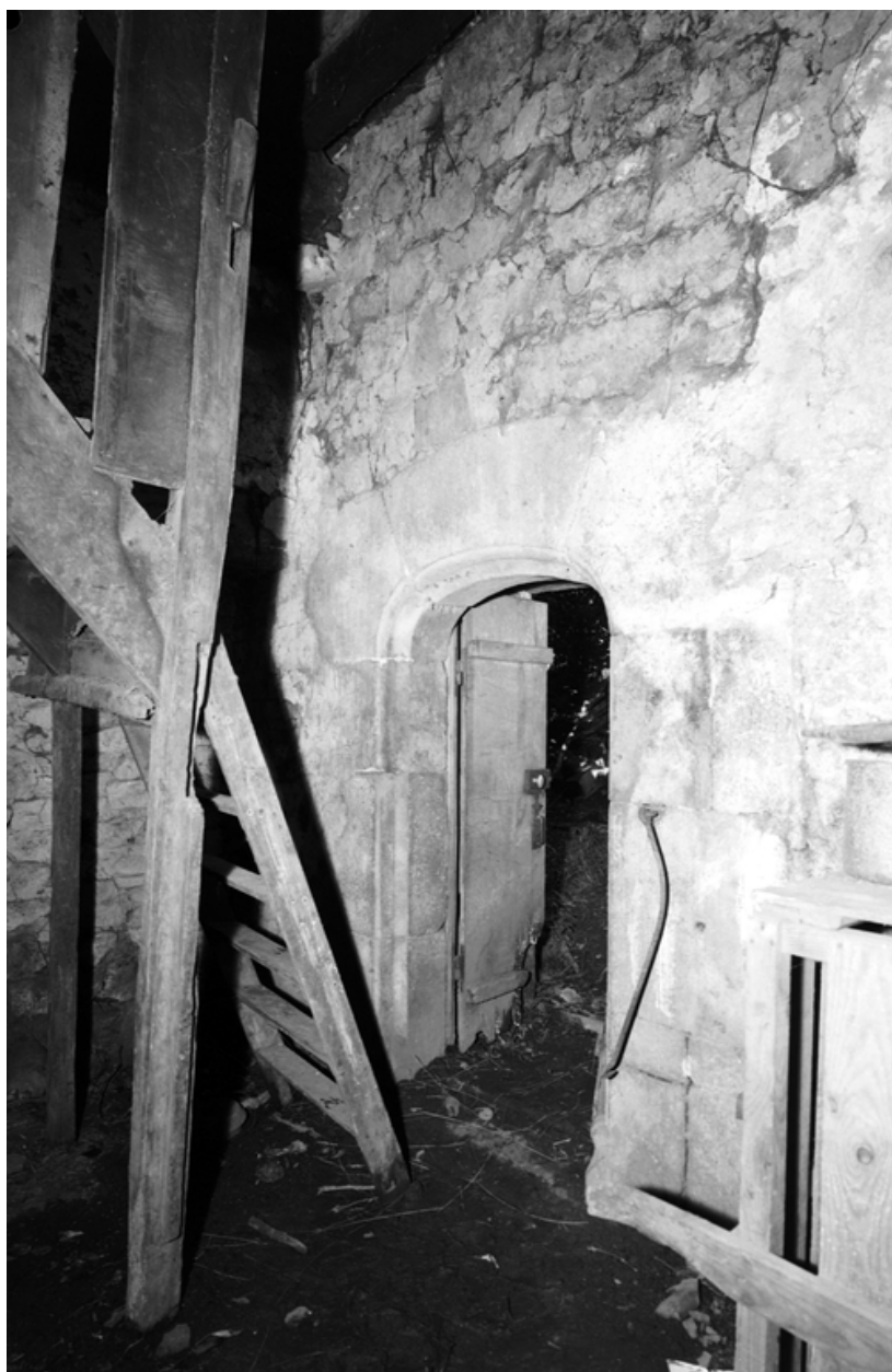
rez-de-chaussée : porte du mur nord
