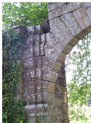
Le Portail : détail du montant nord Phot. Xavier Gilbert IVR53_19993505478NUCA
