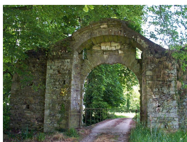
Le portail, revers : vue générale est Phot. Xavier Gilbert IVR53_19993505479NUCA
