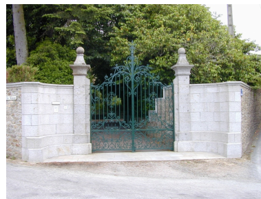
Le portail d'entrée : vue générale nord-est Phot. Xavier Gilbert IVR53_20003509586NUCA
