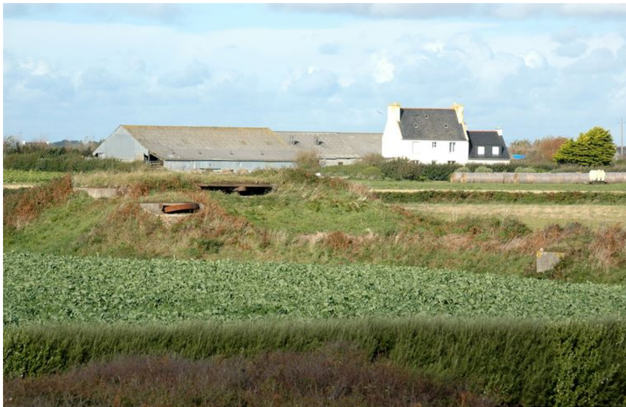
Vue générale du poste de direction de tir de français et petit observatoire de la section éclairante (état en 2004). En arrière-plan, la ferme de Kerveur
