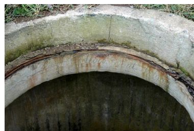
Vue de l'un des bunkers - postes d'observation et de tir dits "Tobruk-Stand" (état en 2004). Inscription gravée dans le béton : "De Kliegher. Alois. Gent. Belgique". En néerlandais, Gent est la ville de Gant en Belgique Phot. Guillaume Lécueillier IVR53_20042903884NUCA
