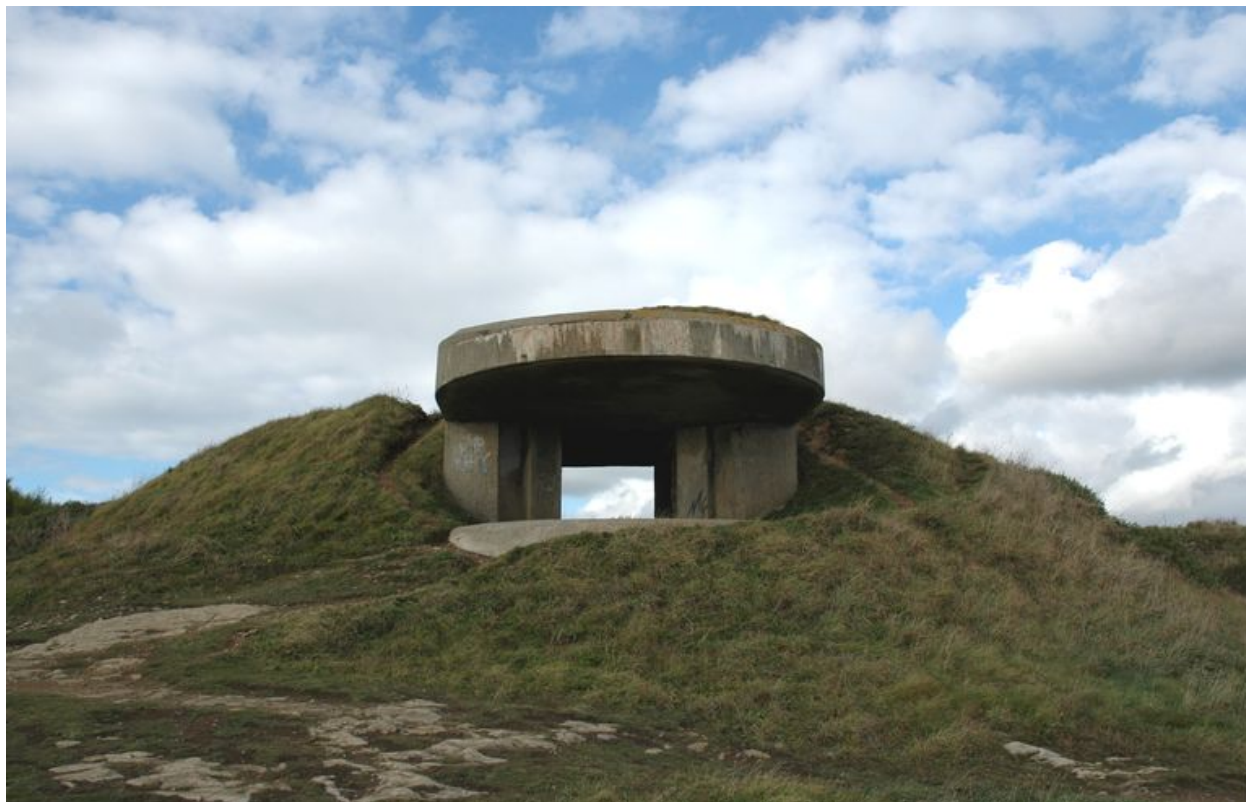
Vue du bunker de type M182 pour projecteur de 1,5 m de diamètre (état en 2004)
