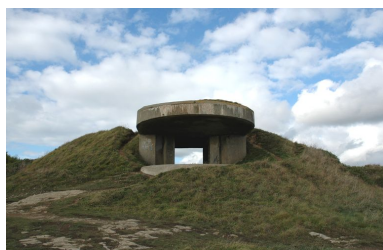
Vue du bunker de type M182 pour projecteur de 1,5 m de diamètre (état en 2004) Phot. Guillaume Lécueillier IVR53_20042903908NUCA
