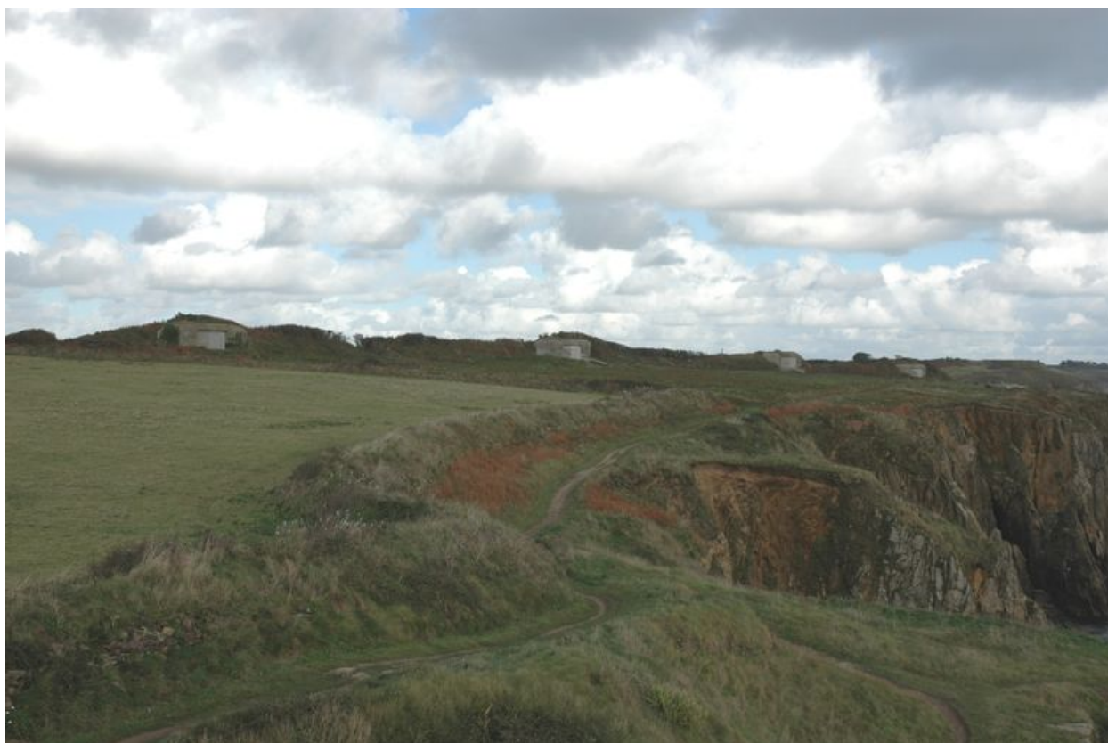
Vue générale de la batterie des Rospects - "Holtzendorff" depuis le bunker pour projecteur de 1,5 m de diamètre (état en 2004)
