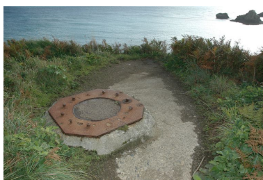
Vue d'une plateforme en béton armé (non identifiée) Phot. Guillaume Lécueillier IVR53_20042903917NUCA
