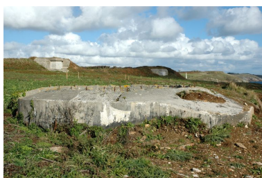
Vue du bunker de type 150 : cuve du télémètre (état en 2004). En arrière-plan : les casemates n° 3 et 4
