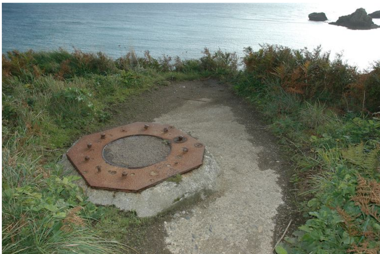
Vue d'une plateforme en béton armé (non identifiée)
