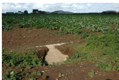
Vue de l'un des bunkers enterrés situés dans le champ (état en 2004) Phot. Guillaume Lécueillier IVR53_20042903872NUCA
