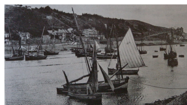
Bateau de pêche au Légué, 2ème quart 20ème siècle : remarquer le sloop aux laizes verticales, avec sa grande trinquette endraillée : la 'Mich' (carte postale, collection particulière) Repro. Guy Prigent IVR53_20082213147NUCB
