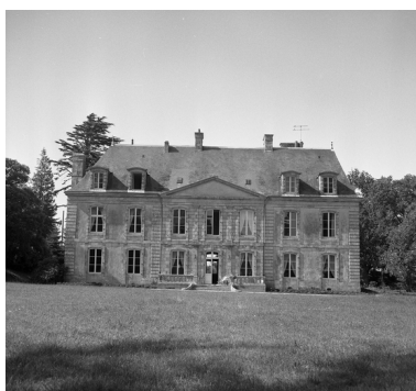
Elévation nord, vue générale. Etat en 1974. Phot. François Dagorn IVR53_19745600933X
