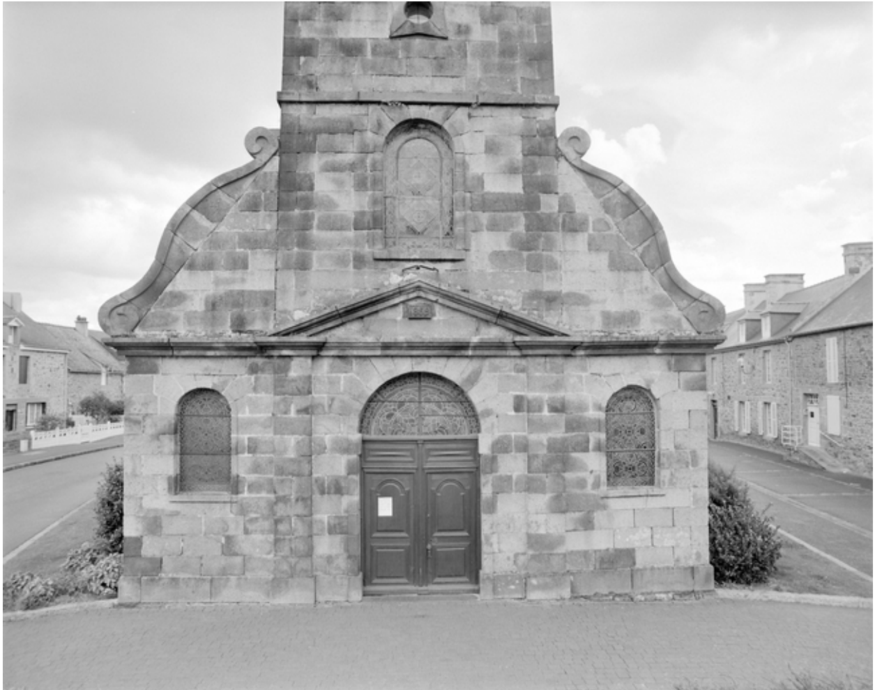
Détail : la façade ouest
