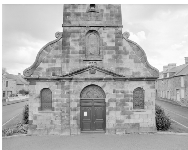
Détail : la façade ouest Phot. Guy Artur, Phot. Norbert Lambart IVR53_19943501834X
