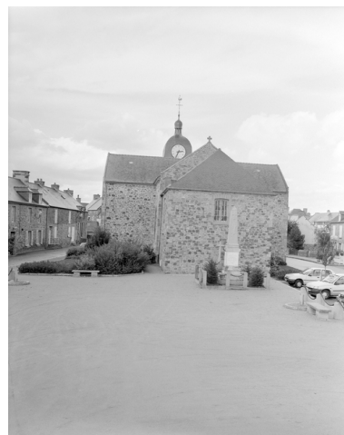
Vue générale est Phot. Guy Artur, Phot. Norbert Lambart IVR53_19943501831X
