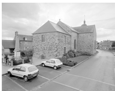
Vue générale nord-est Phot. Guy Artur, Phot. Norbert Lambart IVR53_19943501832X
