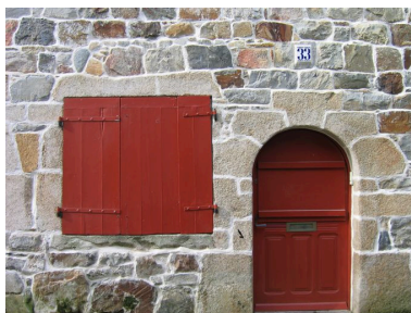
Elévation antérieure, détail du rez-de-chaussée Phot. Françoise Péron IVR53_20062908469NUCA
