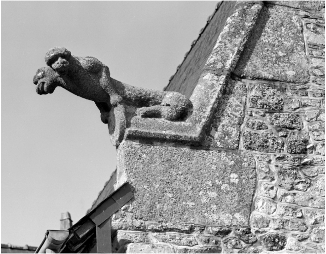
Pignon est, détail crossette, côté sud
