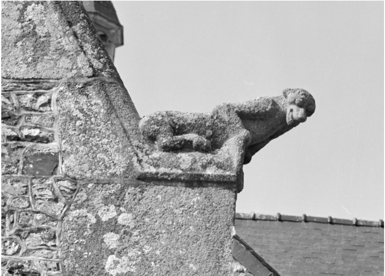
Pignon est, détail crossette, côté nord
