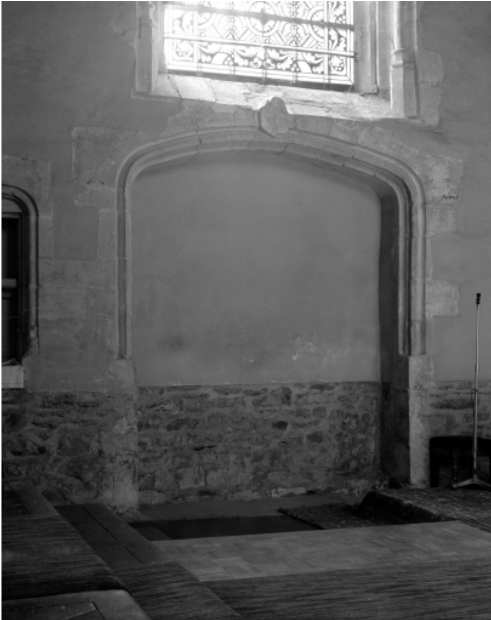
Choeur, mur nord, détail de l'enfeu.
