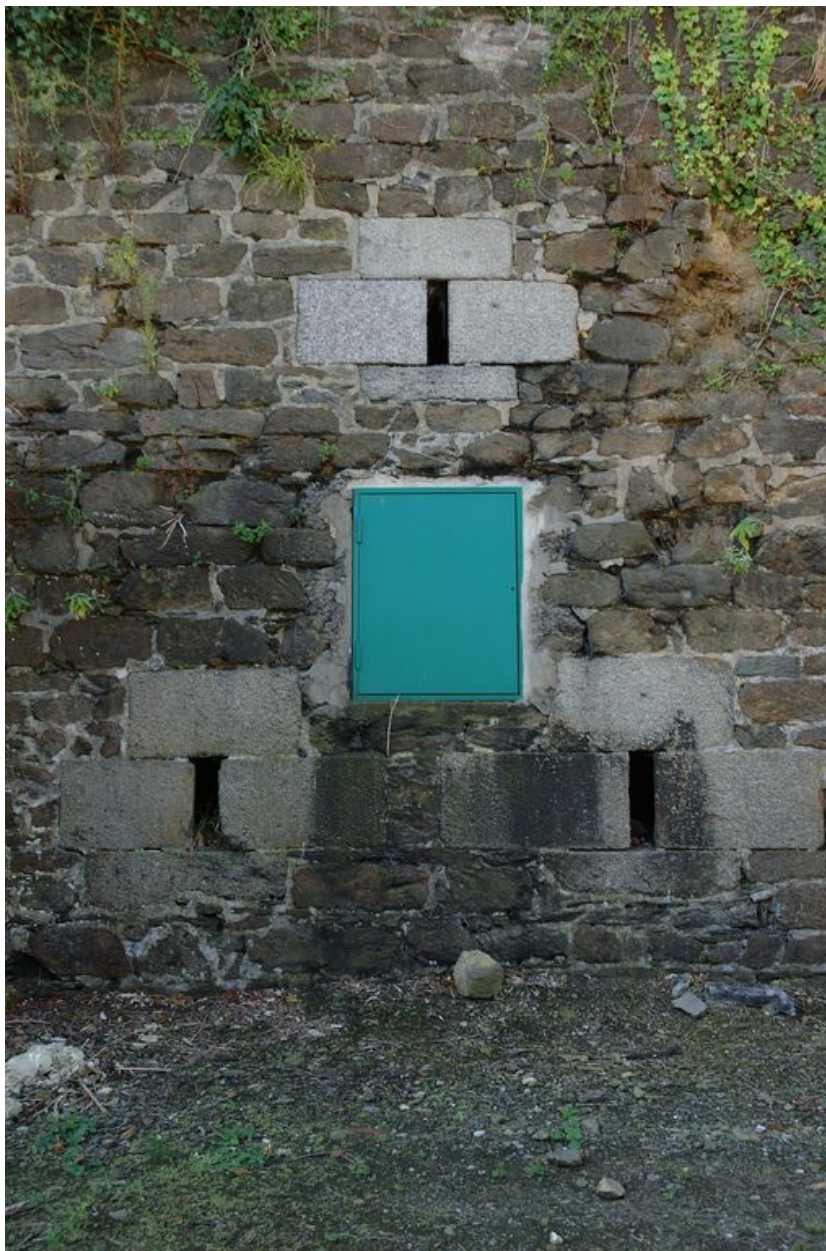
Vue de la branche est du fort du Portzic : créneaux de fusillade du casernement
