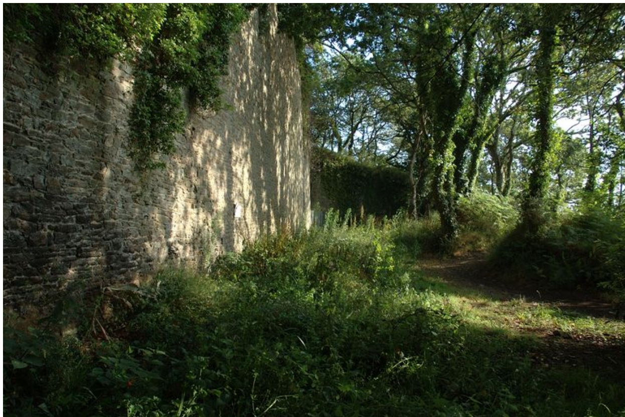
Vue de l'enceinte du fort de mer
