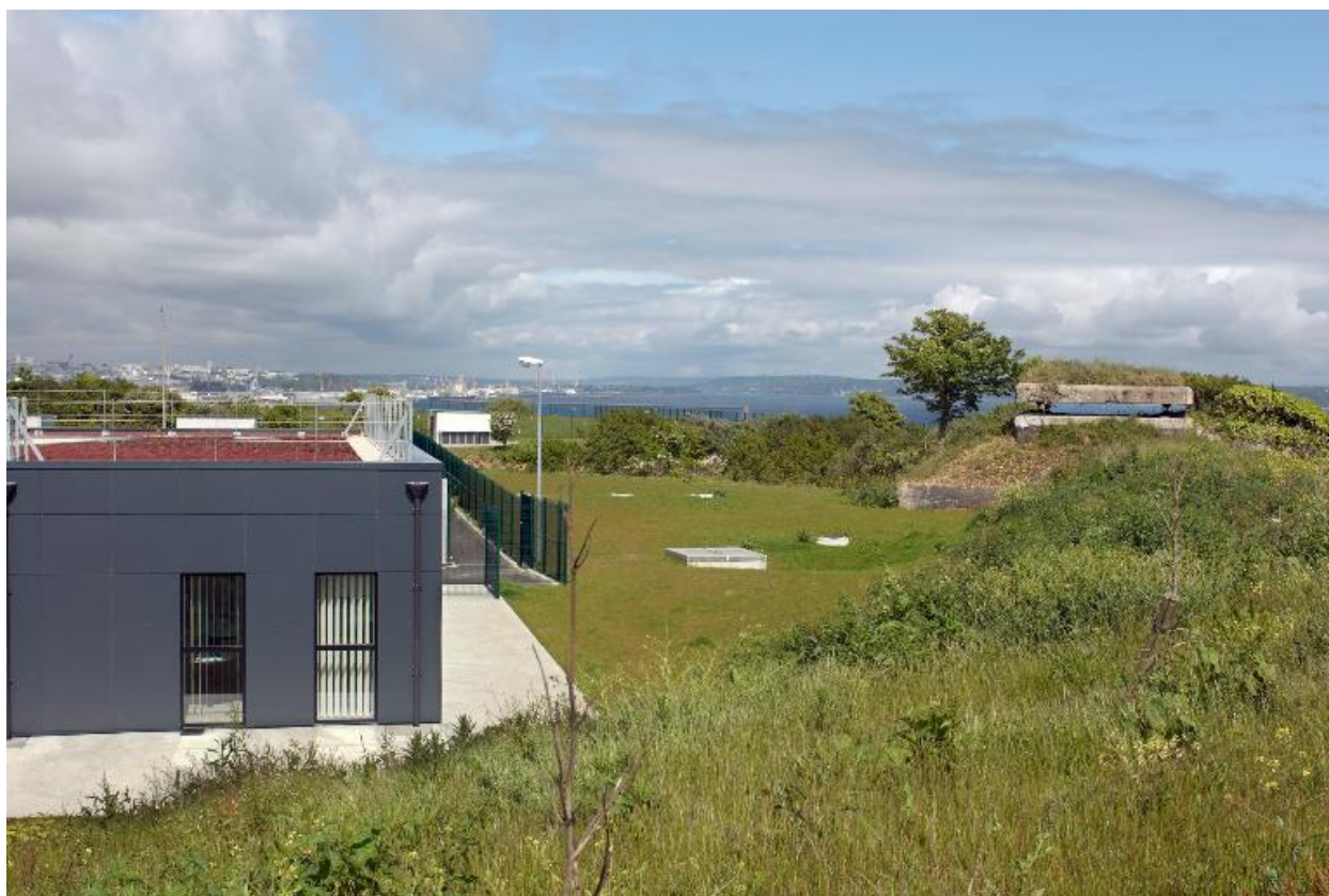
Vue de situation du bunker-poste de direction de tir de type M157 et du chenil du Portzic (dans l'emprise militaire). En arrière-plan : la ville de Brest
