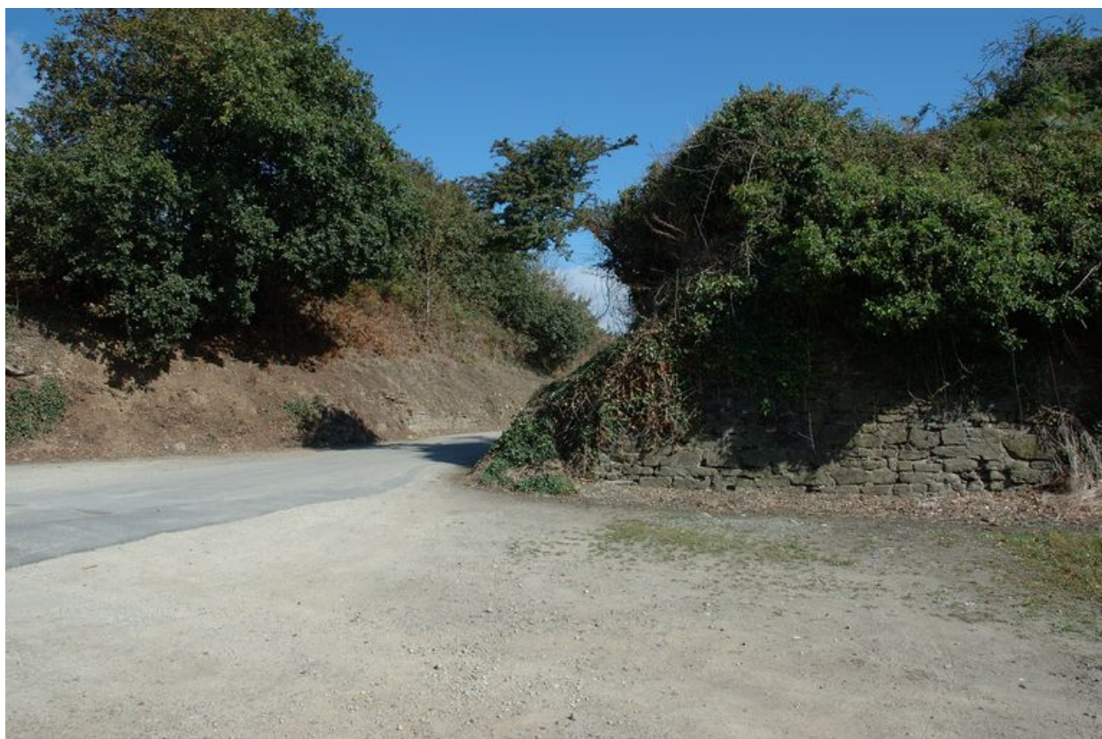
Vue des abords de l'entrée du fort : contrescarpe
