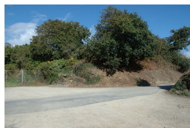
Vue des abords de l'entrée du fort du Portzic : contrescarpe Phot. Guillaume Lécueillier IVR53_20072907024NUCA
