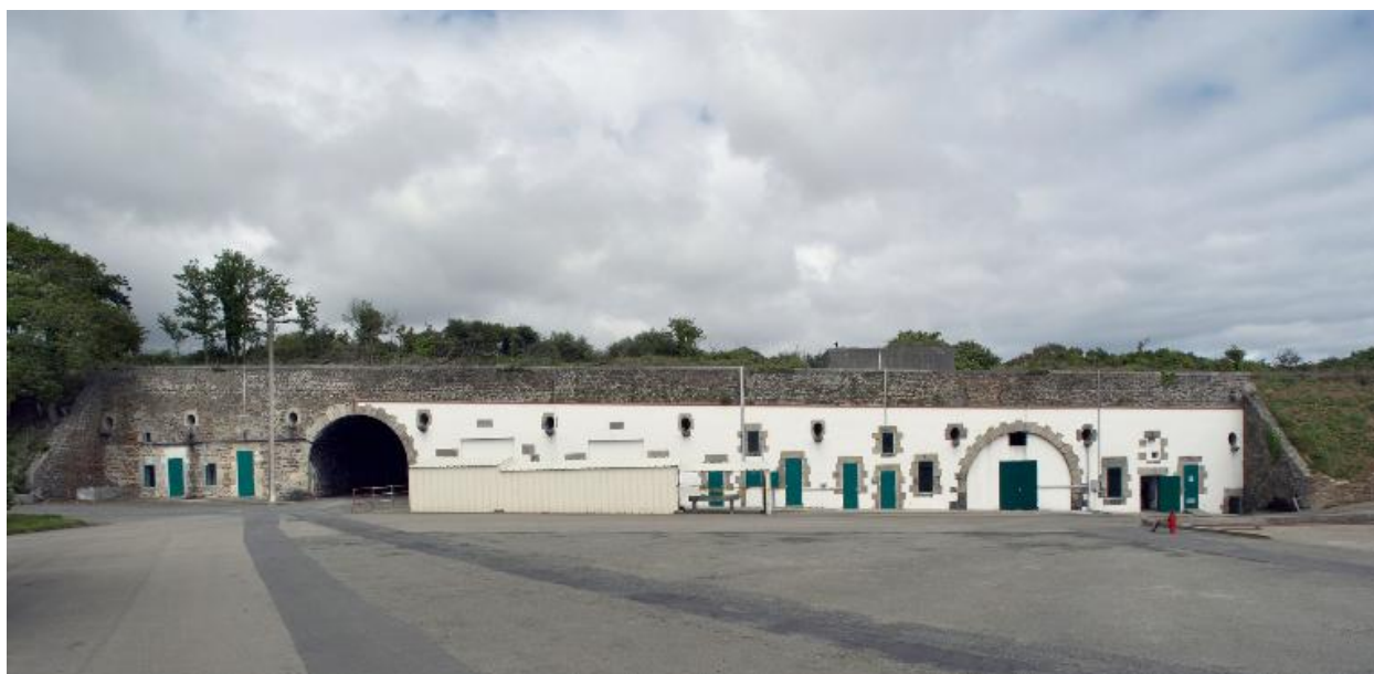
Vue générale du casernement du fort du Portzic avec passage d'entrée (dans l'emprise militaire)
