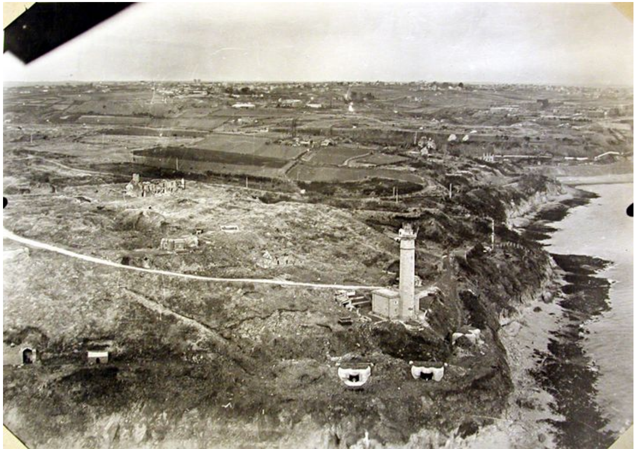
Vue aérienne oblique du fort du Portzic, photographie n° 106, rapport Pinczon du Sel. Livre IV, vers 1947, Service Historique de la Marine, Brest
