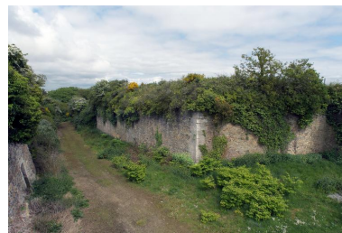
Vue du fort de mer : bastion nord et fossé sec (dans l'emprise militaire) Phot. Bernard Bègne IVR53_20122901186NUCA
