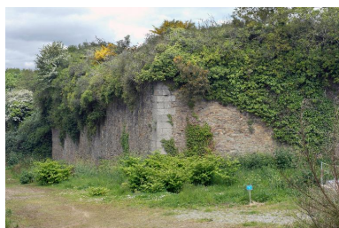
Vue du fort de mer : bastion nord et fossé sec (dans l'emprise militaire) Phot. Bernard Bègne IVR53_20122901185NUCA
