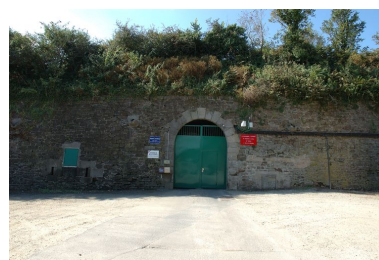
Vue de l'entrée du fort du Portzic Phot. Guillaume Lécueillier IVR53_20072907020NUCA
