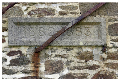
Vue d'une traverse d'une batterie d'artillerie de côte française : millésime 1882-1883 (dans l'emprise militaire) Phot. Bernard Bègne IVR53_20122901189NUCA
