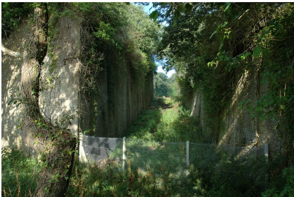
Vue de l'enceinte du fort de mer : fossé sec
