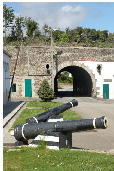
Vue du casernement du fort du Portzic avec passage d'entrée (dans l'emprise militaire). Au premier plan : deux pièces d'artillerie Phot. Bernard Bègne
