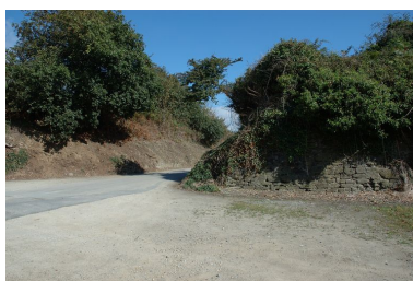
Vue des abords de l'entrée du fort : contrescarpe Phot. Guillaume Lécueillier IVR53_20072907023NUCA
