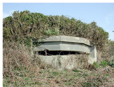
Vue d'un poste d'observation en béton armé. Il est situé à proximité de la batterie de 32 cm Phot. Guillaume Lécueillier IVR53_20072906065NUCA
