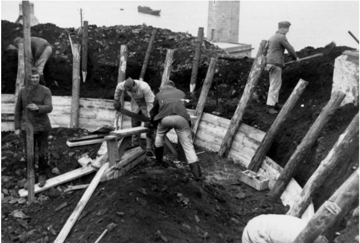
Vue du fort du Portzic pendant la Seconde Guerre mondiale : travaux de coffrage du soubassement de l'une des casemates. A l'arrière-plan : le phare du Portzic
