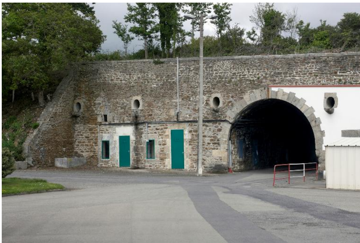
Vue du casernement du fort du Portzic avec passage d'entrée (dans l'emprise militaire)
