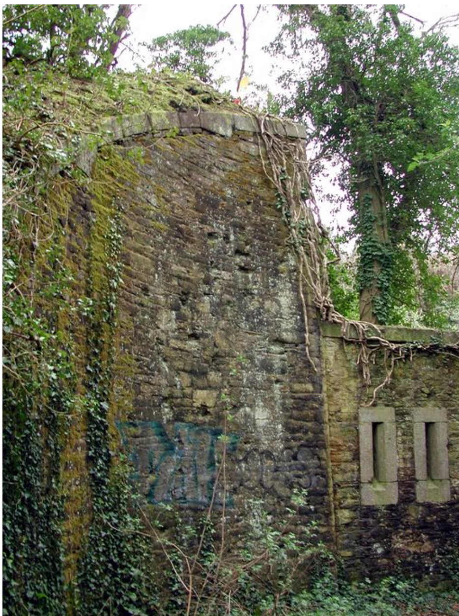
Vue de l'enceinte du fort de mer. Elle est percée de créneaux de fusillade
