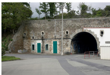
Vue du casernement du fort du Portzic avec passage d'entrée (dans l'emprise militaire) Phot. Bernard Bègne IVR53_20122901183NUCA
