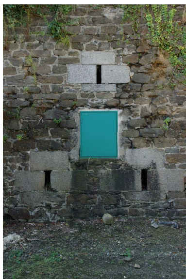
Vue de la branche est du fort du Portzic : créneaux de fusillade du casernement Phot. Guillaume Lécueillier IVR53_20072907022NUCA
