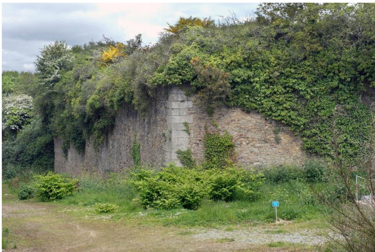
Vue du fort de mer : bastion nord et fossé sec (dans l'emprise militaire)
