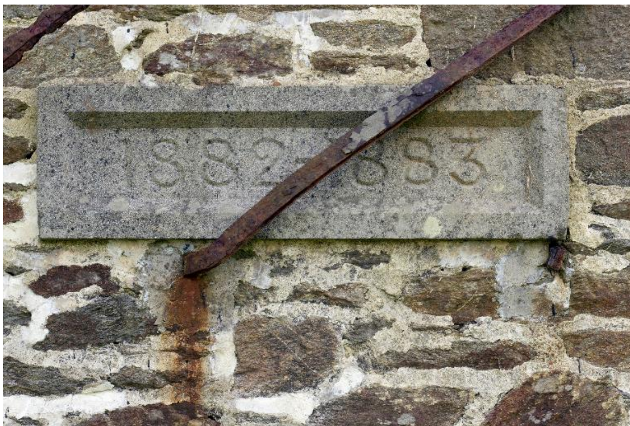
Vue d'une traverse d'une batterie d'artillerie de côte française : millésime 1882-1883 (dans l'emprise militaire)
