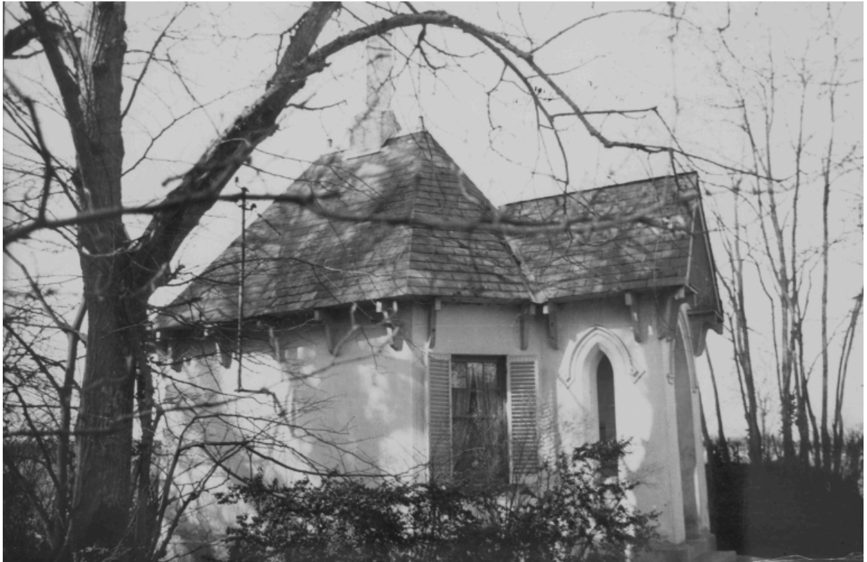
La porterie, état avant transformation
