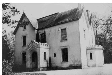
Etat avant transformation Phot. Auteur inconnu IVR53_20033510699NUC
