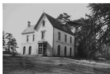
Etat avant transformation (état en 1973) Phot. Auteur inconnu IVR53_20033510652NUC
