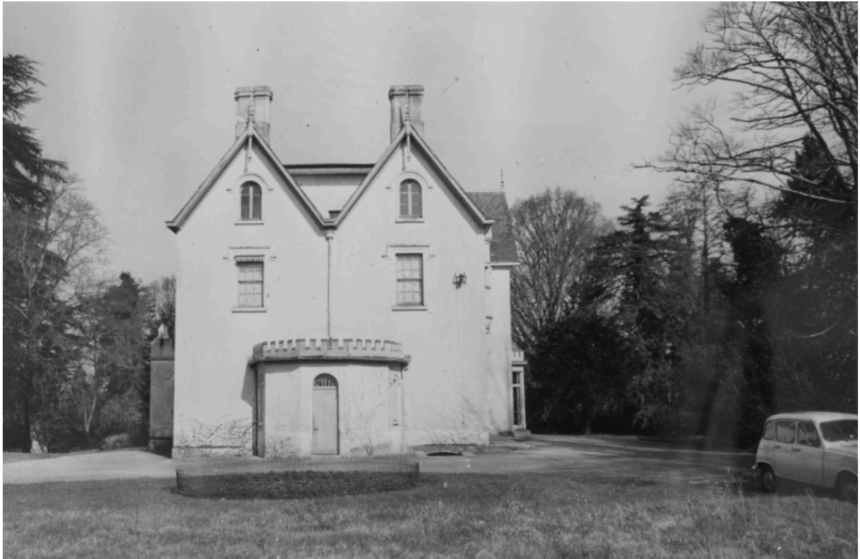
Etat avant transformation
