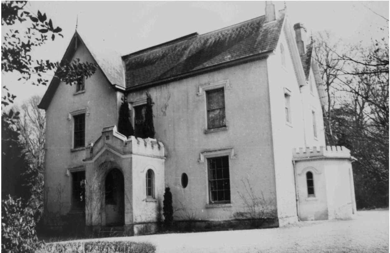
Etat avant transformation
