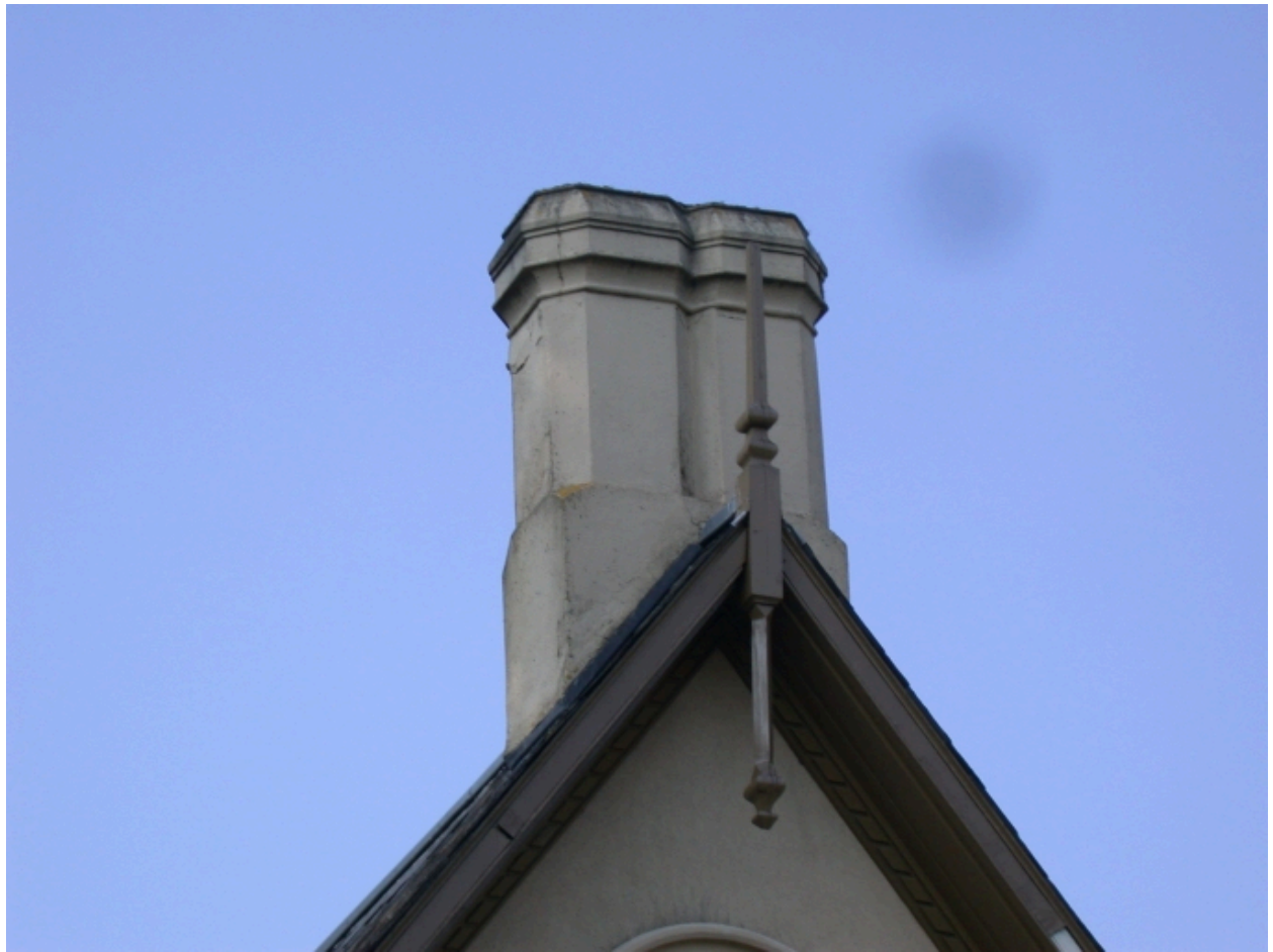
Détail des souches de cheminée
