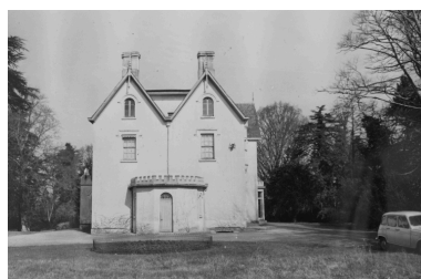
Etat avant transformation Phot. Auteur inconnu IVR53_20033510702NUC
