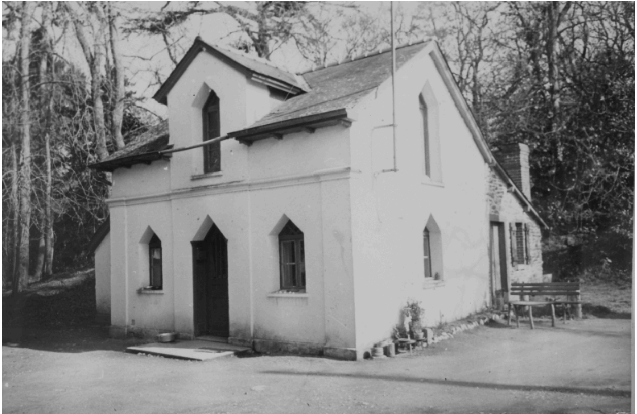
Communs : état avant transformation
