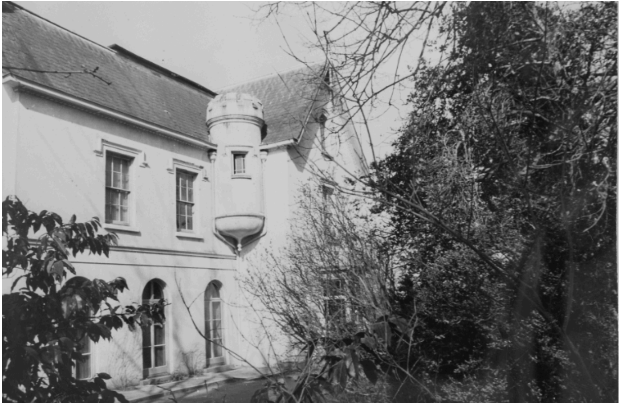
Etat avant transformation
