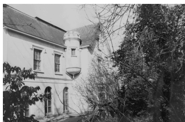
Etat avant transformation Phot. Auteur inconnu IVR53_20033510701NUC
