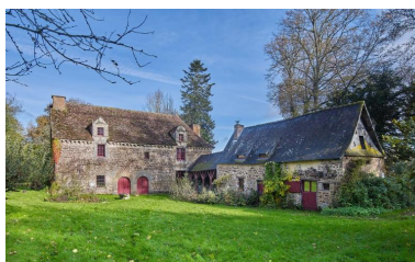
Vue générale sud-ouest Phot. Bernard Bègne IVR53_20243501379NUCA
