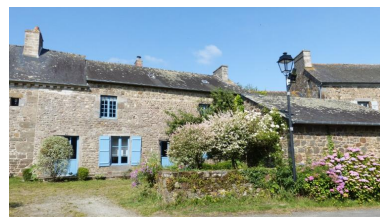
Vue générale est Phot. Laurence Marquet IVR53_20243531196NUCA
