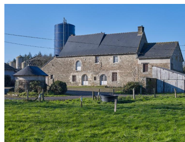
Vue générale sud-est Phot. Bernard Bègne IVR53_20253500100NUCA
