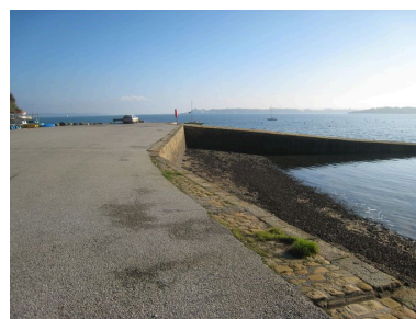
Cale du bourg de Roscanvel Phot. Françoise Péron IVR53_20072908923NUCA
