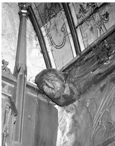
Intérieur, sablières : détail d'un blochet. Phot. L. Lamandé IVR53_19853501085X
