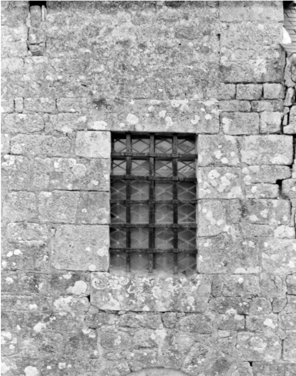
Elévation sud, tour ouest : détail de la fenêtre.
