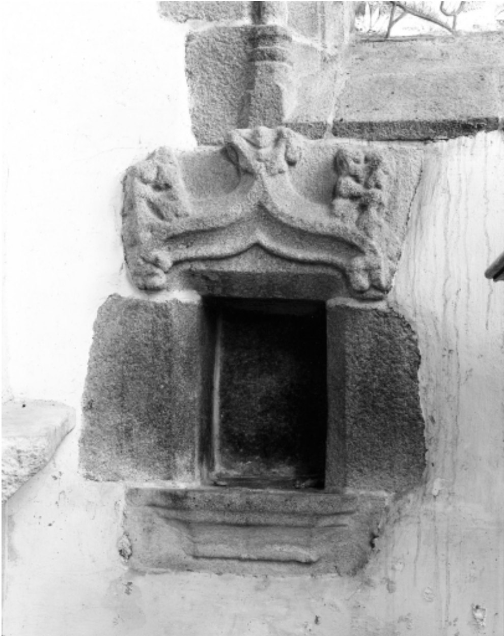
Intérieur, niche : vue générale.
