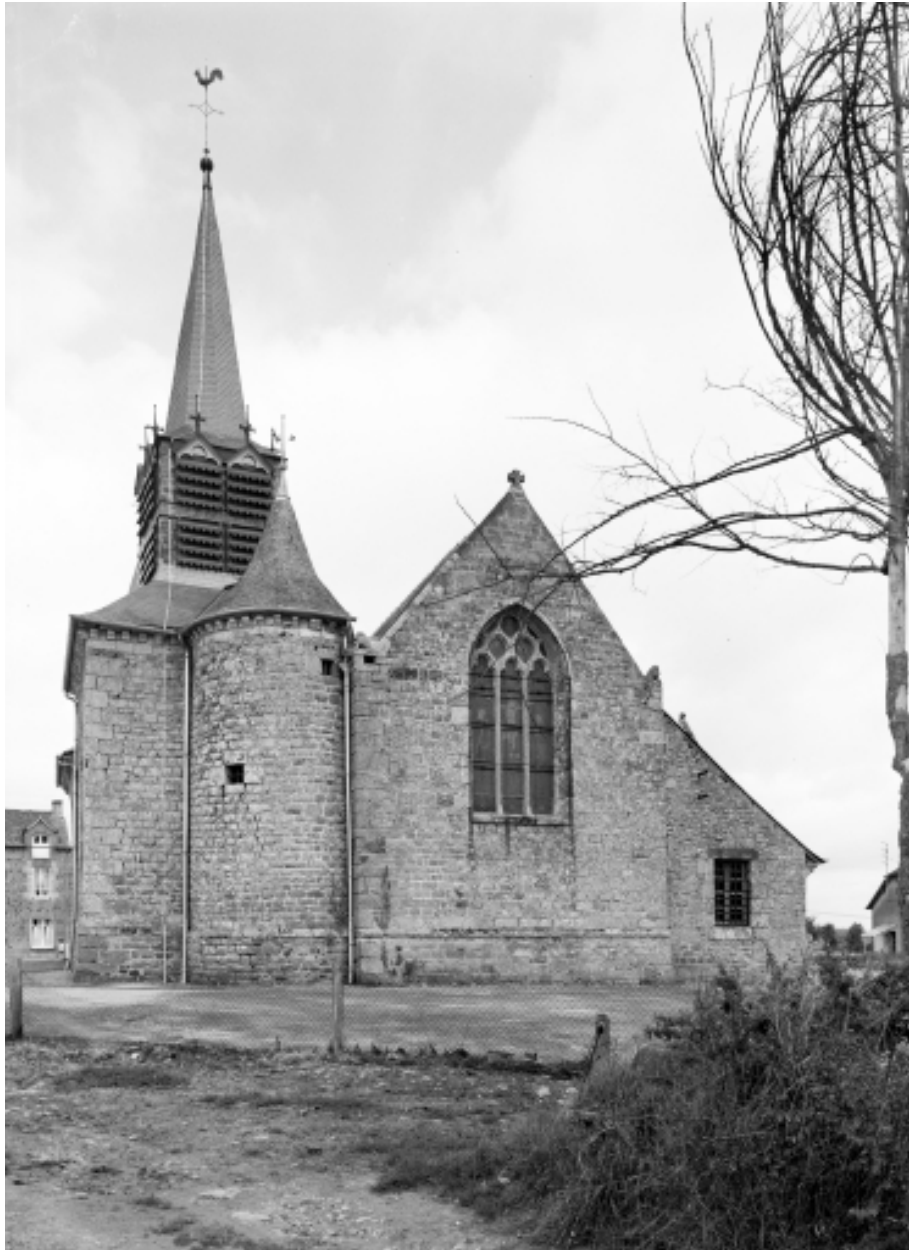
Elévation est : vue générale
