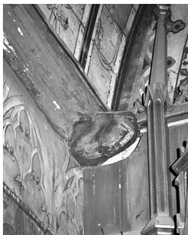
Intérieur, sablières : vue de détail d'un blochet. Phot. L. Lamandé IVR53_19853501083X
