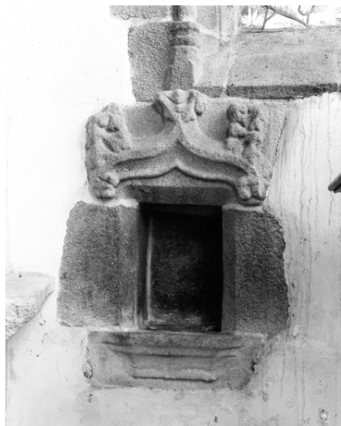
Intérieur, niche : vue générale.
