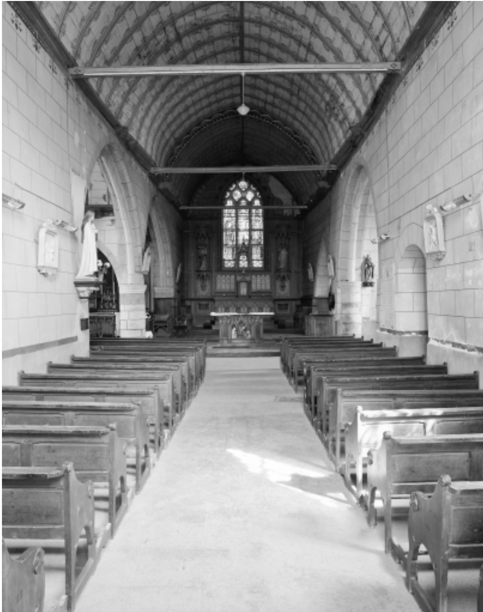
Intérieur : vue générale vers le chœur.
