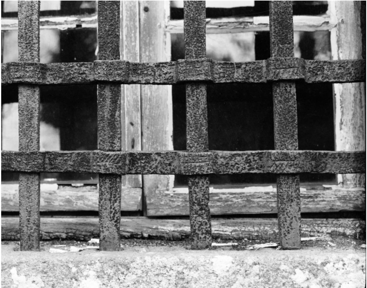
Elévation nord, fenêtre : détail de la grille
