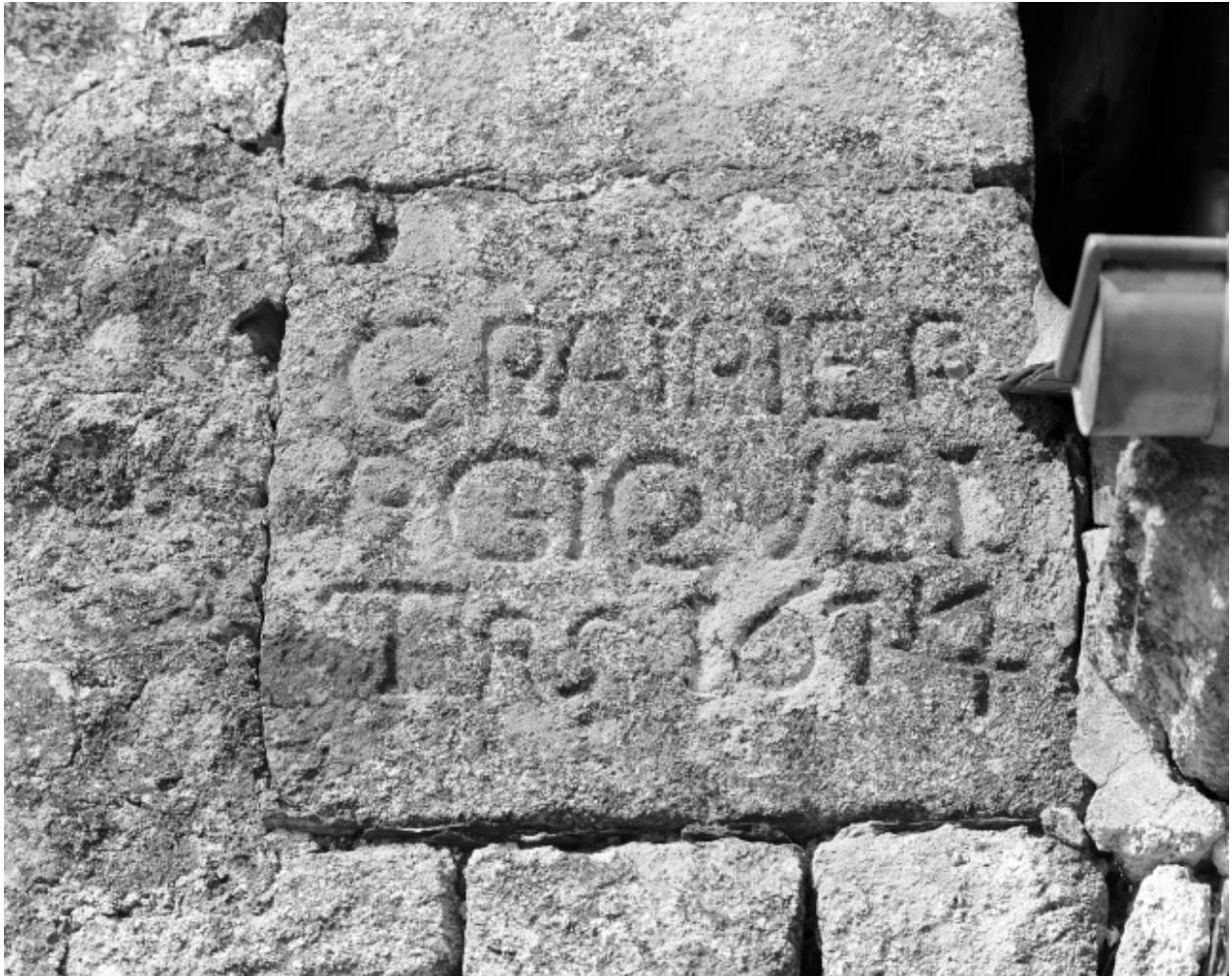
Elévation sud, tour ouest : détail de l'inscription
