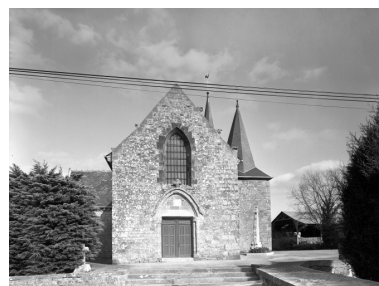
Elévation ouest : vue générale Phot. L. Lamandé IVR53_19853501272V
