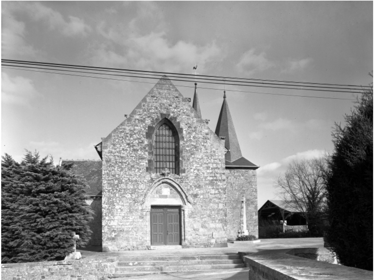
Elévation ouest : vue générale
