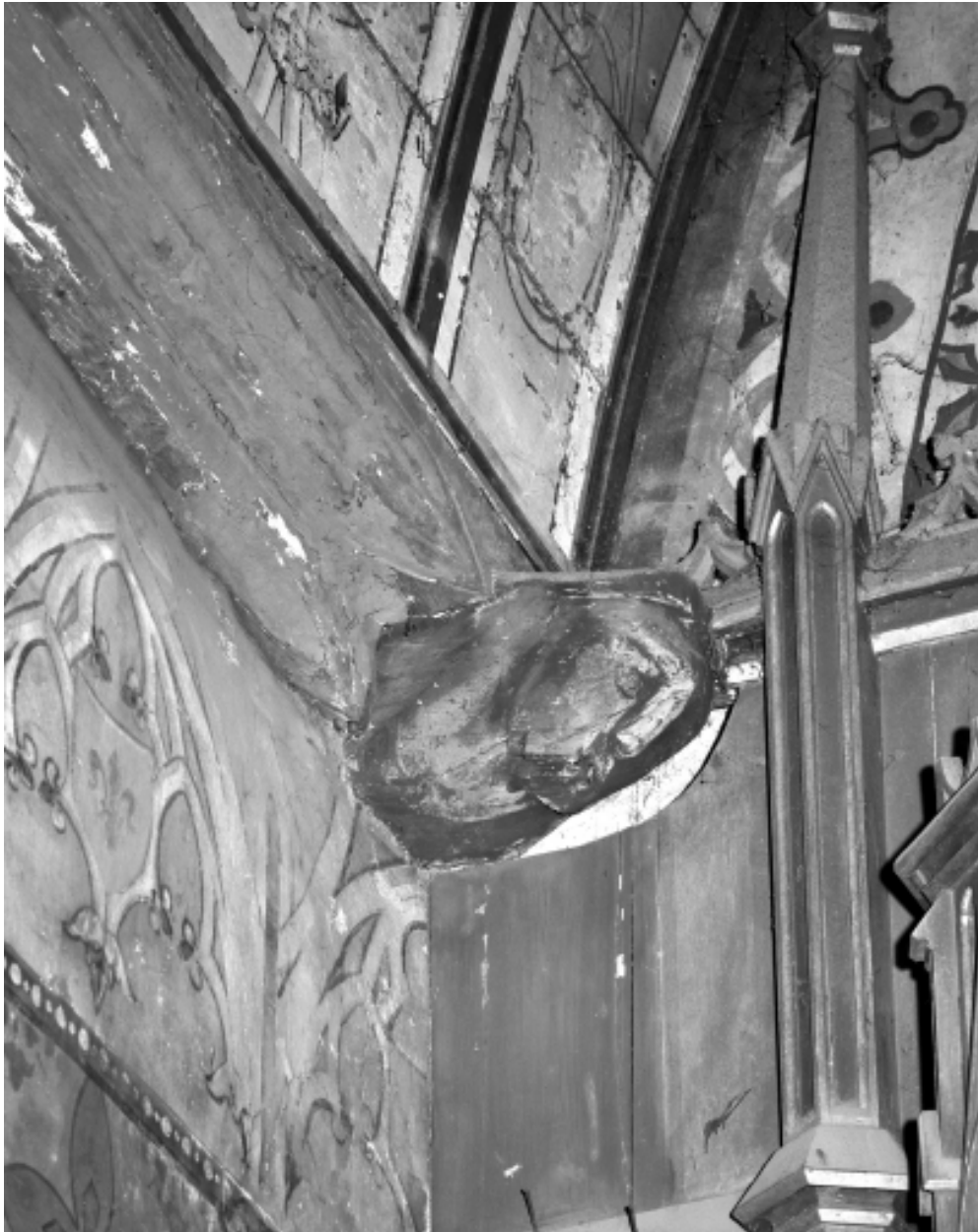
Intérieur, sablières : vue de détail d'un blochet.
