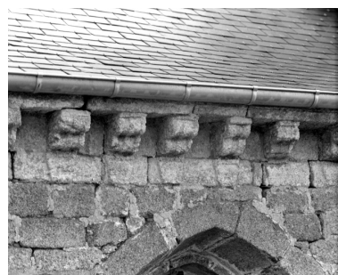
Elévation ouest, corniche : détail des modillons Phot. L. Lamandé IVR53_19853501062X
