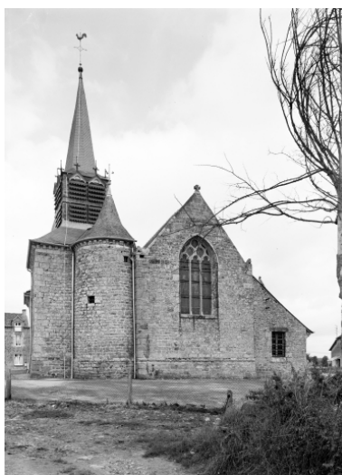
Elévation est : vue générale Phot. L. Lamandé IVR53_19853501273V
