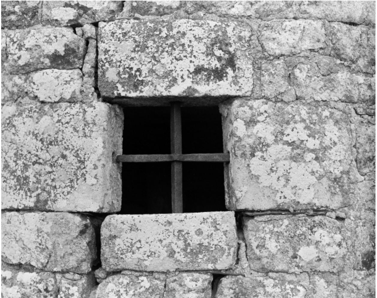
Elévation sud, tour est : détail de la fenêtre
