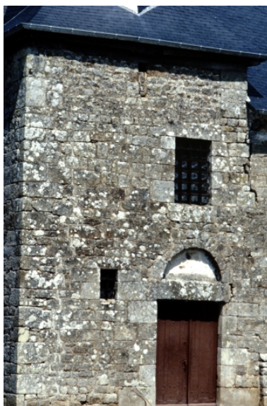
Façade sud, détail de la tour. Phot. L. Lamandé, Repro. Norbert Lambart IVR53_19853500858ZA
