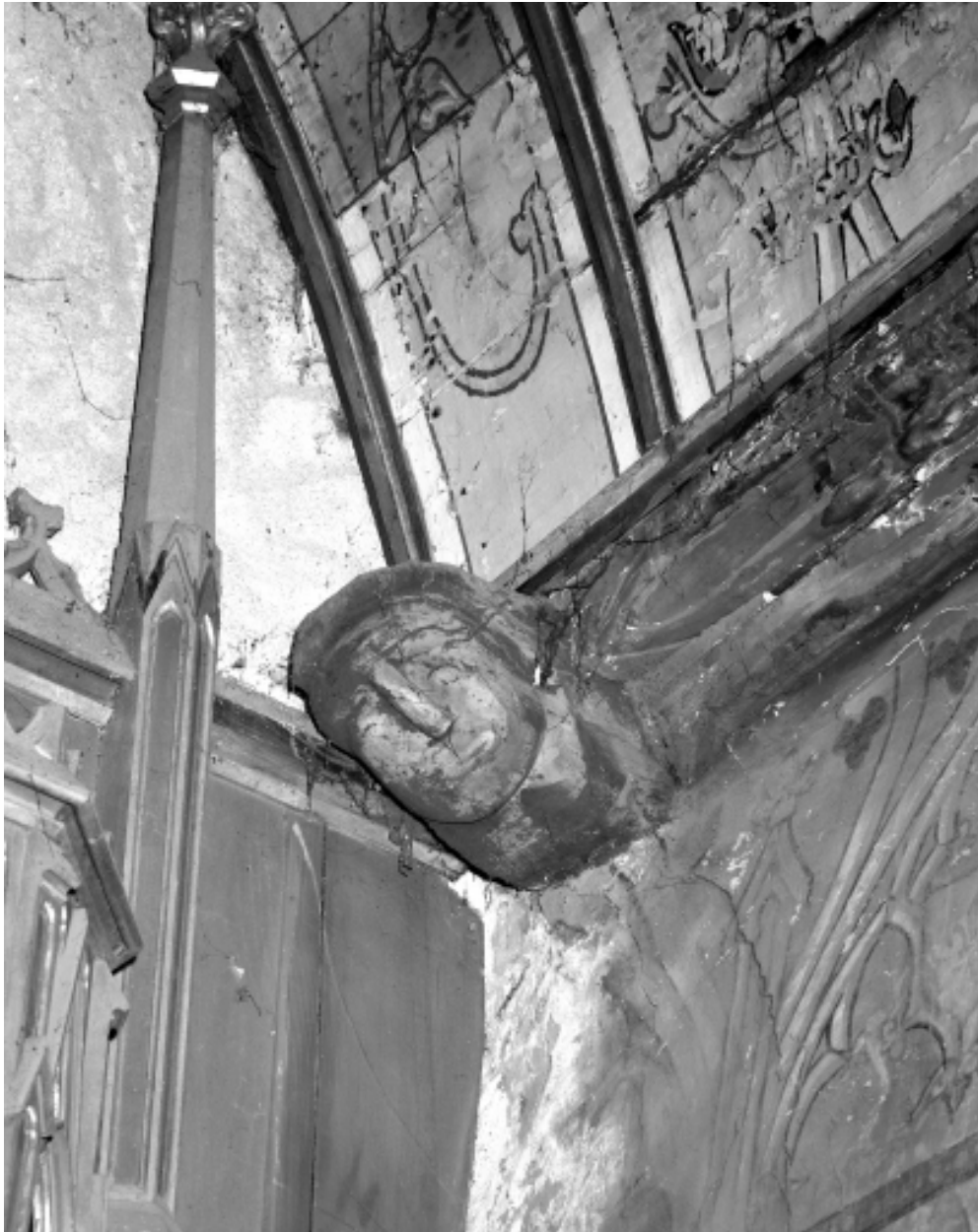
Intérieur, sablières : détail d'un blochet.
