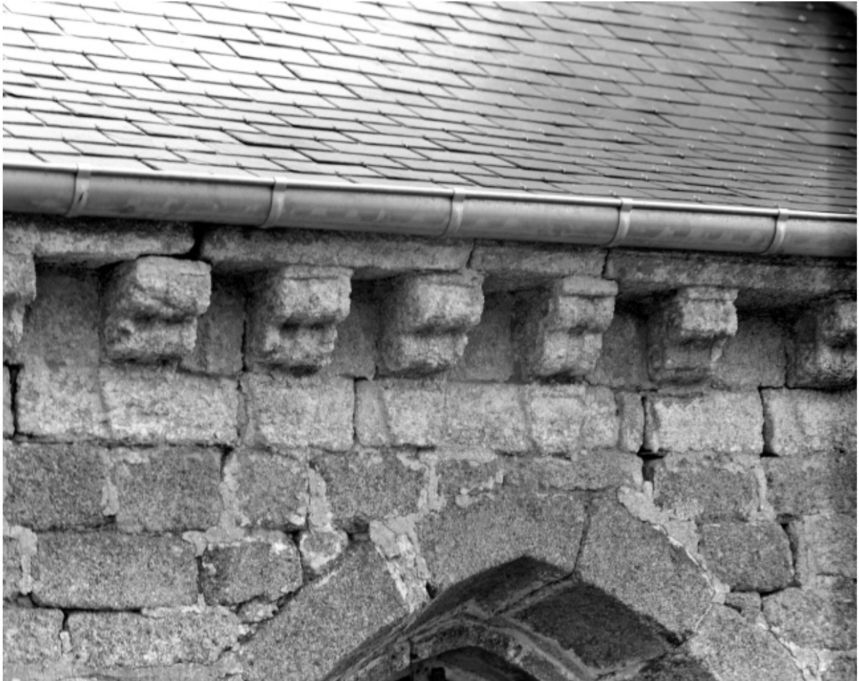
Elévation ouest, corniche : détail des modillons
