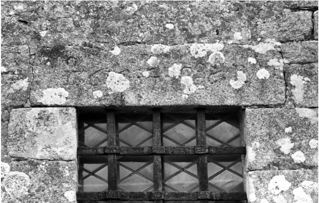
Elévation sud, tour ouest, fenêtre : détail du linteau
