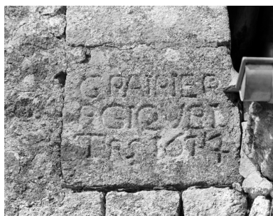
Elévation sud, tour ouest : détail de l'inscription Phot. L. Lamandé IVR53_19853501092X
