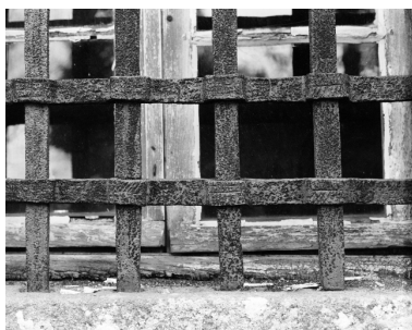
Elévation nord, fenêtre : détail de la grille Phot. L. Lamandé IVR53_19853501067X
