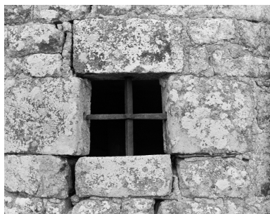
Elévation sud, tour est : détail de la fenêtre Phot. L. Lamandé IVR53_19853501069X
