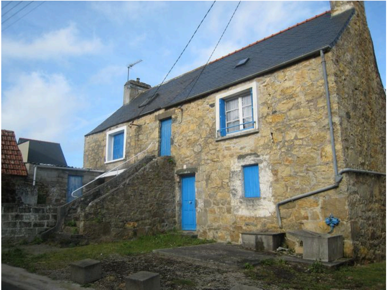
Vue de trois quarts Bras maison
