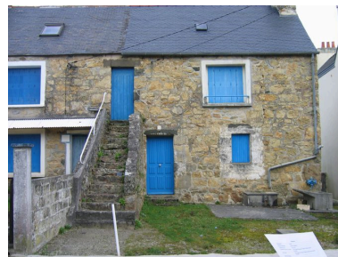
partie gauche Bras Maison Phot. Françoise Péron IVR53_20062908650NUCA
