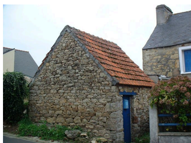
Remise Bras maison Phot. Julien Amghar IVR53_20062908649NUCA
