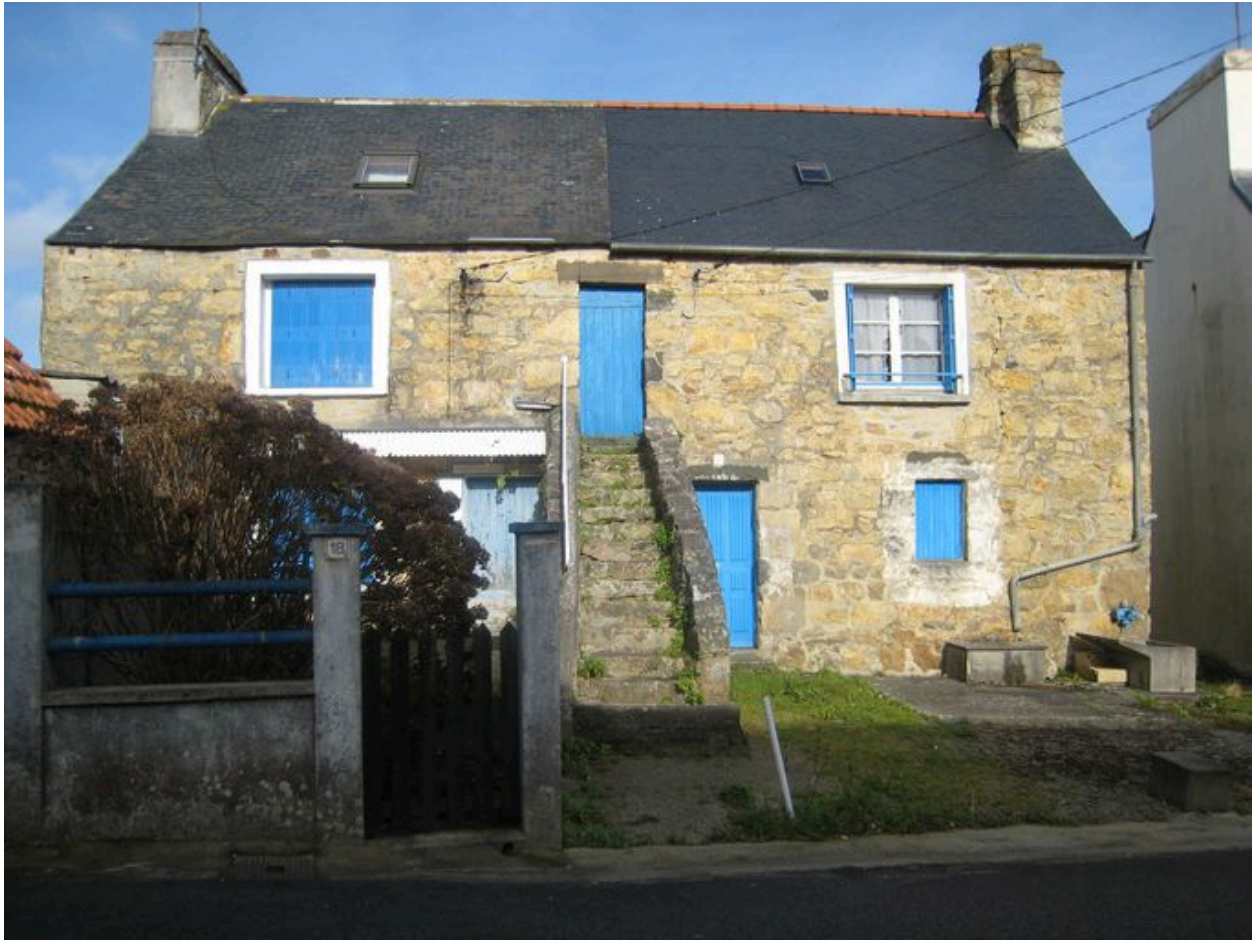
Vue générale Bras maison
