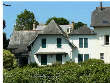
Vue générale villa Kador, côté mer Phot. Johan Vincent IVR53_20072908718NUCA
