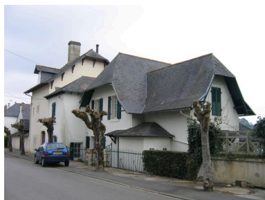
Vue arrière de la villa Kador, côté terre Phot. Françoise Péron IVR53_20062908636NUCA
