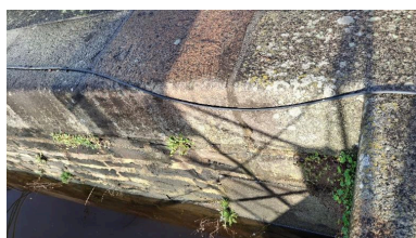
Maçonnerie des quais Phot. Erwana L'Haridon IVR53_20262210299NUCA
