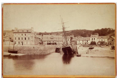
Cale et aire de carénage du port du Légué vers 1895 Phot. Auteur inconnu IVR53_20262210071NUCA
