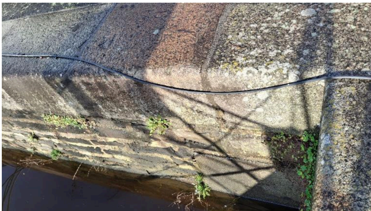
Maçonnerie des quais
