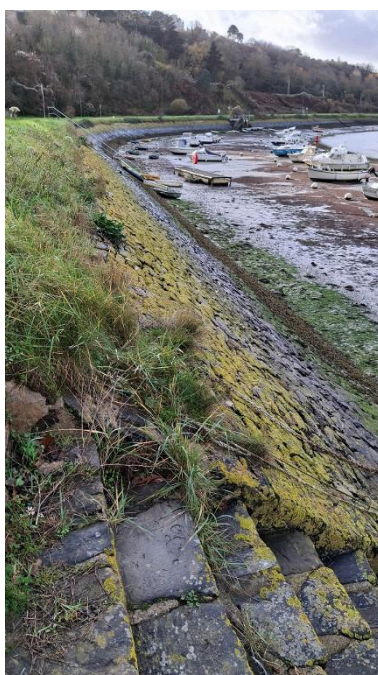
Perrés de la rive droite, avant-port
