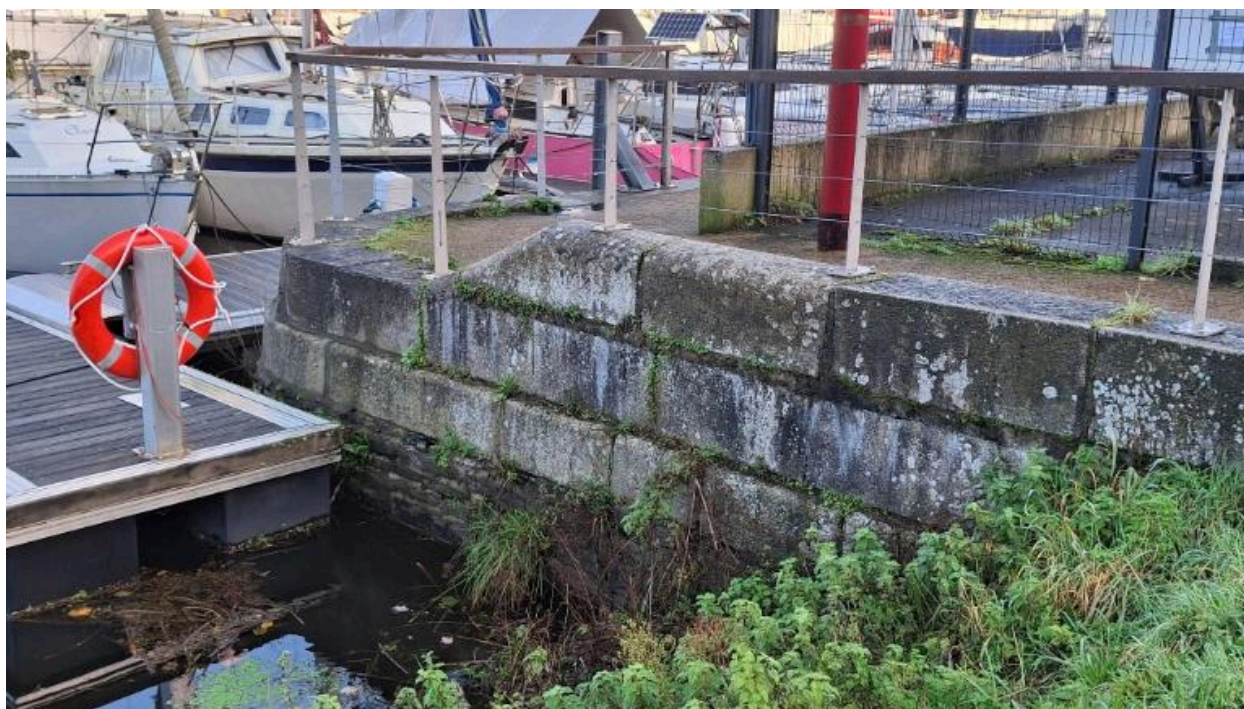
Détails de maçonnerie de l'ancienne aire d'évitage
