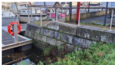
Détails de maçonnerie de l'ancienne aire d'évitage Phot. Erwana L'Haridon IVR53_20252210712NUCA
