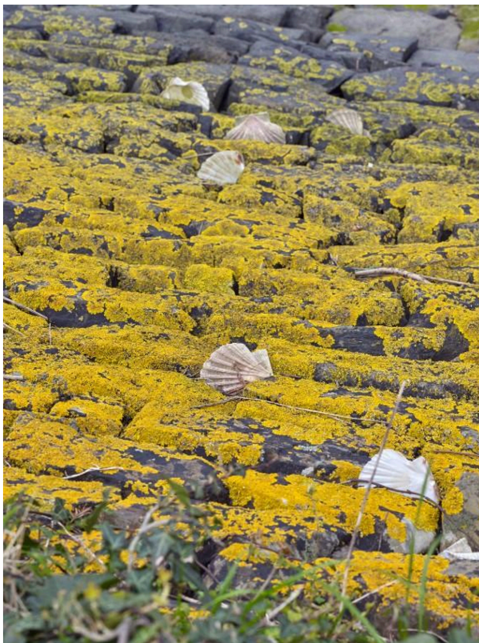
Avant-port, perrés du Quai Surcouf
