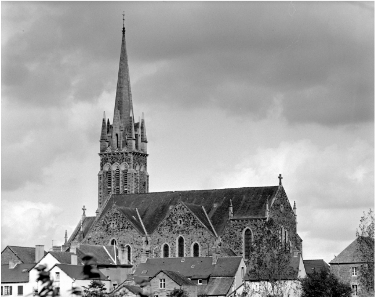
Elévation Sud : vue générale
