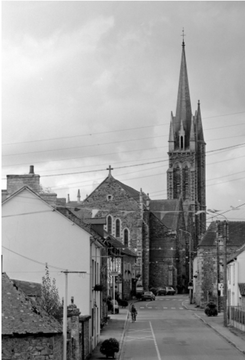
Elévation Nord-Est : vue générale
