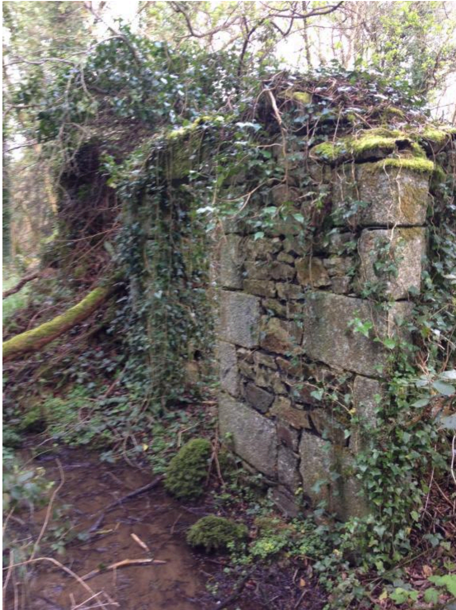
Anciens écurie et logement du moulin à eau de Saint-Efflam
