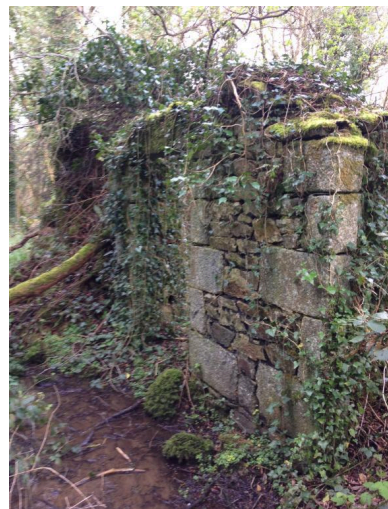
Anciens écurie et logement du moulin à eau de Saint-Efflam Phot. Fadila Hamelin IVR53_20212265869NUCA
