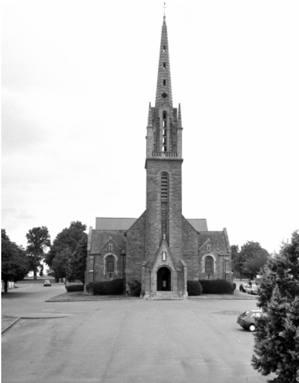
Elévation sud : vue générale
