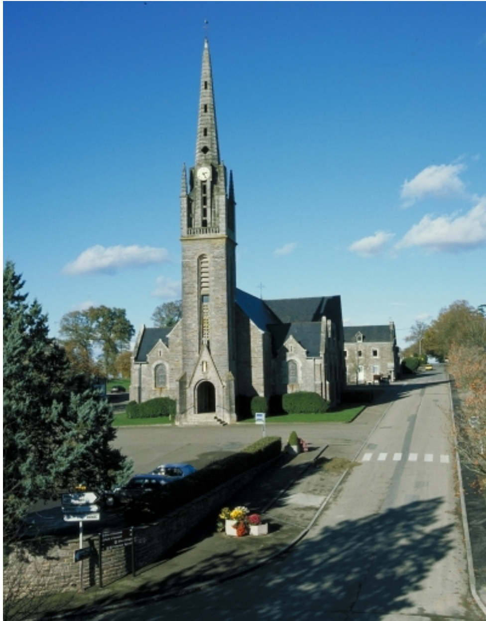
Vue de situation : façade sud
