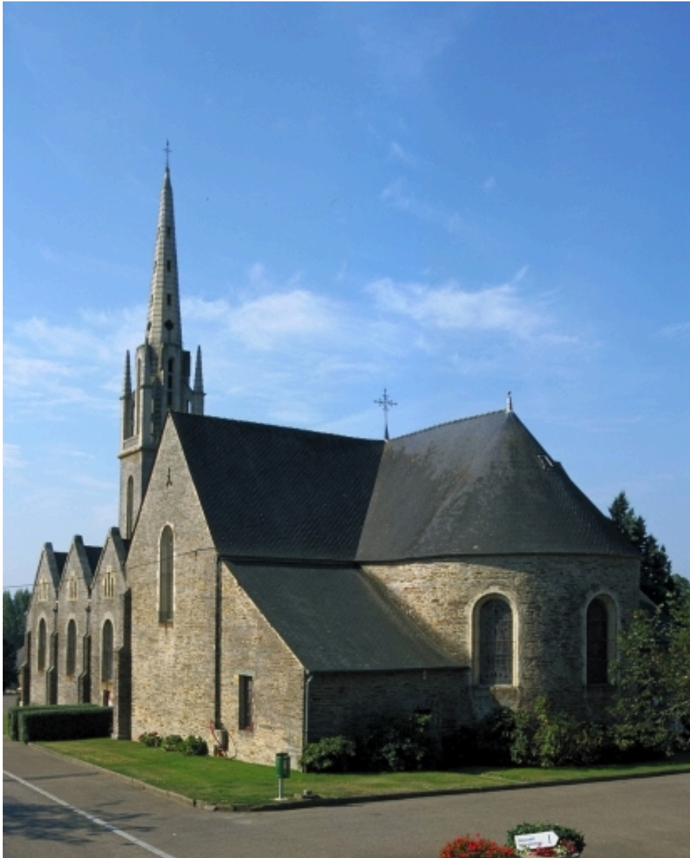
Elévation nord : vue générale
