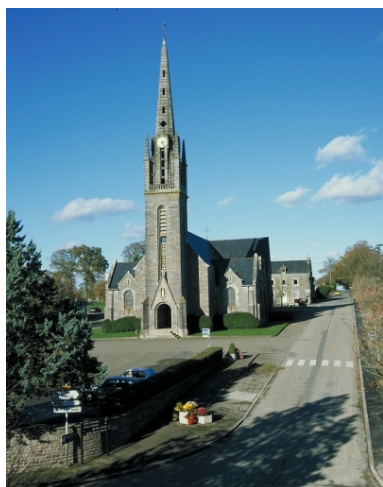
Vue de situation : façade sud Phot. Guy Artur, Phot. Norbert Lambart IVR53_20003502854XA
