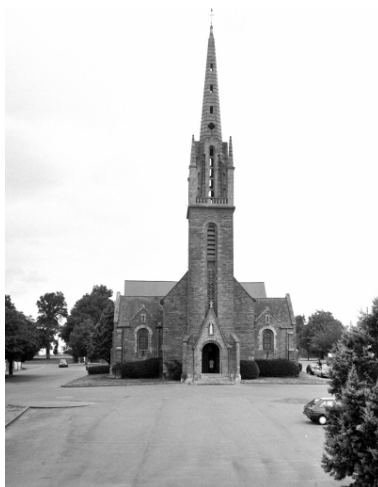
Elévation sud : vue générale Phot. Guy Artur, Phot. Norbert Lambart IVR53_19943501750X
