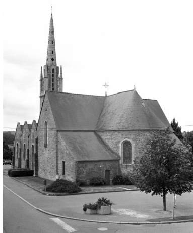
Elévation nord : vue générale Phot. Guy Artur, Phot. Norbert Lambart IVR53_19943501748X
