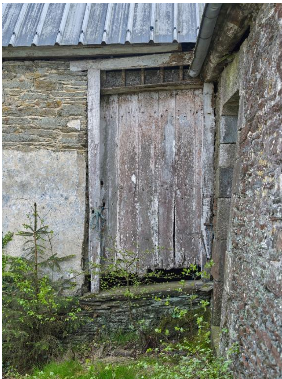
Partie fermée de la sècherie. Porte d'accès
