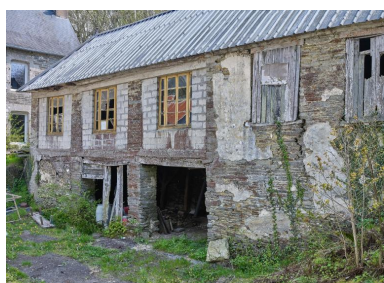
Dépendance fermant la cour à l'est : remise à piliers maçonnés, surmontée d'une sècherie dont les baies libres (partiellement bouchées par des parpaings) étaient fermées par des claires-voies en bois. Elévation ouest. Phot. Bernard Bègne IVR53_20232200193NUCA
