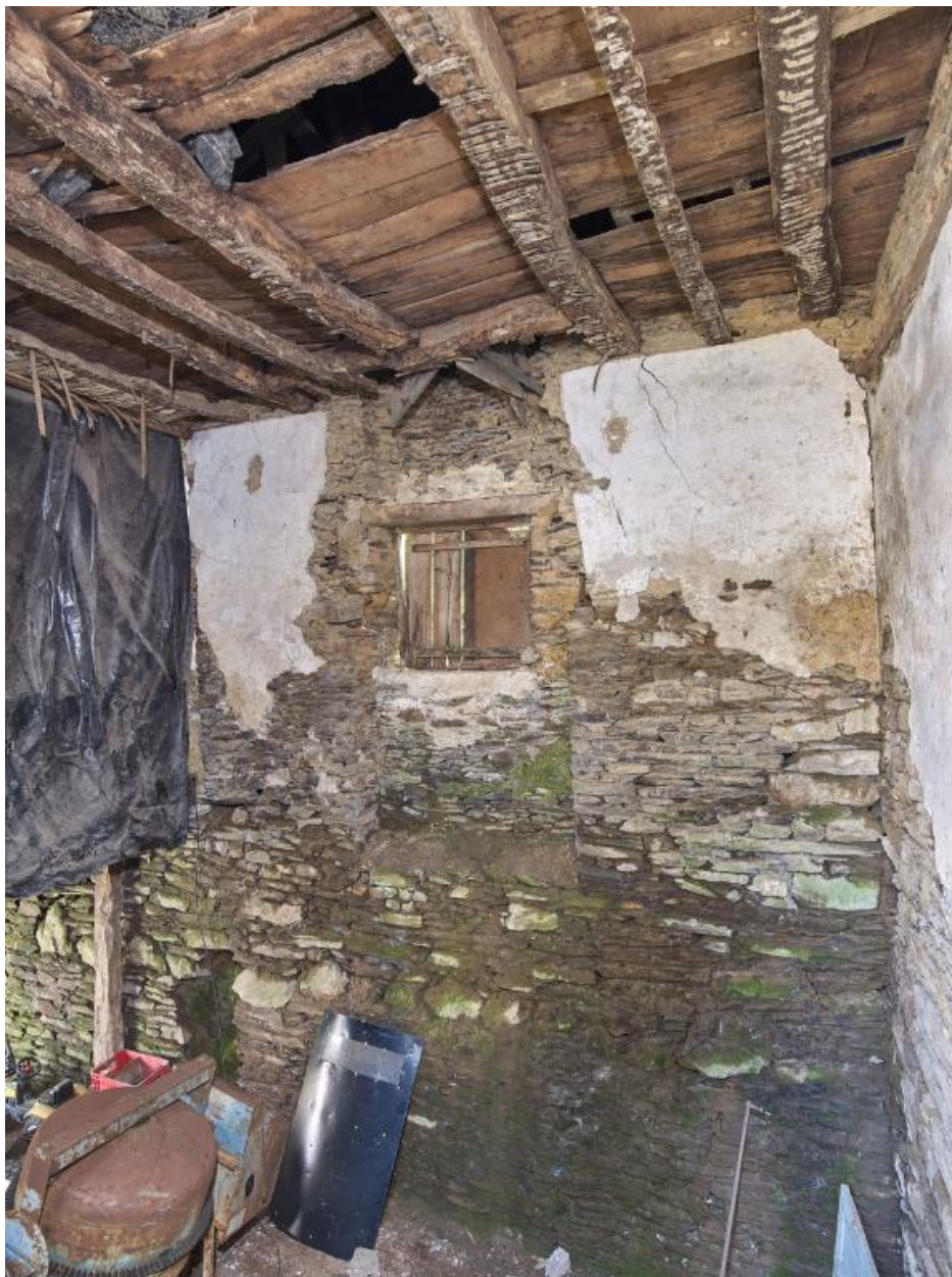
Sècherie. Partie fermée au sud. Détail de la porte bouchée ouvrant autrefois sur la route qui mène au bourg de Saint-Thélo.
