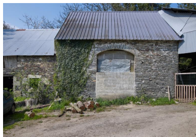
Remise nord-ouest à haute porte charretière. Façade est. Phot. Bernard Bègne IVR53_20232200173NUCA
