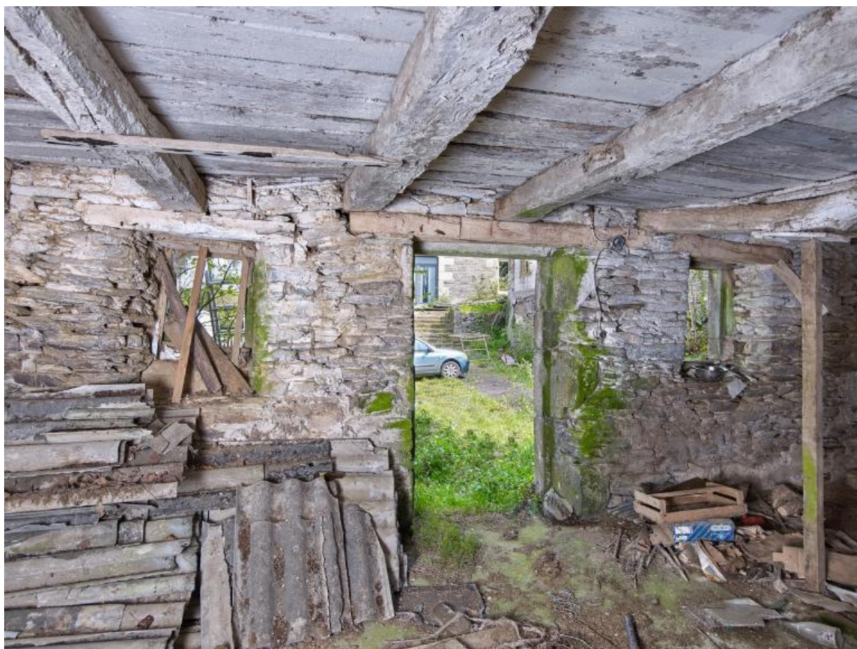
Logis sur dépendance construit en retour d'équerre de la sècherie. Vue intérieure du rez-de-chaussée.
