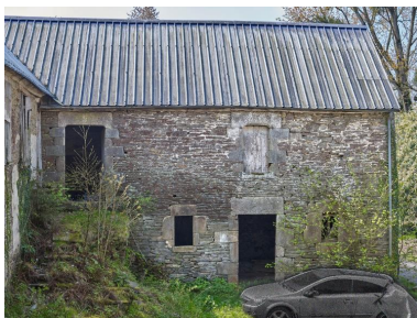
Logis sur dépendance construit en retour d'équerre de la sècherie, pour les ouvriers blanchisseurs. Façade nord. Phot. Bernard Bègne IVR53_20232200179NUCA
