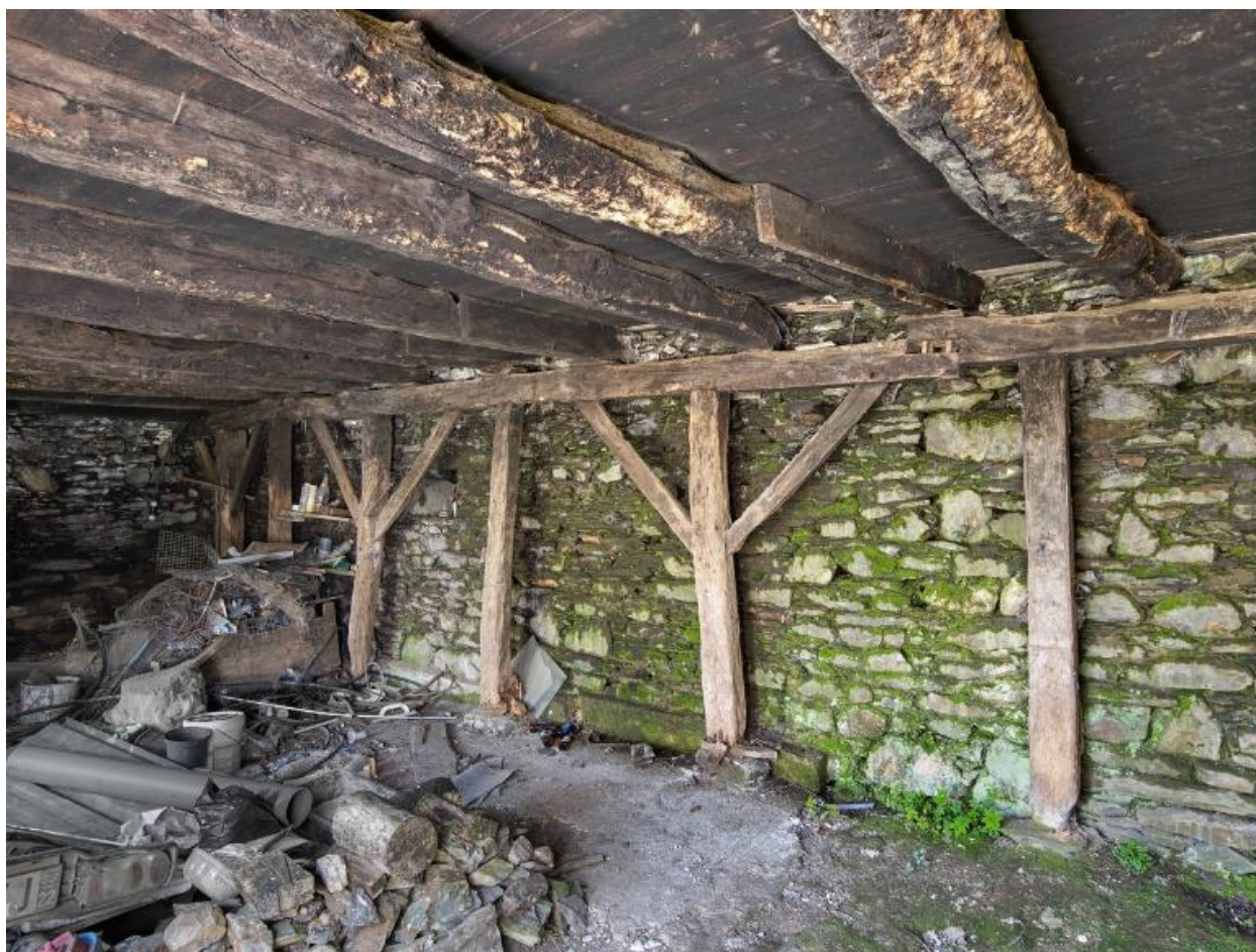
Remise sous la sècherie. Plafond constitué de solives soutenues par une sablière (assemblée à mi-bois) sur poteaux avec système de liens obliques pour affermir les angles par triangulation.
