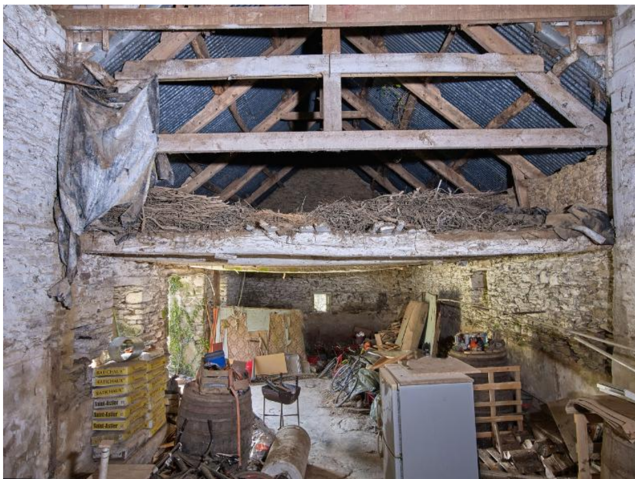
Intérieur de la remise sud-ouest. Vue prise depuis la remise nord-ouest avec laquelle elle communique.
