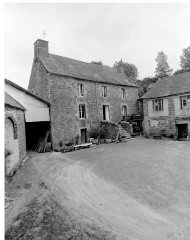
Maison de marchand reliée au bâtiment de la sècherie. Vue générale sud-ouest. Etat en 1996. Phot. Bernard Bègne IVR53_19962200469X
