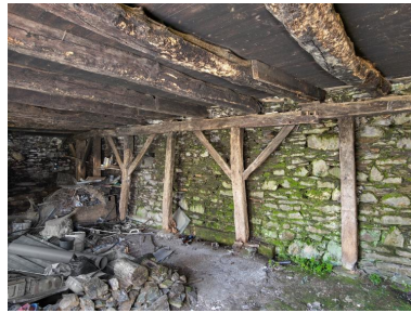
Remise sous la sècherie. Plafond constitué de solives soutenues par une sablière (assemblée à mi- bois) sur poteaux avec système de liens obliques pour affermir les angles par triangulation. Phot. Bernard Bègne IVR53_20232200195NUCA
