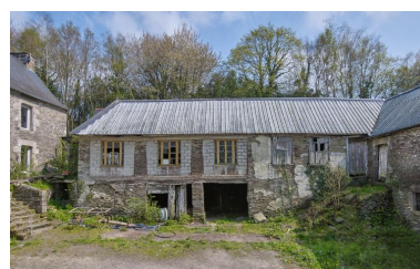
Dépendance fermant la cour à l'est : remise surmontée d'une sècherie. Vue générale ouest. Phot. Bernard Bègne IVR53_20232200188NUCA
