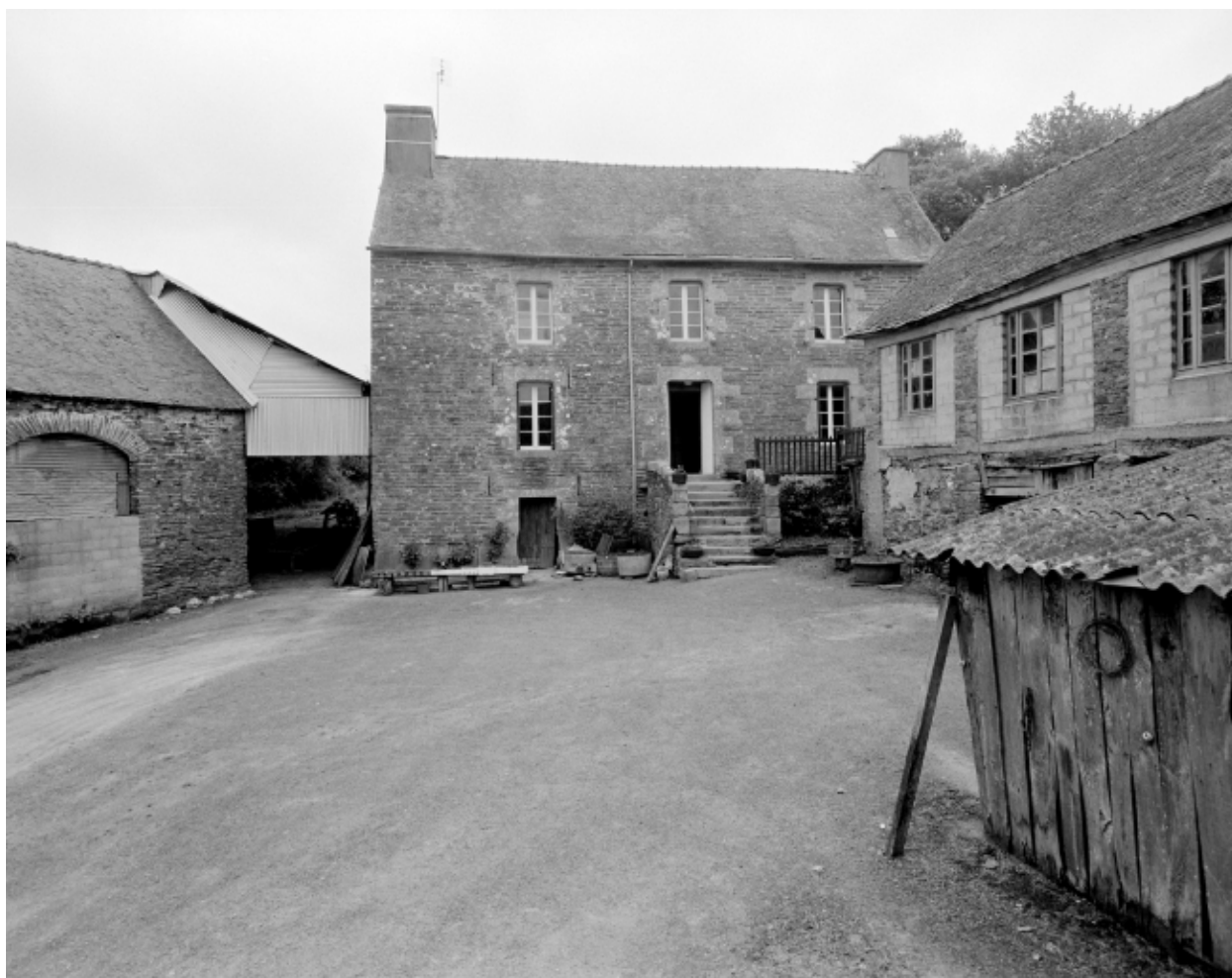
Maison de marchand et bâtiment de la sècherie construit perpendiculairement. Vue générale sud. Etat en 1996.
