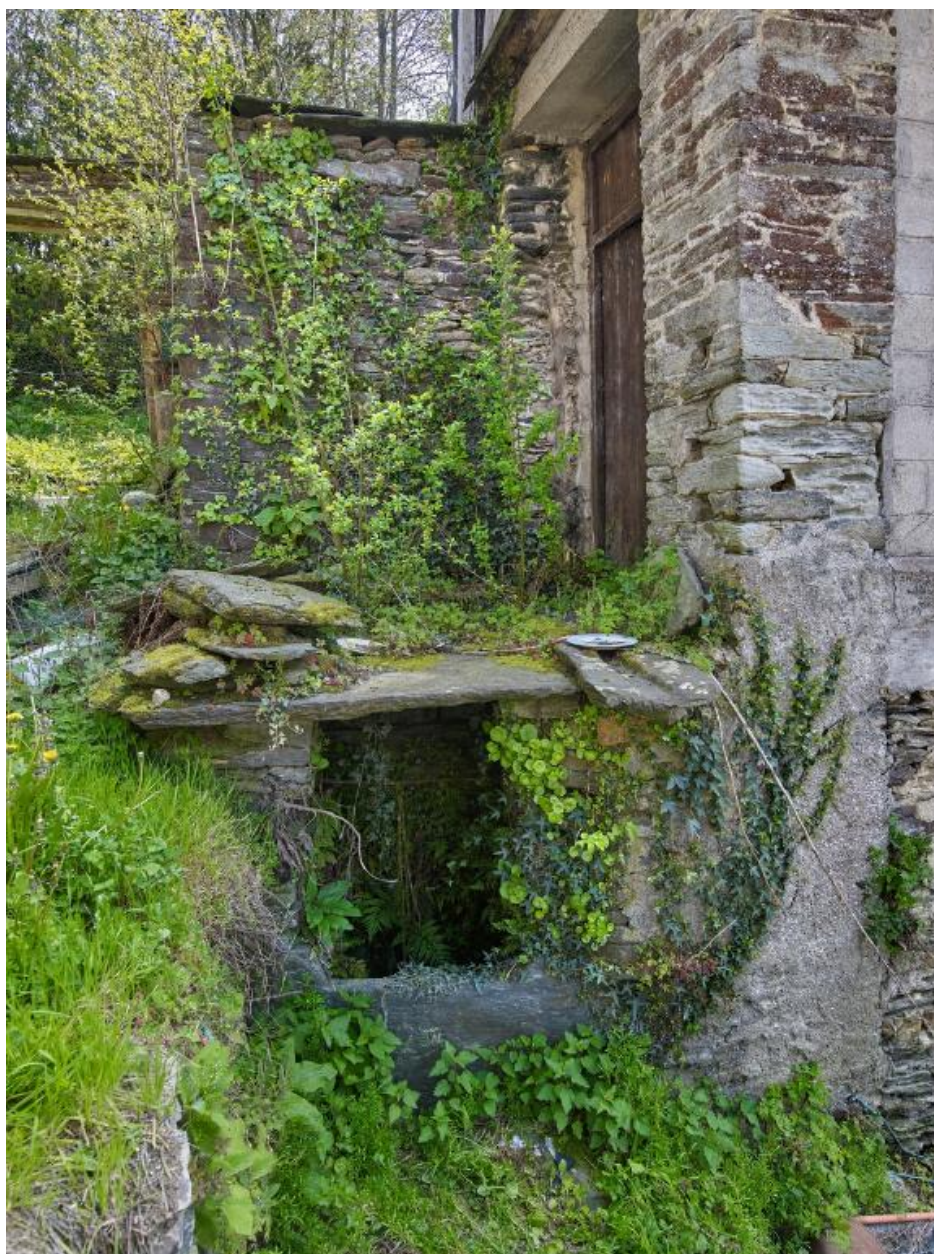
Puits aménagé entre la maison du marchand et le bâtiment de la sècherie. Vue ouest
