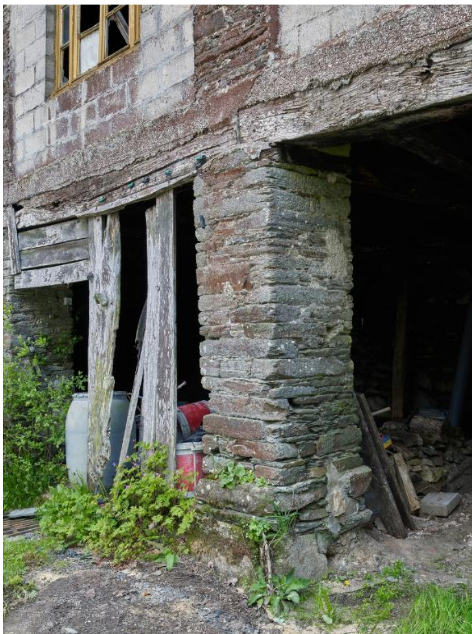
Remise sous la sècherie. Détail d'un pilier maçonné en schiste.
