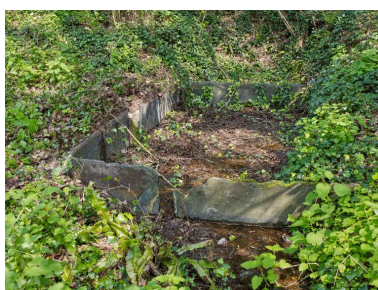
Lavoir. Détail d'un bassin. Phot. Bernard Bègne IVR53_20232200204NUCA
