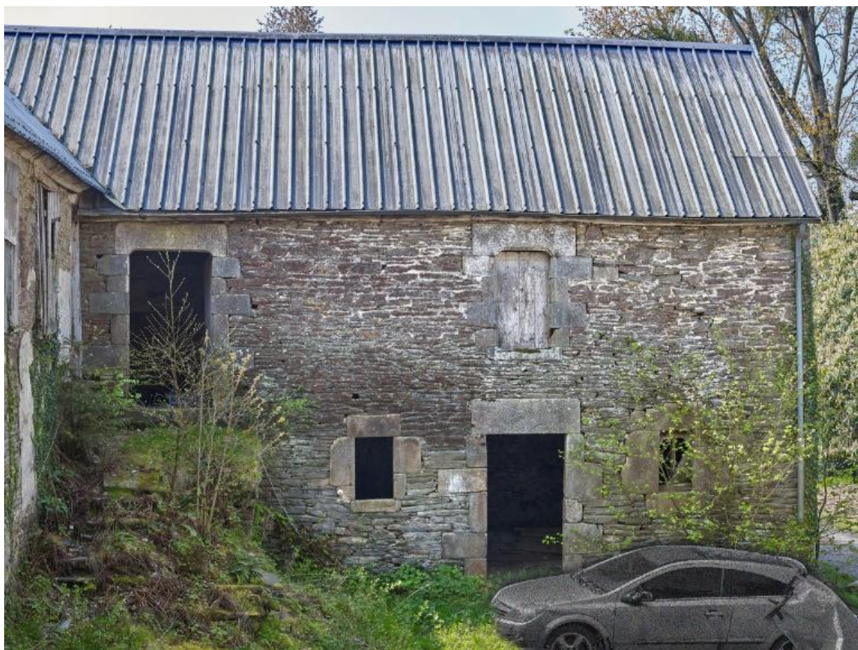
Logis sur dépendance construit en retour d'équerre de la sècherie, pour les ouvriers blanchisseurs. Façade nord.
