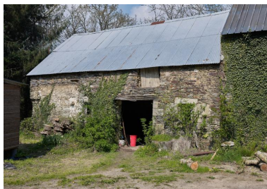
Remise sud-ouest à porte charretière. Façade est. Phot. Bernard Bègne IVR53_20232200170NUCA
