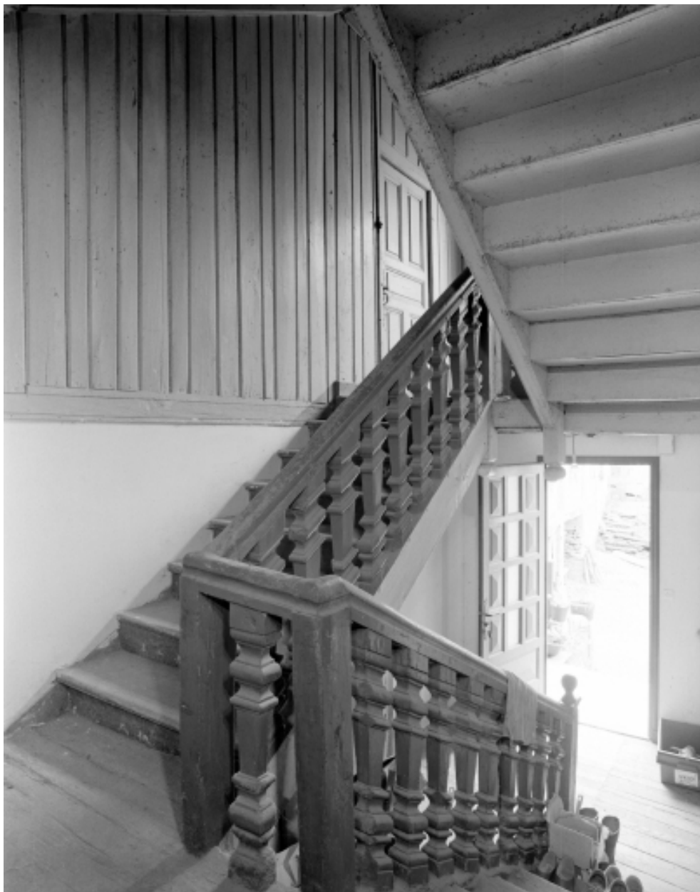
Maison de marchand. Escalier tournant à retours avec jour, en charpente. Etat en 1996
