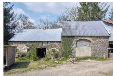
Remises fermant la cour à l'ouest : la remise sud-ouest est prolongée au nord par une seconde remise avec laquelle elle communique. Façades est. Phot. Bernard Bègne IVR53_20232200172NUCA
