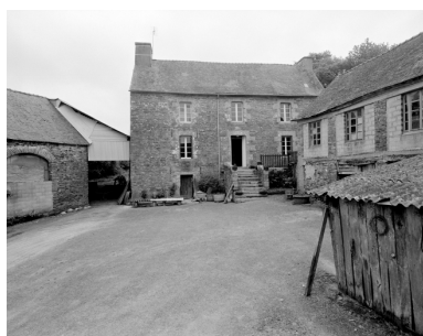
Maison de marchand et bâtiment de la sècherie construit perpendiculairement. Vue générale sud. Etat en 1996. Phot. Bernard Bègne IVR53_19962200470X
