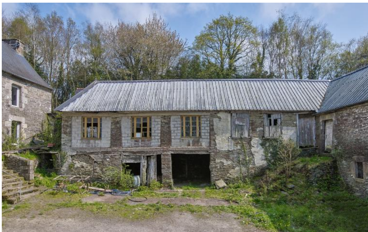
Dépendance fermant la cour à l'est : remise surmontée d'une sècherie. Vue générale ouest.
