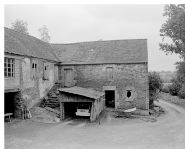
Logis sur dépendance construit en retour d'équerre de la sècherie : habitation d'ouvriers blanchisseurs ? Vue nord. Etat en 1996 Phot. Bernard Bègne IVR53_19962200468X
