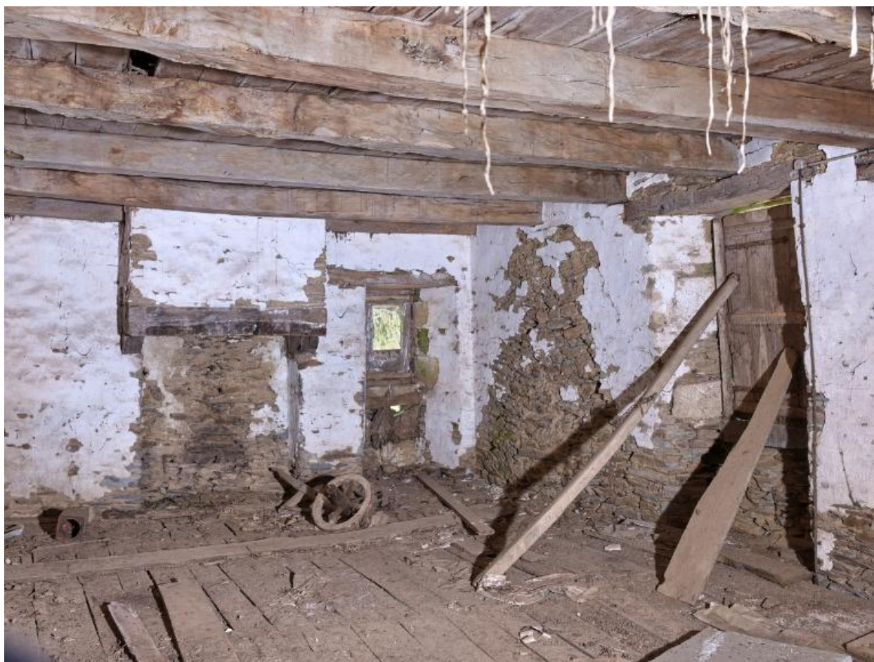
Logis sur dépendance construit en retour d'équerre de la sècherie. Vue intérieure du logis.
