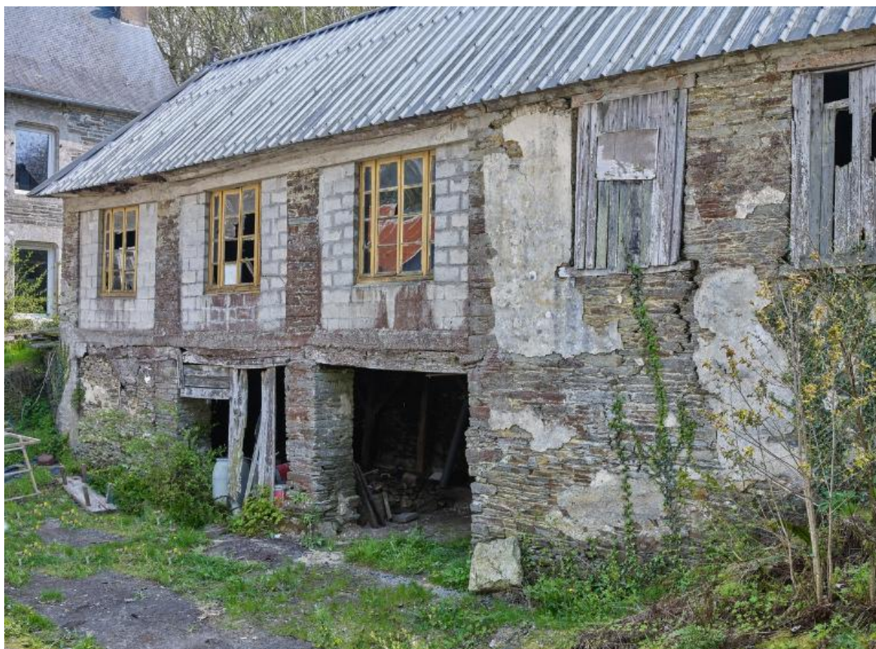
Dépendance fermant la cour à l'est : remise à piliers maçonnés, surmontée d'une sècherie dont les baies libres (partiellement bouchées par des parpaings) étaient fermées par des claires-voies en bois. Elévation ouest.
