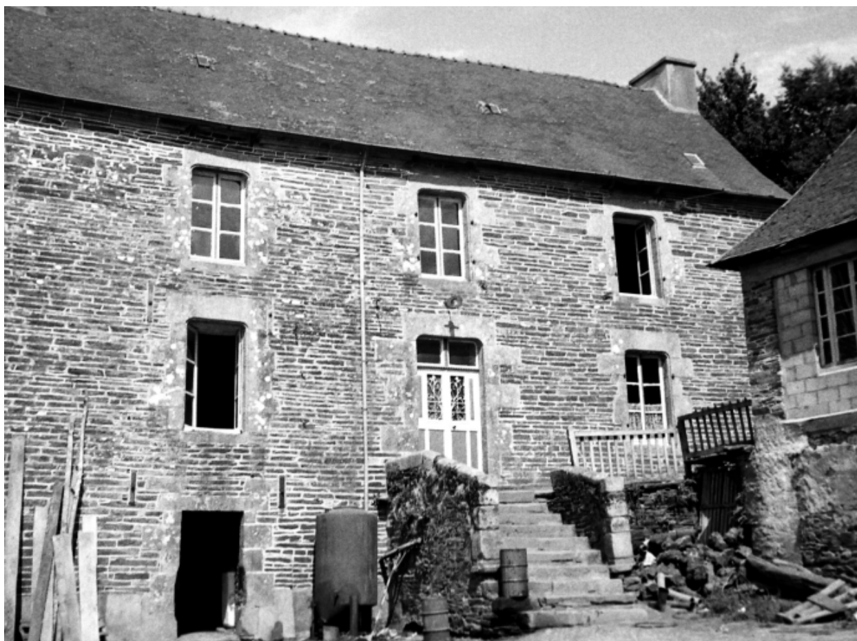
Maison de marchand. Façade sud. Etat en 1969.
