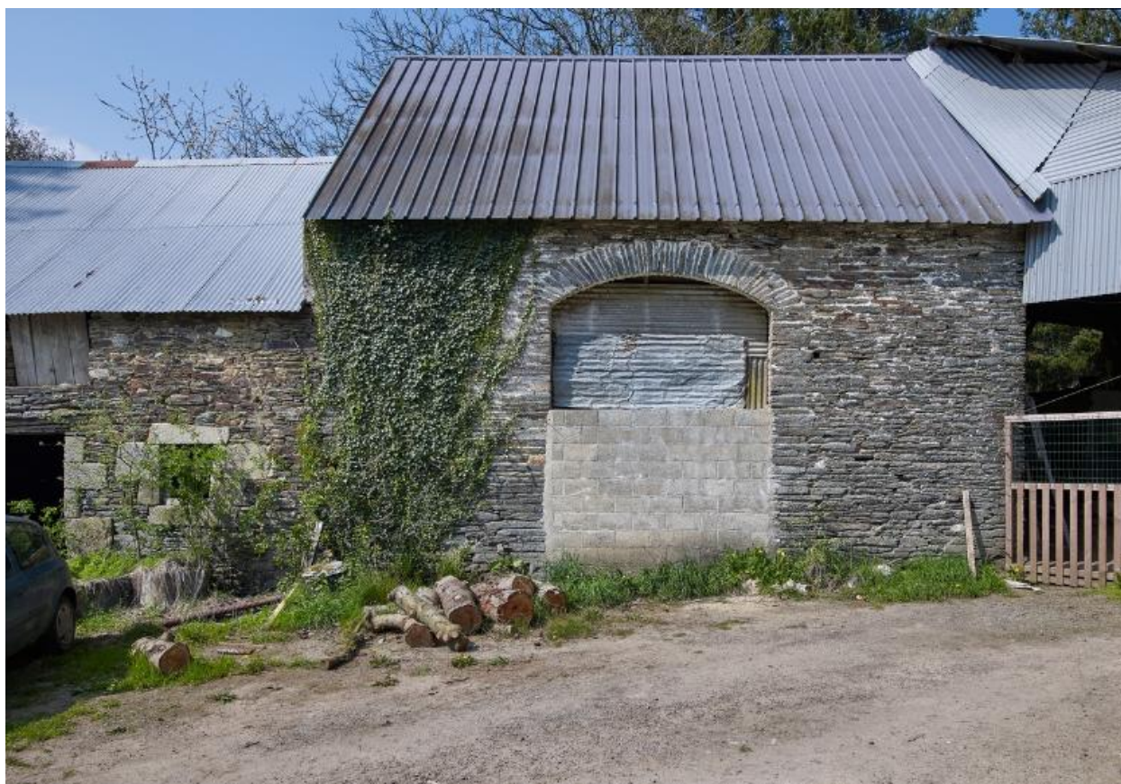
Remise nord-ouest à haute porte charretière. Façade est.
