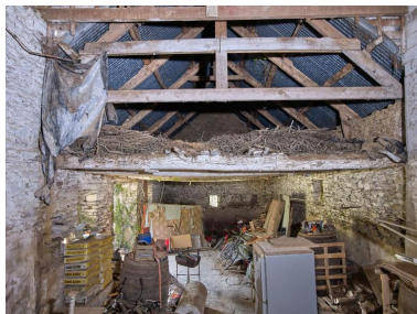
Intérieur de la remise sud-ouest. Vue prise depuis la remise nord-ouest avec laquelle elle communique. Phot. Bernard Bègne IVR53_20232200177NUCA
