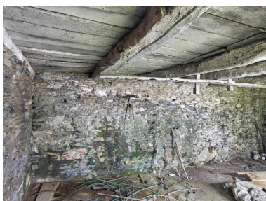
Logis sur dépendance construit en retour d'équerre de la sècherie. Vue intérieure du rez-de-chaussée. Phot. Bernard Bègne IVR53_20232200183NUCA
