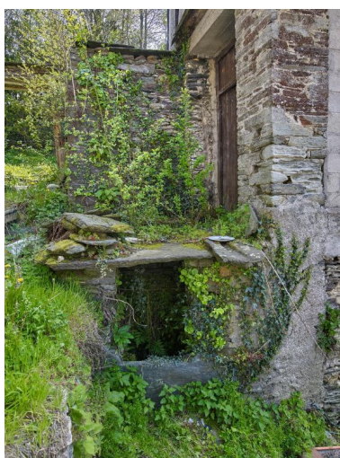
Puits aménagé entre la maison du marchand et le bâtiment de la sècherie. Vue ouest Phot. Bernard Bègne IVR53_20232200196NUCA
