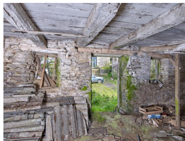
Logis sur dépendance construit en retour d'équerre de la sècherie. Vue intérieure du rez-de-chaussée. Phot. Bernard Bègne IVR53_20232200184NUCA
