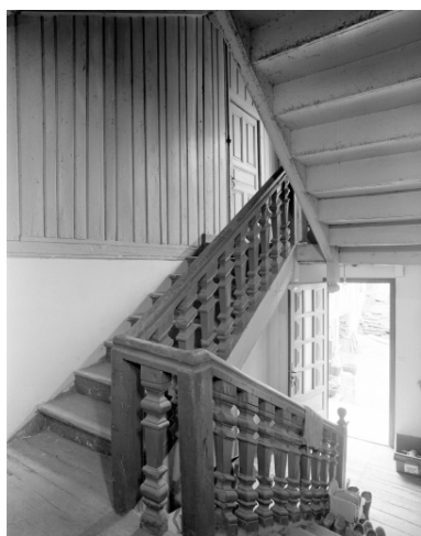
Maison de marchand. Escalier tournant à retours avec jour, en charpente. Etat en 1996 Phot. Bernard Bègne IVR53_19962200467X
