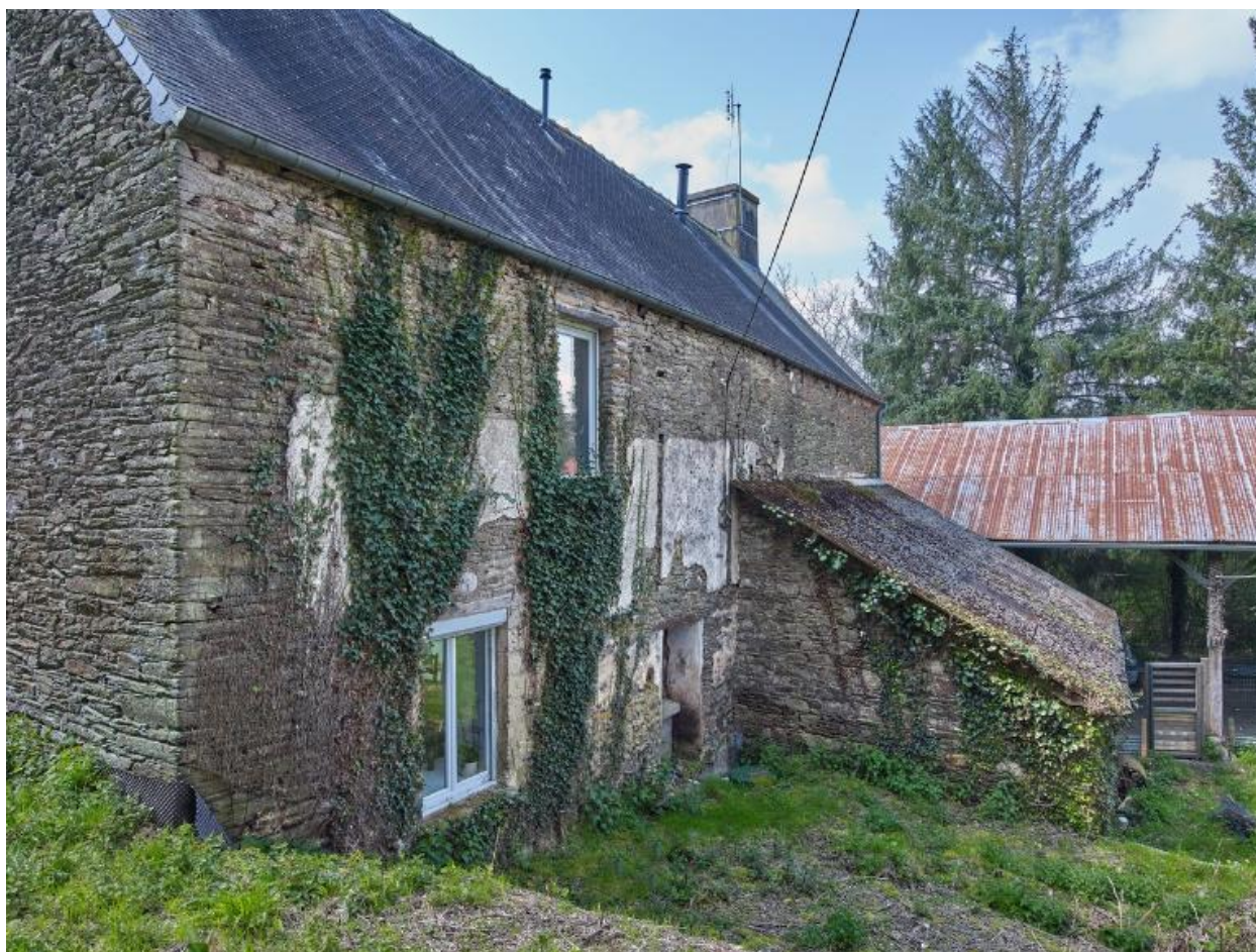
Maison de marchand. Façade nord avec appentis à usage de cellier.
