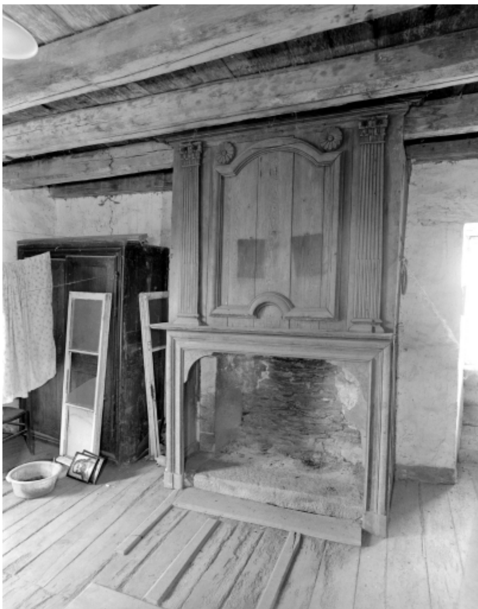
Maison de marchand. Cheminée de l'étage. Etat en 1996
