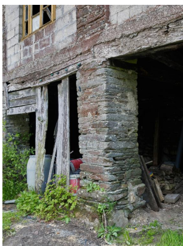
Dépendance fermant la cour à l'est : remise à piliers maçonnés, surmontée d'une sècherie dont les baies libres (partiellement bouchées par des parpaings) étaient fermées par des claires-voies en bois. Elévation ouest. Phot. Bernard Bègne IVR53_20232200193NUCA
