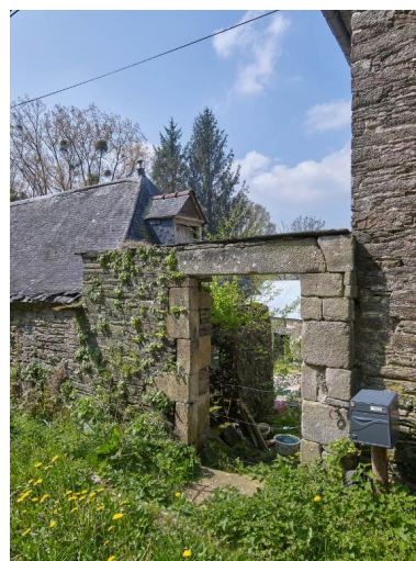
Entrée secondaire, côté route, entre la maison et la sècherie. Phot. Bernard Bègne IVR53_20232200198NUCA
