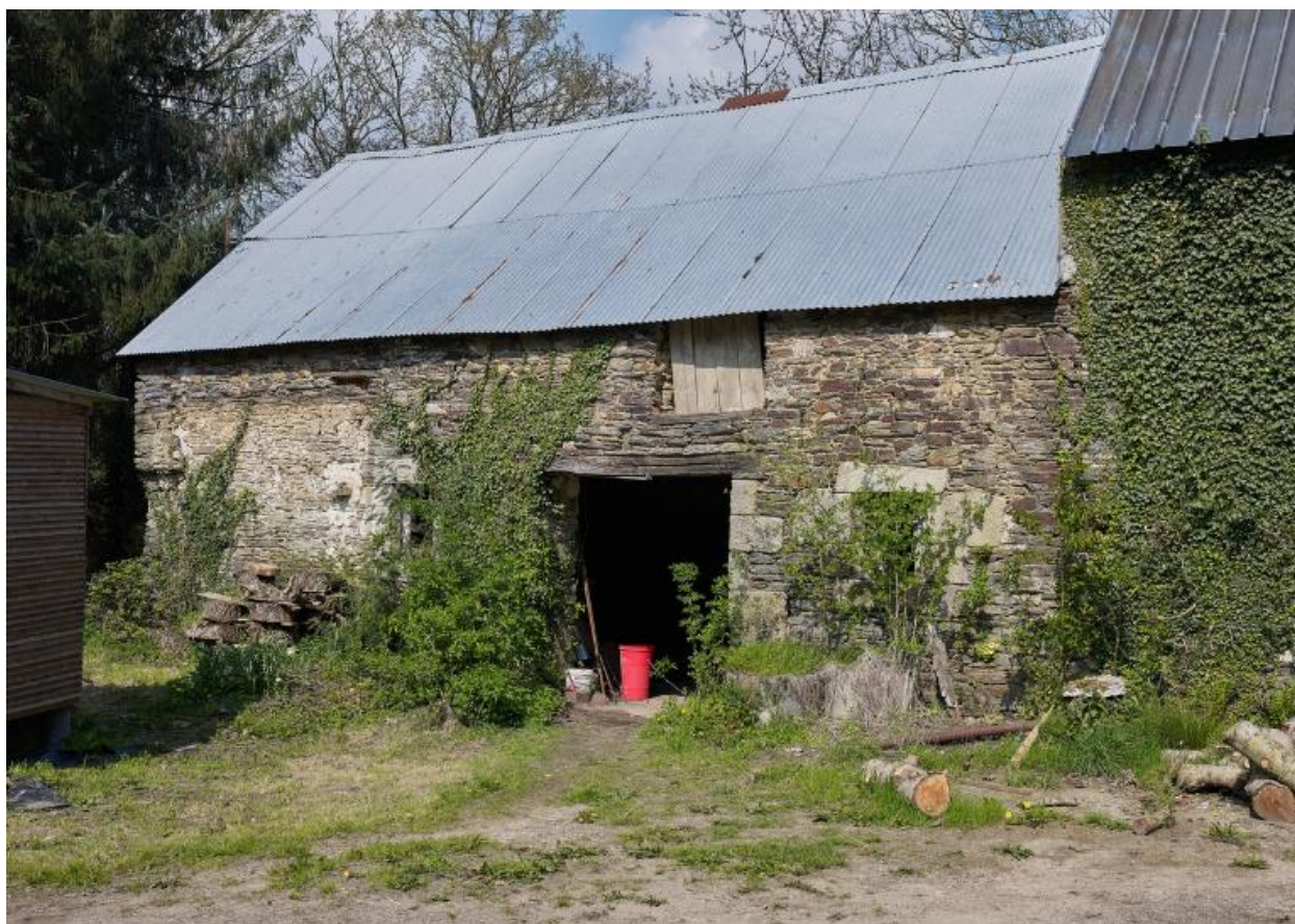
Remise sud-ouest à porte charretière. Façade est.
