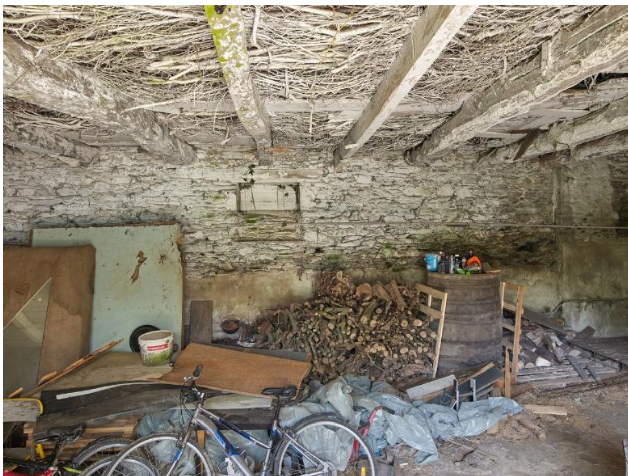
Remise sud-ouest. Vue intérieure du rez-de-chaussée et son plafond isolé avec des branchages.
