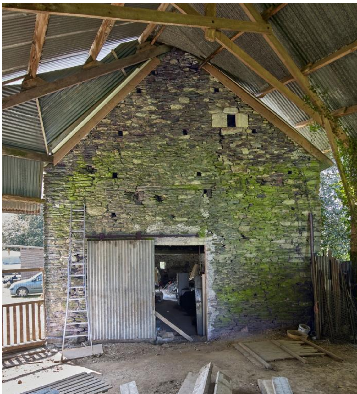
Remise nord-ouest. Pignon nord avec consoles et linteau de cheminée à l'étage en surcroît, porte moderne au rez-de-chaussée.
