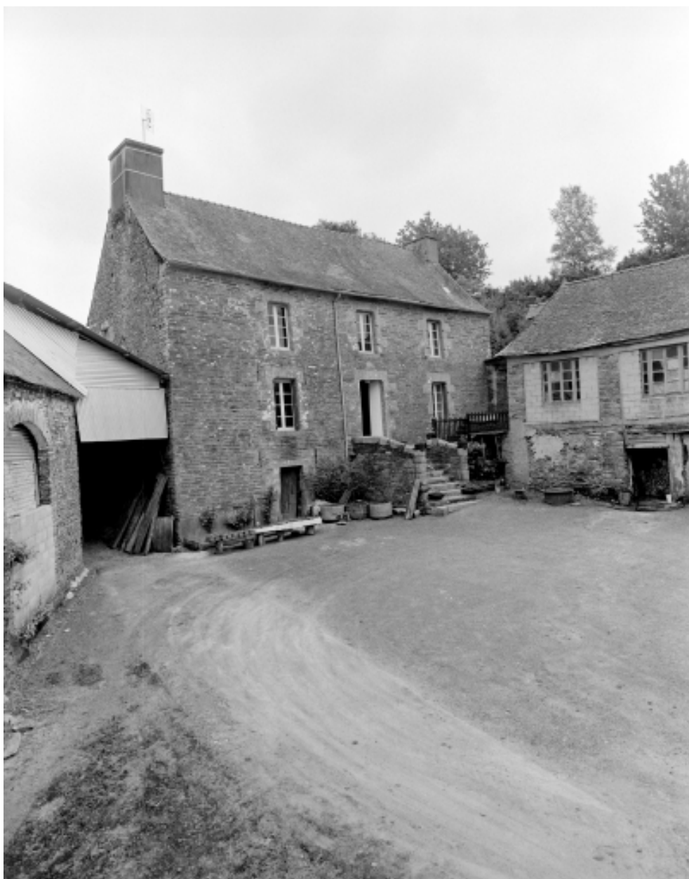
Maison de marchand reliée au bâtiment de la sècherie. Vue générale sud-ouest. Etat en 1996.
