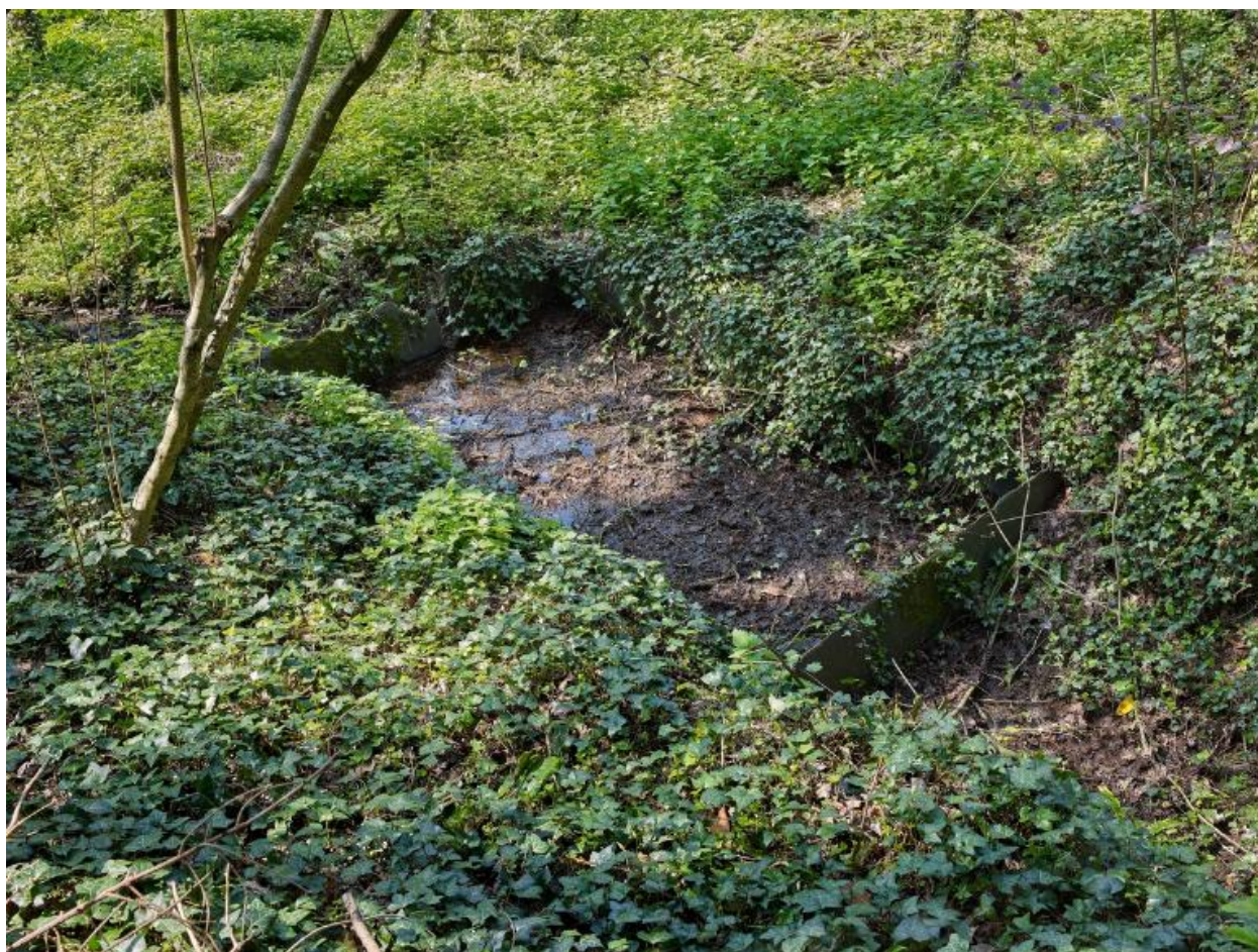
Lavoir divisé en deux bassins, construit en palis de schiste posés sur chant. Vue générale
