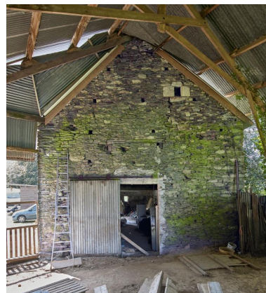
Remise nord-ouest. Pignon nord avec consoles et linteau de cheminée à l'étage en surcroît, porte moderne au rez-de-chaussée. Phot. Bernard Bègne IVR53_20232200178NUCA
