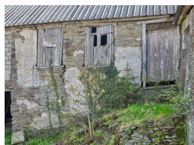
Partie fermée de la sècherie avec accès par l'extérieur, depuis l'escalier qui dessert le logis sur dépendance des ouvriers blanchisseurs. Phot. Bernard Bègne IVR53_20232200192NUCA
