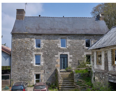
Maison de marchand. Façade sud. Phot. Bernard Bègne IVR53_20232200168NUCA
