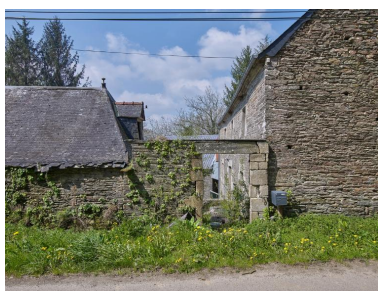
Entrée secondaire, côté route, entre la maison du marchand et la sècherie. L'entrée donne sur le terre-plein qui relie les deux bâtiments. Phot. Bernard Bègne IVR53_20232200199NUCA
