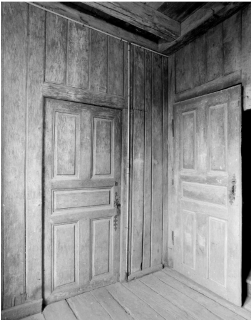
Maison de marchand. Portes et cloisons en bois de l'étage. Etat en 1996
