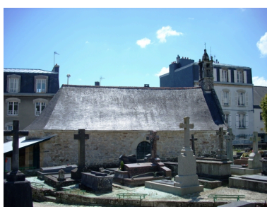
Quimper, chapelle Saint-Marc : élévation nord Phot. Gwénaél Fauchille IVR53_20082906408NUCA
