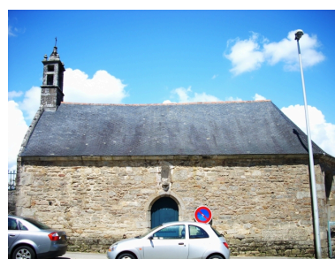
Quimper, chapelle Saint-Marc : élévation sud Phot. Gwénaél Fauchille IVR53_20082906409NUCA
