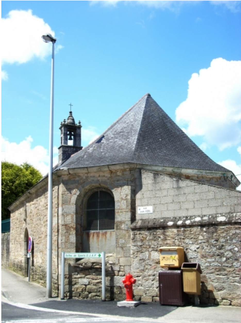
Quimper, chapelle Saint-Marc : vue générale sud-est
