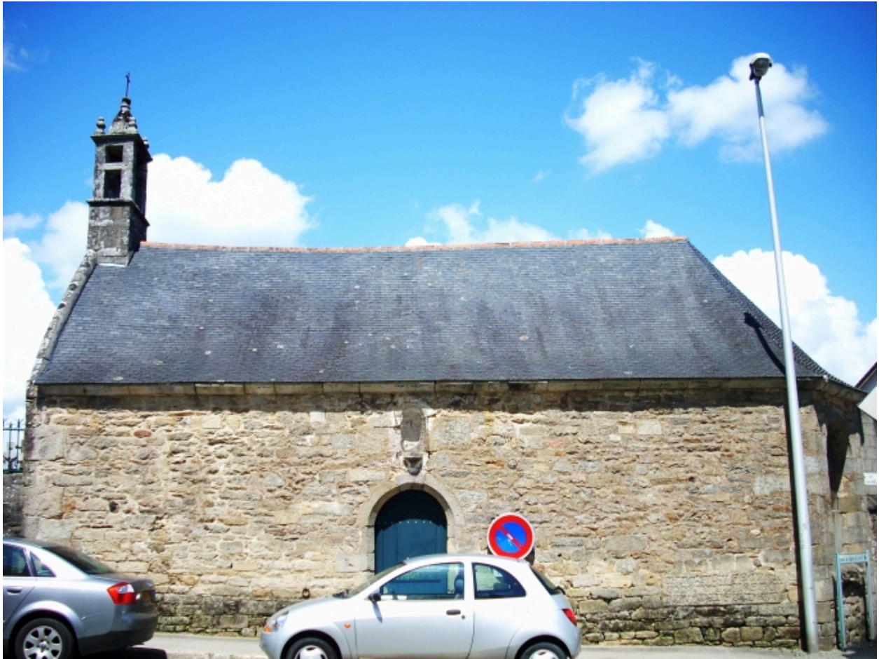
Quimper, chapelle Saint-Marc : élévation sud
