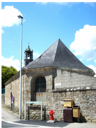
Quimper, chapelle Saint-Marc : vue générale sud-est Phot. Gwénaél Fauchille IVR53_20082906410NUCA
